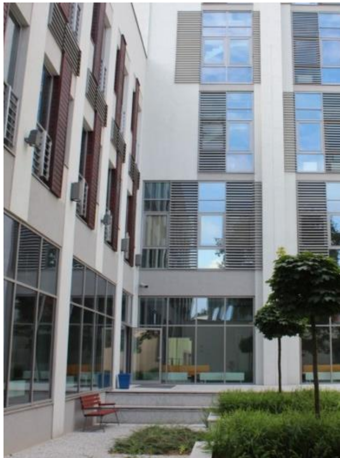
Rys. 3. Widok na budynek U i W od strony patio
