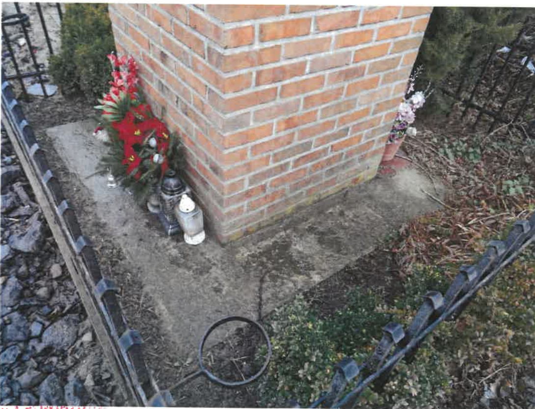
9. Betonowa płyta fundamentowa, widoczna w poziomie terenu.
