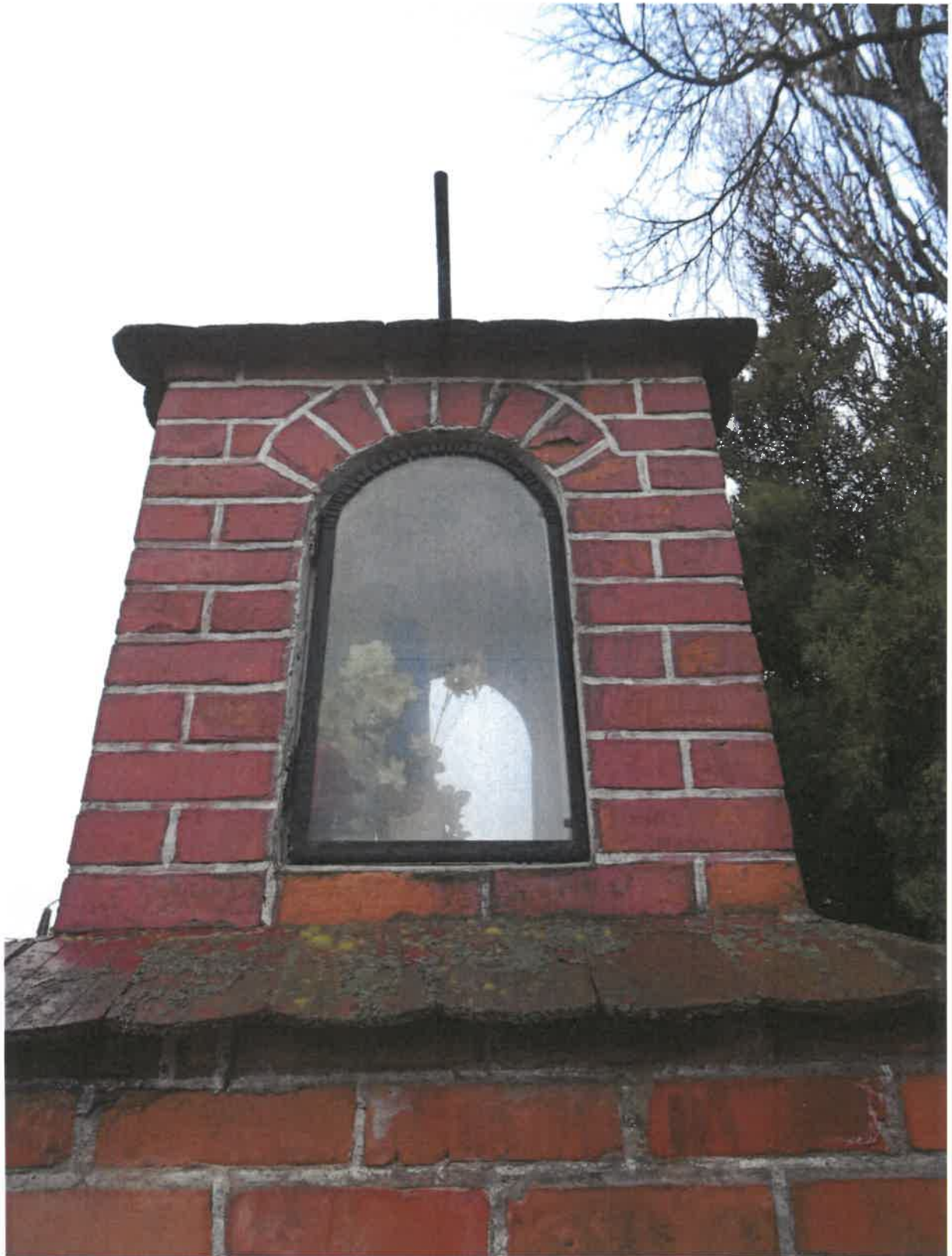
10. Otwierane okienko w II kondygnacji kapliczki, w elewacji południowej.
