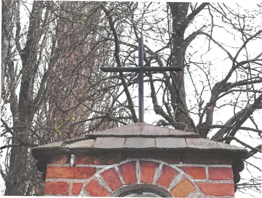
11. Dach z ceramicznej karpówki układanej na zaprawie oraz krzyż w zwieńczeniu.
