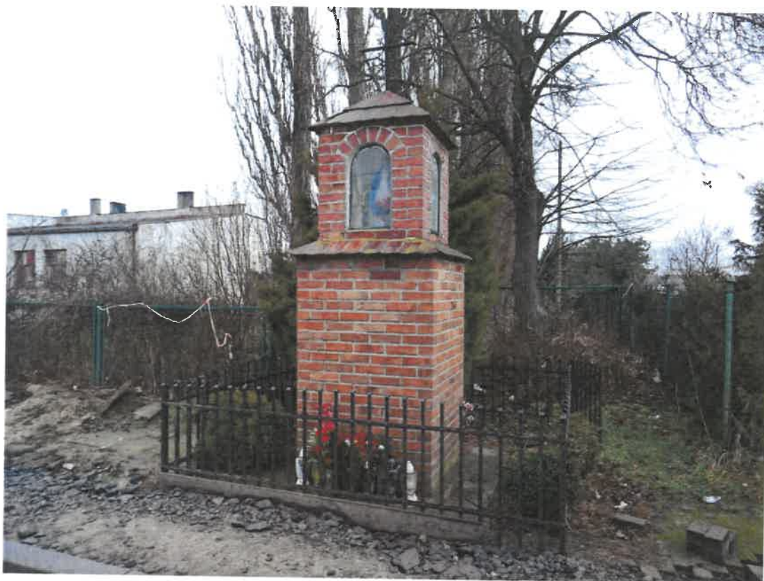
2. Elewacja zachodnia kapliczki - widok ogólny od strony drogi.
