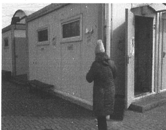
Fot. 15 Widok zaplecza sportowego kompleksu boisk( elewacja zachodnia)
