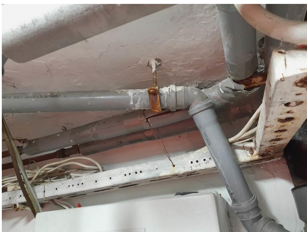
Fot. 4. Kanalizacja pod stropem do wymiany
