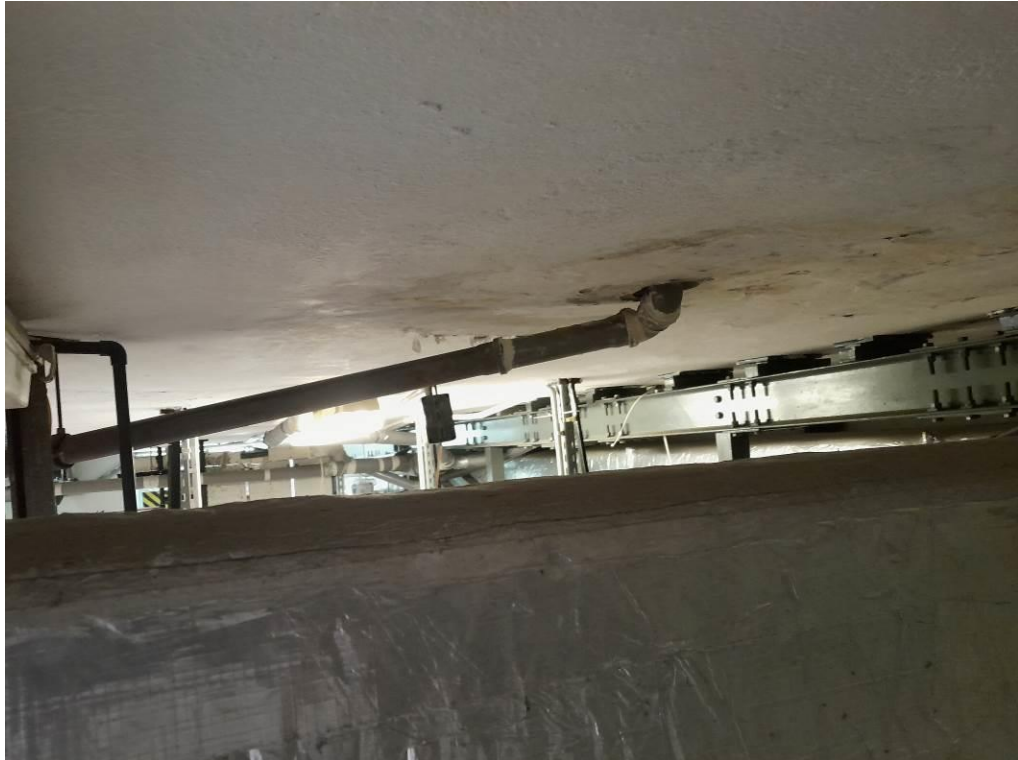
Fot. 5. Kanalizacja pod stropem do wymiany
