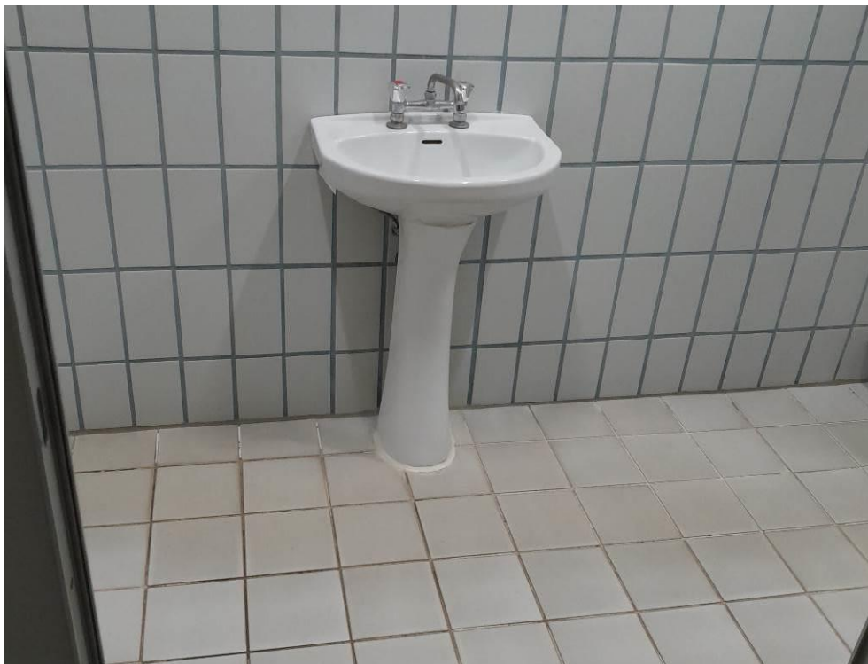
Fot. 1. Umywalka do wymiany na wiszącą wraz z przyborami sanitarnymi
