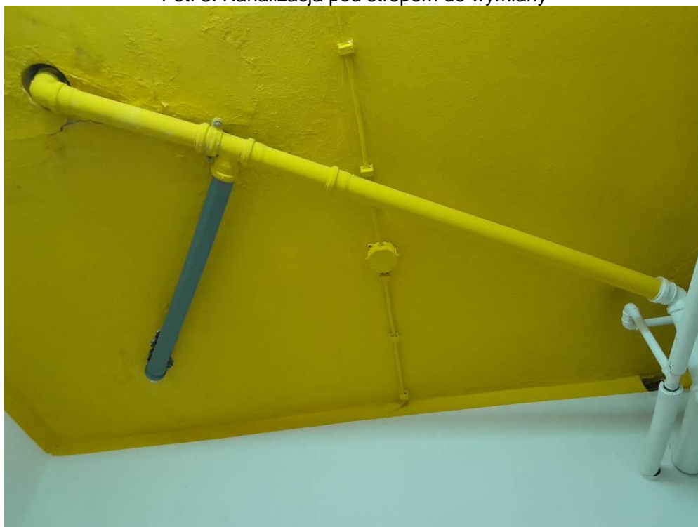
Fot. 3. Kanalizacja pod stropem do wymiany
