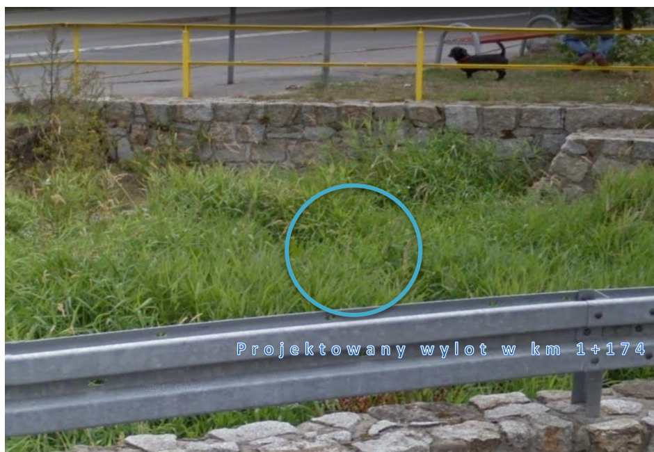
Ilustracja 2. Widok na istniejący mur oporowy w którym projektowany jest wylot DN800.
