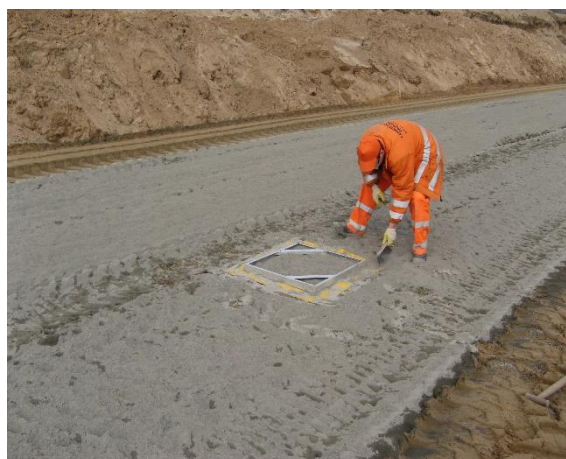
Wymiatanie z tacki pomiarowej cementu znajdującego się poza szablonem
