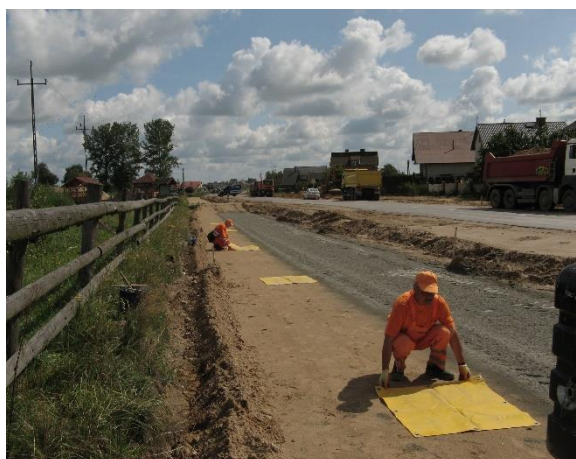
Rozmieszczenie tacek pomiarowych
