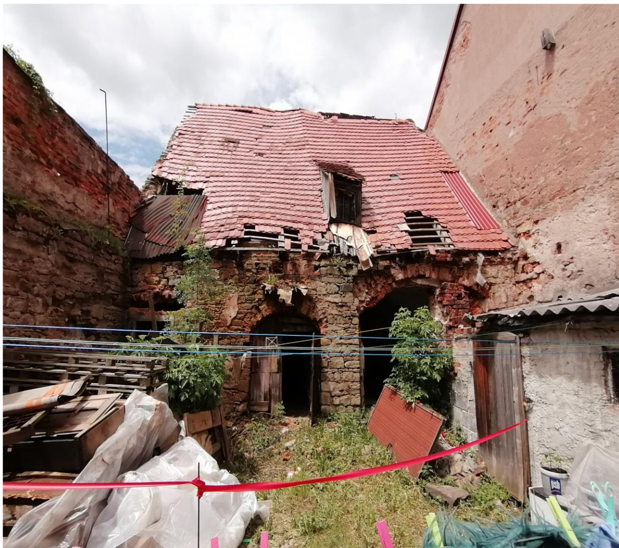
fot. nr 1. Elewacja frontowa
