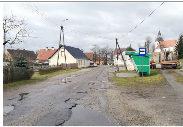
Istniejąca nawierzchnia asfaltowa ułożona na brukowcu
