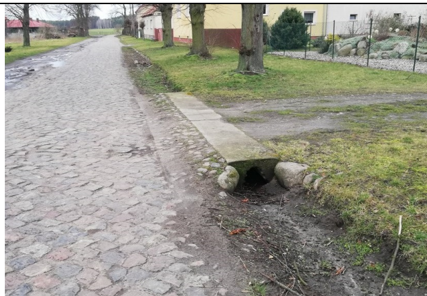
Istniejący przepust pod zjazdem
