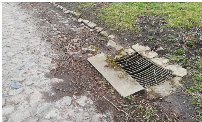
Istniejące wpusty deszczowe
