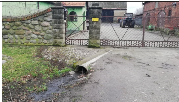
Nieuprawniony zrzut wody z posesji prywatnych do odwodnienia drogowego
