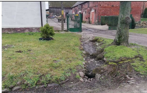
Nieuprawniony zrzut wody z posesji prywatnych do odwodnienia drogowego
