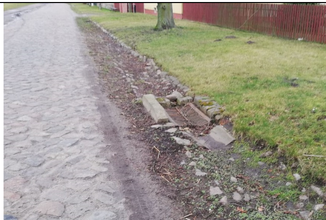
Istniejące wpusty deszczowe
