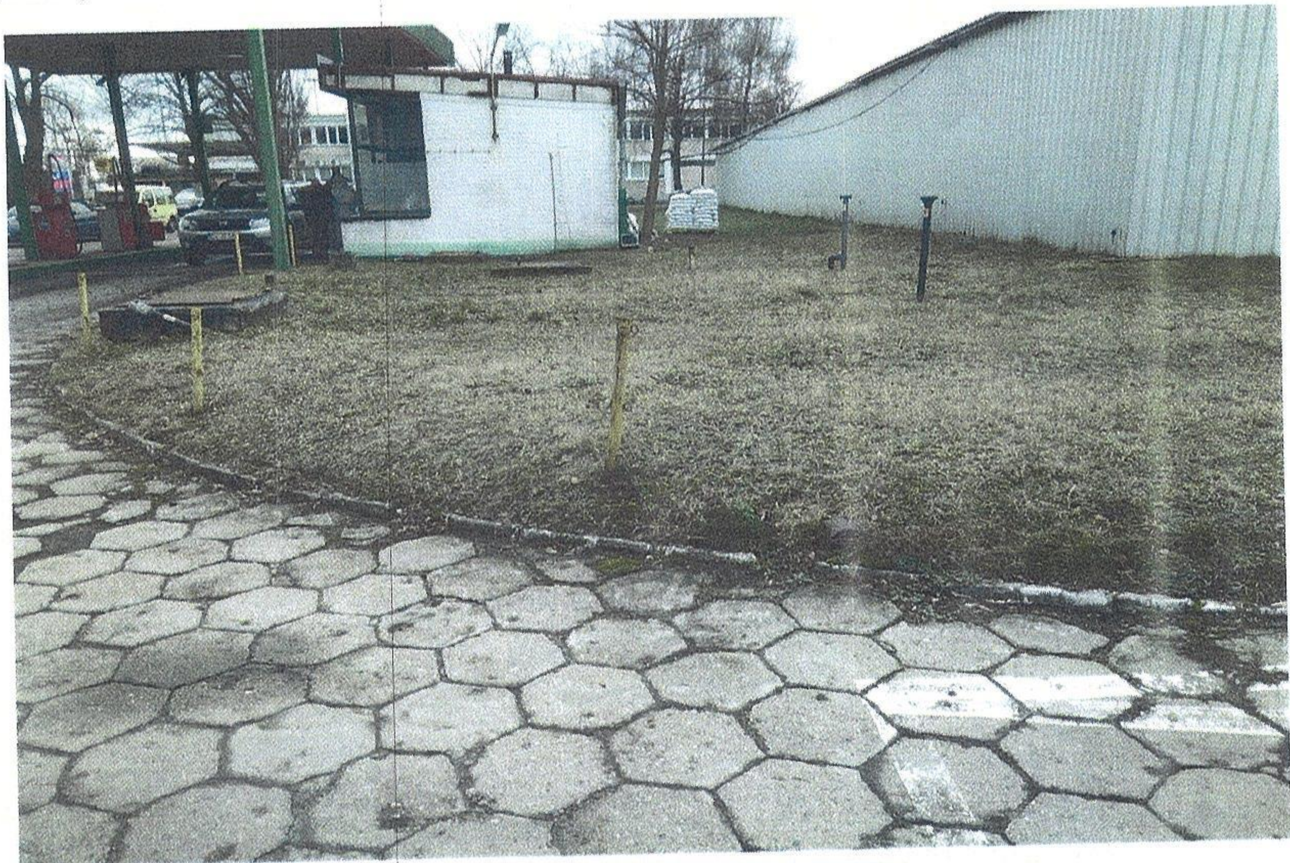
Zdjęcie nr 6. Miejsca posadowienia podziemnych zbiorników paliwowych wraz z oddechami oraz komorami spustowymi zbiorników.
