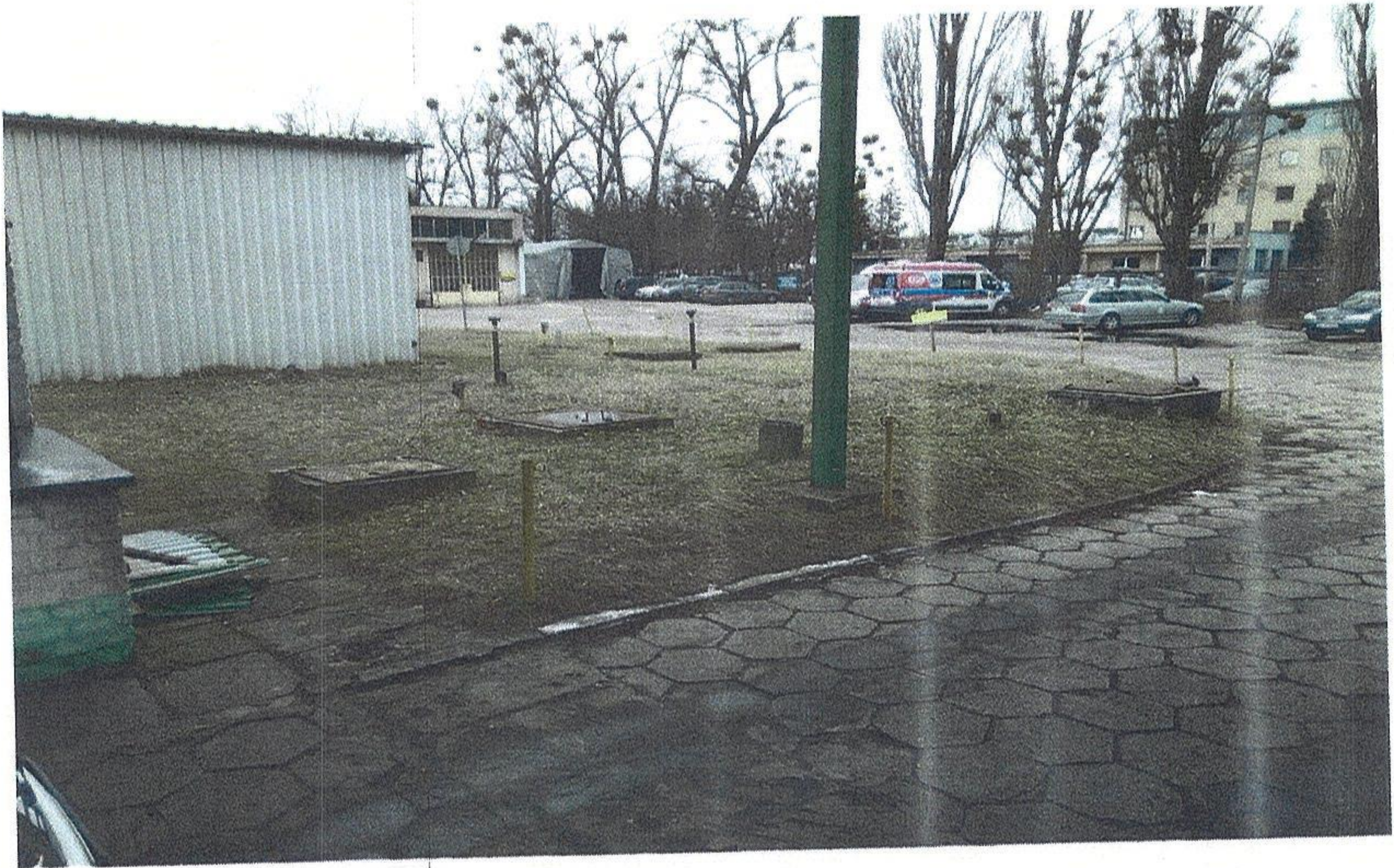
Zdjęcie nr 5. Cd widoku ze stacji paliw na miejsca posadowienia podziemnych zbiorników paliwowych wraz z oddechami oraz komorami spustowymi zbiorników.
