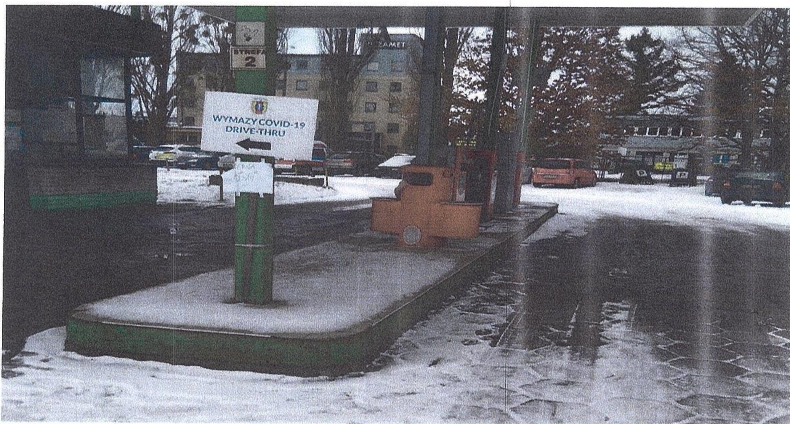
Zdjęcie nr 3. Widok wysepki centralnej z dystrybutorami oraz słupami zadaszenia wiaty.
