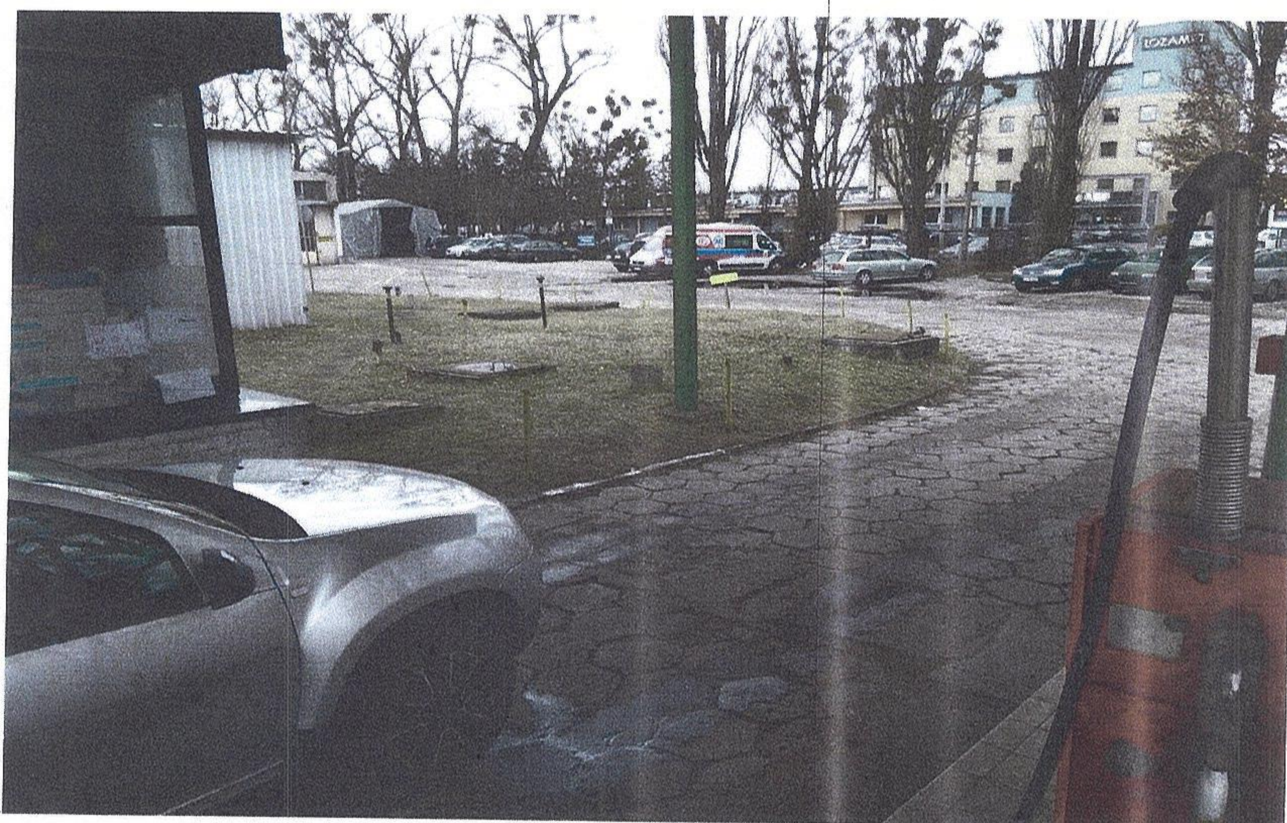
Zdjęcie nr 4. Widok ze stacji paliw na miejsca posadowienia podziemnych zbiorników paliwowych o pojemności zbiornik V=20\text{ m}^3 każdy.
