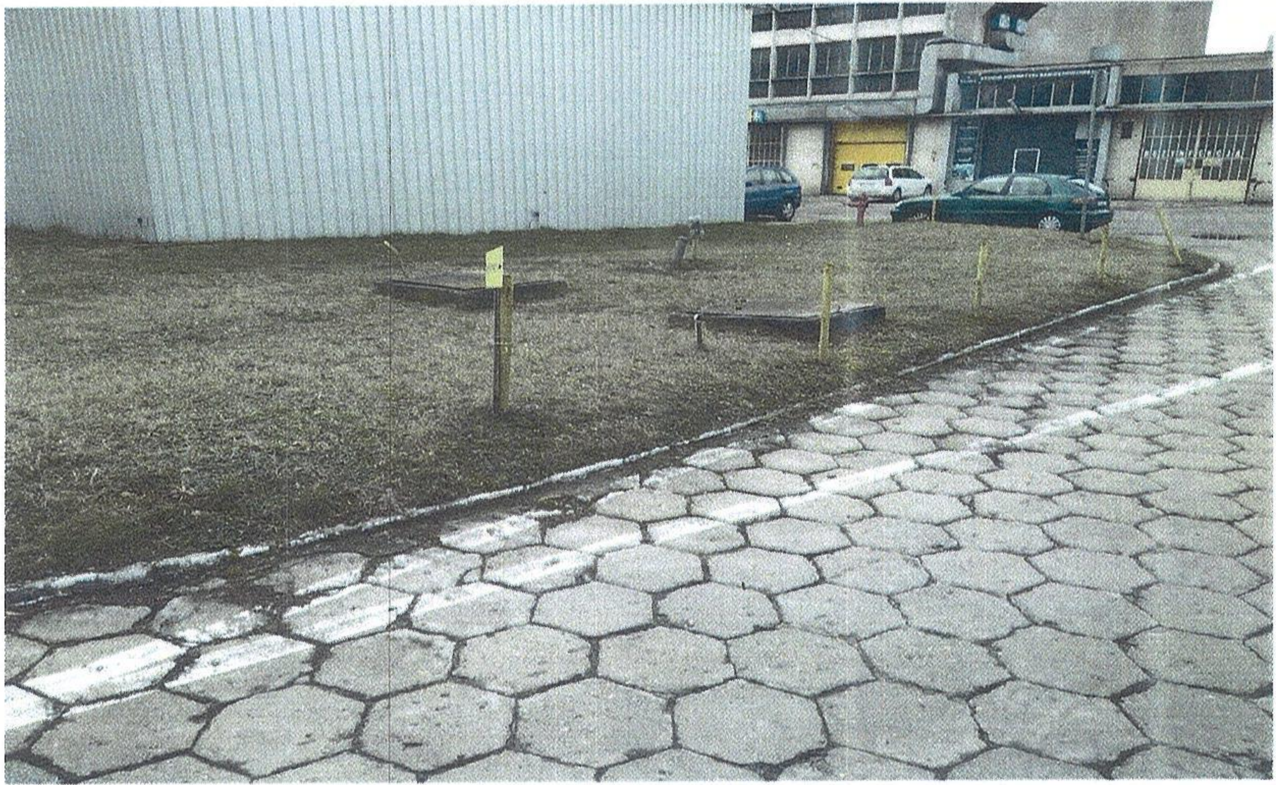
Zdjęcie nr 9. Miejsce posadowienia podziemnego zbiornika paliwowych wraz z oddechami oraz komorami spustowymi zbiorników – zbiornik V= 32 \text{ m}^3 .
