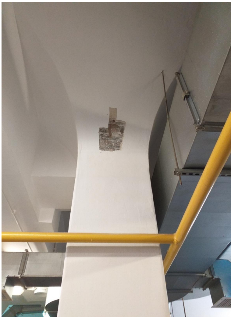
12. Kuchnia – widok odkrywki na słupie
