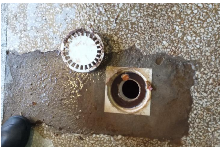
13. Pomieszczenie techniczne – wpust podłogowy
