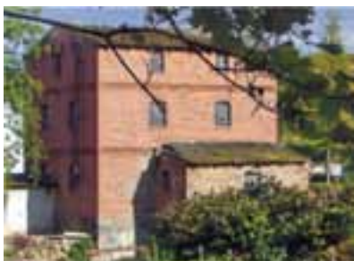
Kowalewko Folwark - młyn wodny na Dębogórskiej Strudze
