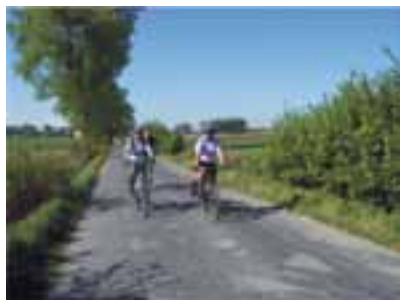
Odcinek drogi Trzciewnica - Gumnowice
