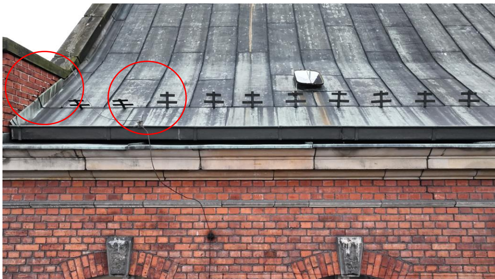
Fot.11 Należy sprawdzić szczelność opierzeń przy ścianach, wieży, na wszelkich elementach styku blachy z wątkiem ceglanym. Drabinki śniegowe do konserwacji.
