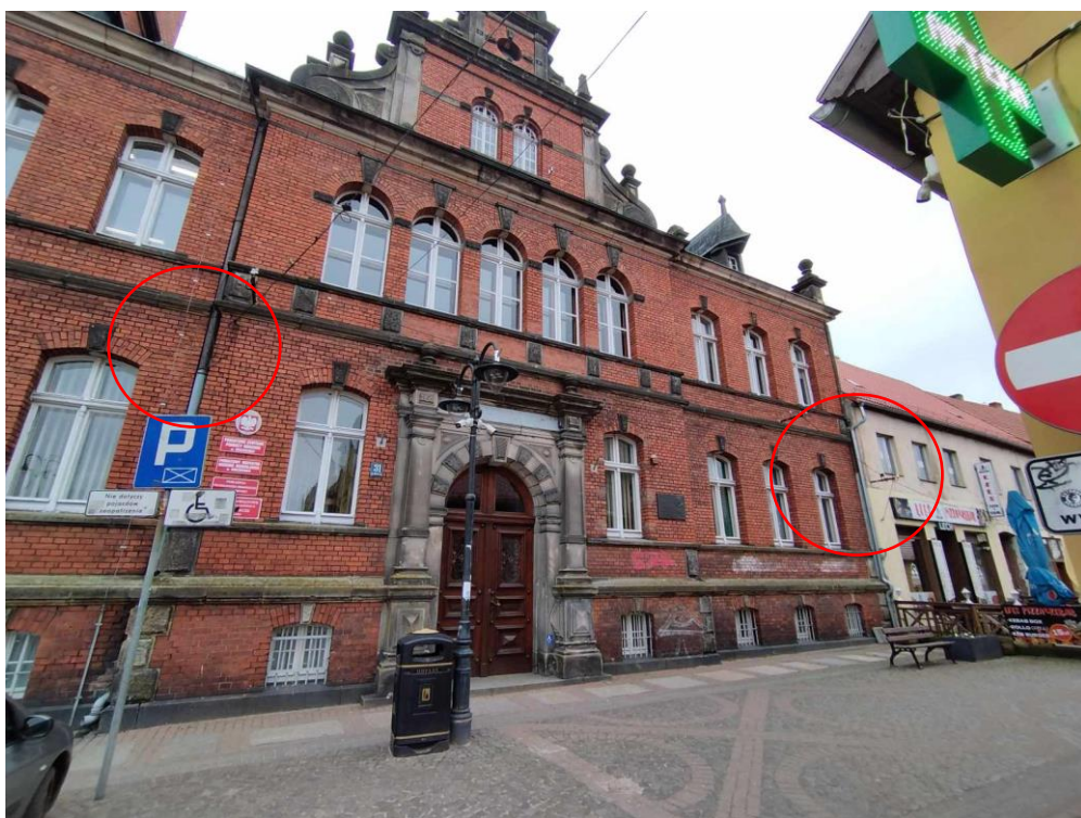
Fot.10 Rury spustowe- widoczne łączenia różnych materiałów
