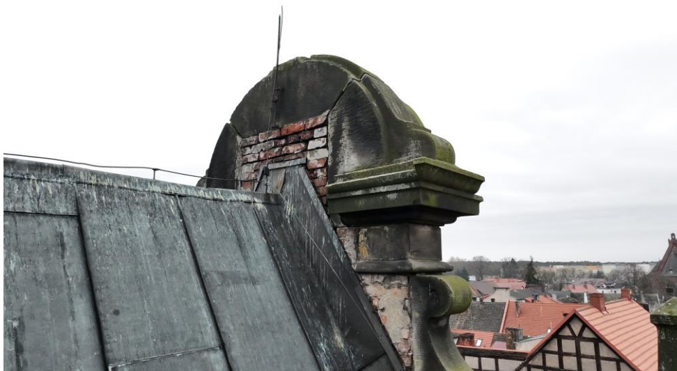
Fot.7 Widoczna nieszczelna obróbka przy ścianie szczytowej
