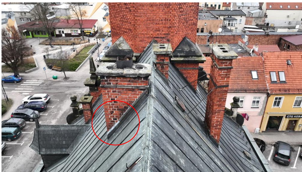
Fot.6 Należy sprawdzić szczelność obróbek blacharskich przy kominach
