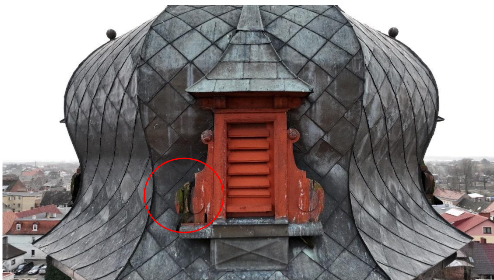
Fot.14 Widoczne zniszczone uszaki/ elementy drewniane
