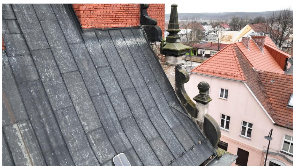
Fot. 12– Łączenie pokrycia dachu z wątkiem ceglany oraz detalami z piaskowca
