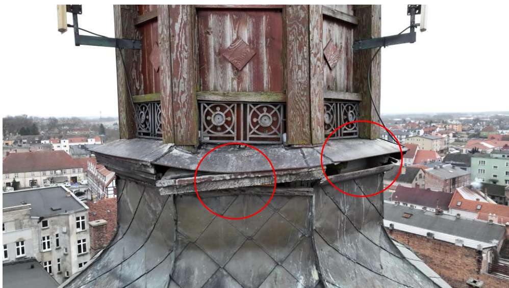
Fot.13 Braki elementów drewnianych
