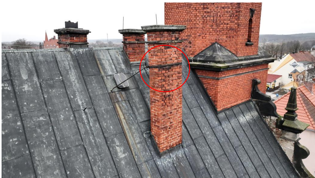
Fot.5 Widoczne wypłukane spoiny w kominach
