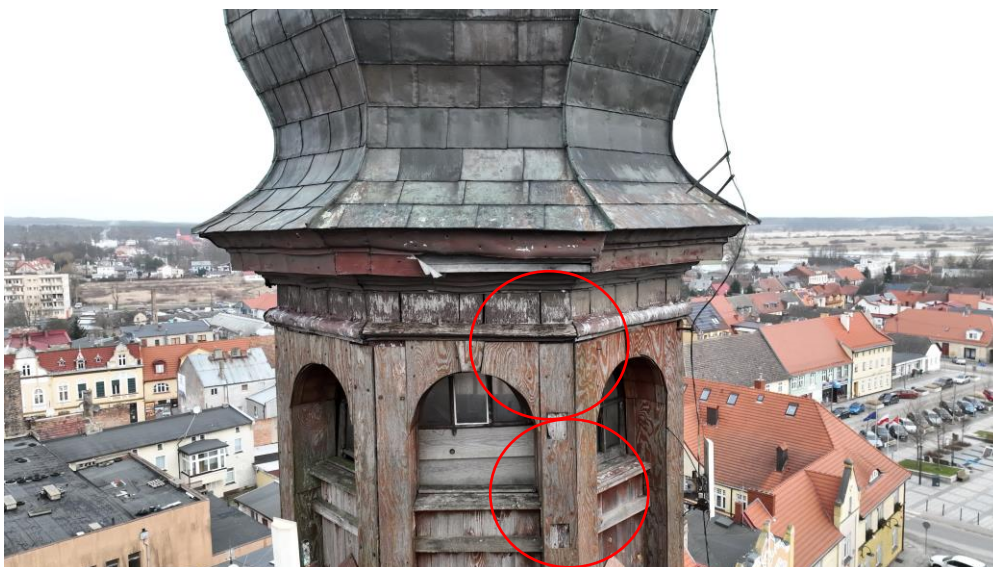
Fot.12 Widoczne zniszczenia konstrukcji drewnianej wieży, braki elementów
