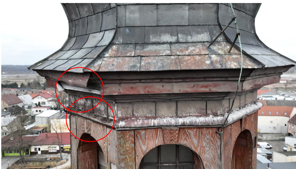
Fot.8 Widoczne braki opierzeń, odsłonięte elementy drewniane, narażone na działanie warunków atmosferycznych
