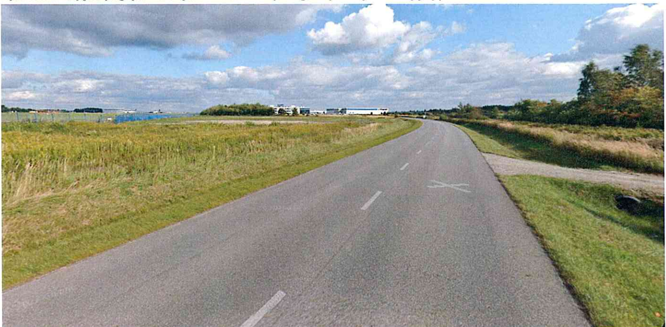
Rysunek 2. Zdjęcie poglądowe części infrastruktury drogowej strefy S1-3 objętej przedmiotem zamówienia.
