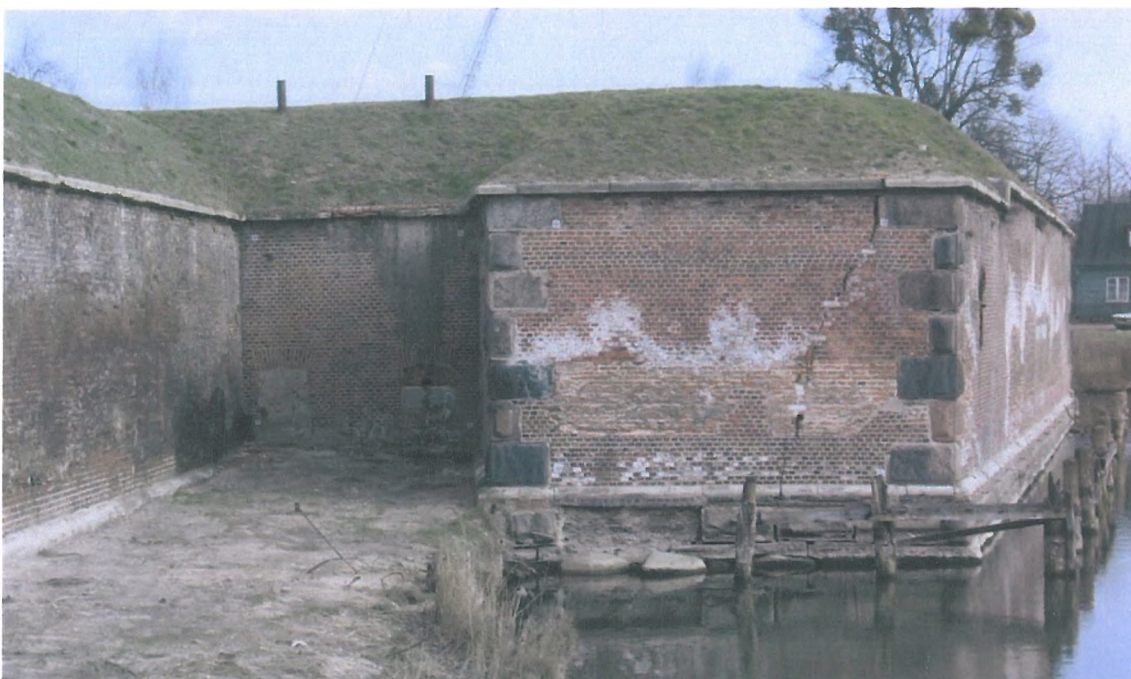
Fot. 4 Ucho pomiędzy Bastionem Ostroróg a Murem Kurtynowym Wschodnim
