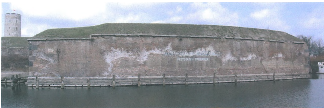
Fot. 3 Widok ściany wschodniej bastionu
