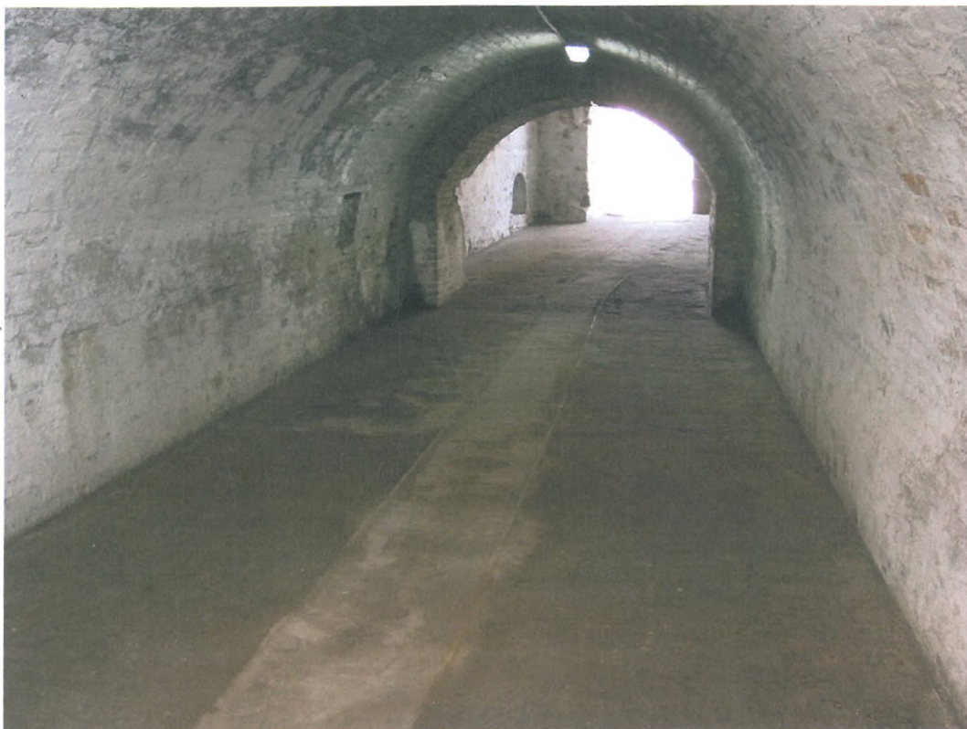
Fot. 6 Wejście do pomieszczeń Bastionu Ostroróg
