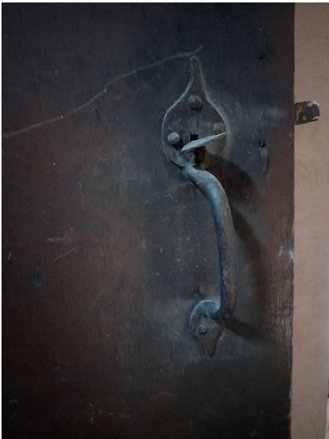
Fot. 25. Okucia, drzwi na strych.
