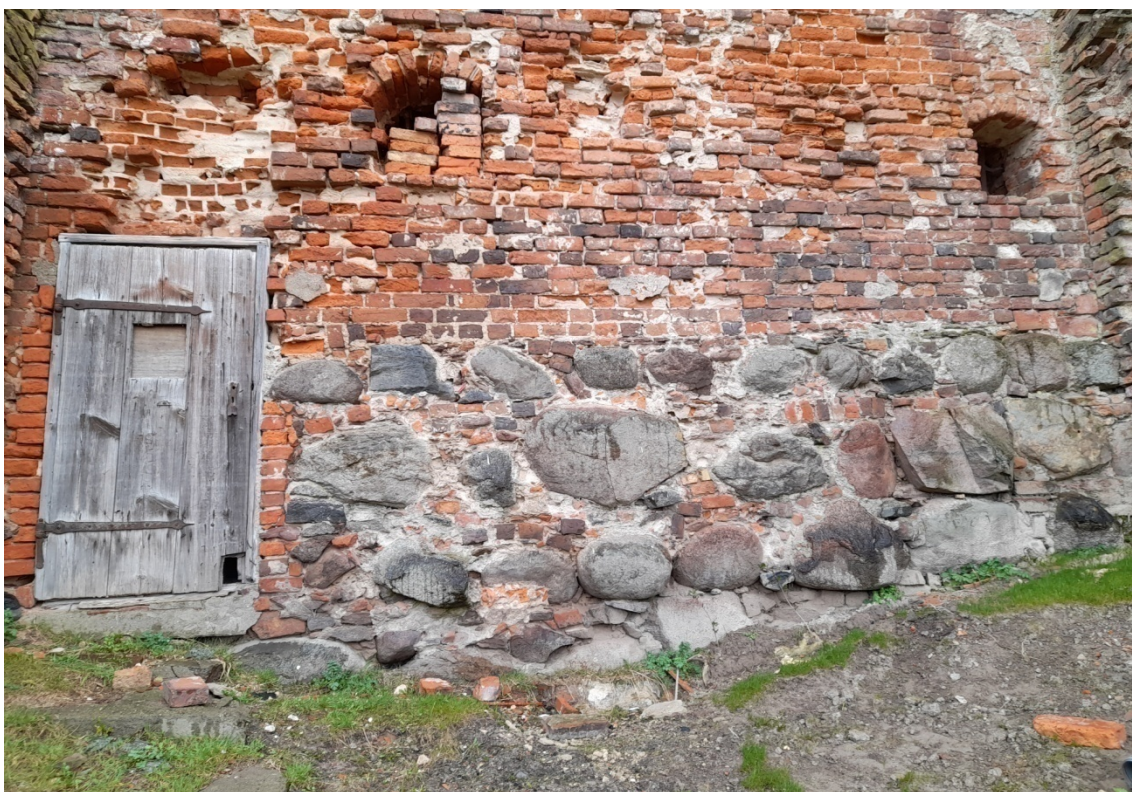
Fot. 3. Kamienica przy ul. Spichrzowej 37, elewacja zachodnia.
