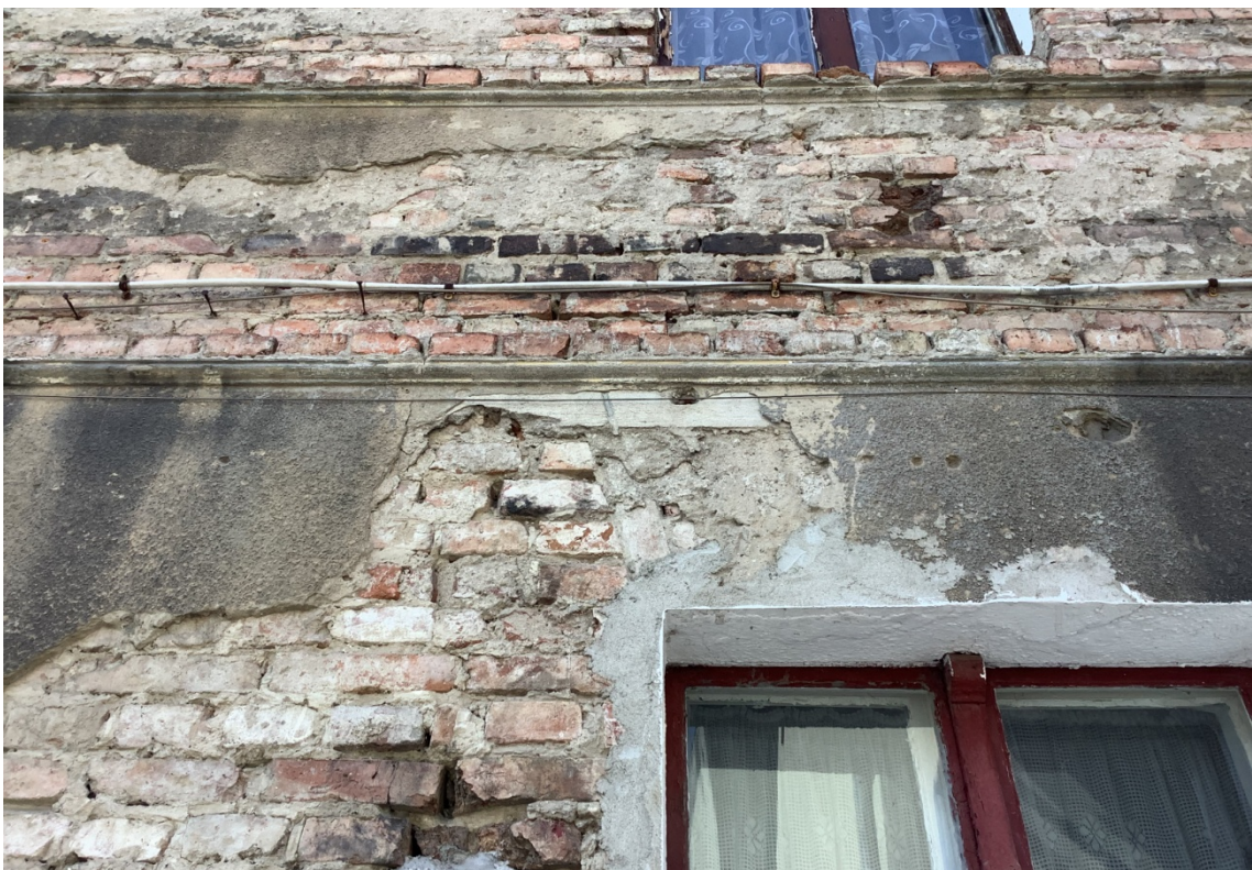
Fot. 13. Kamienica przy ul. Spichrzowej 37, elewacja wschodnia, widoczne pozostałości pierwotnych tynków.
