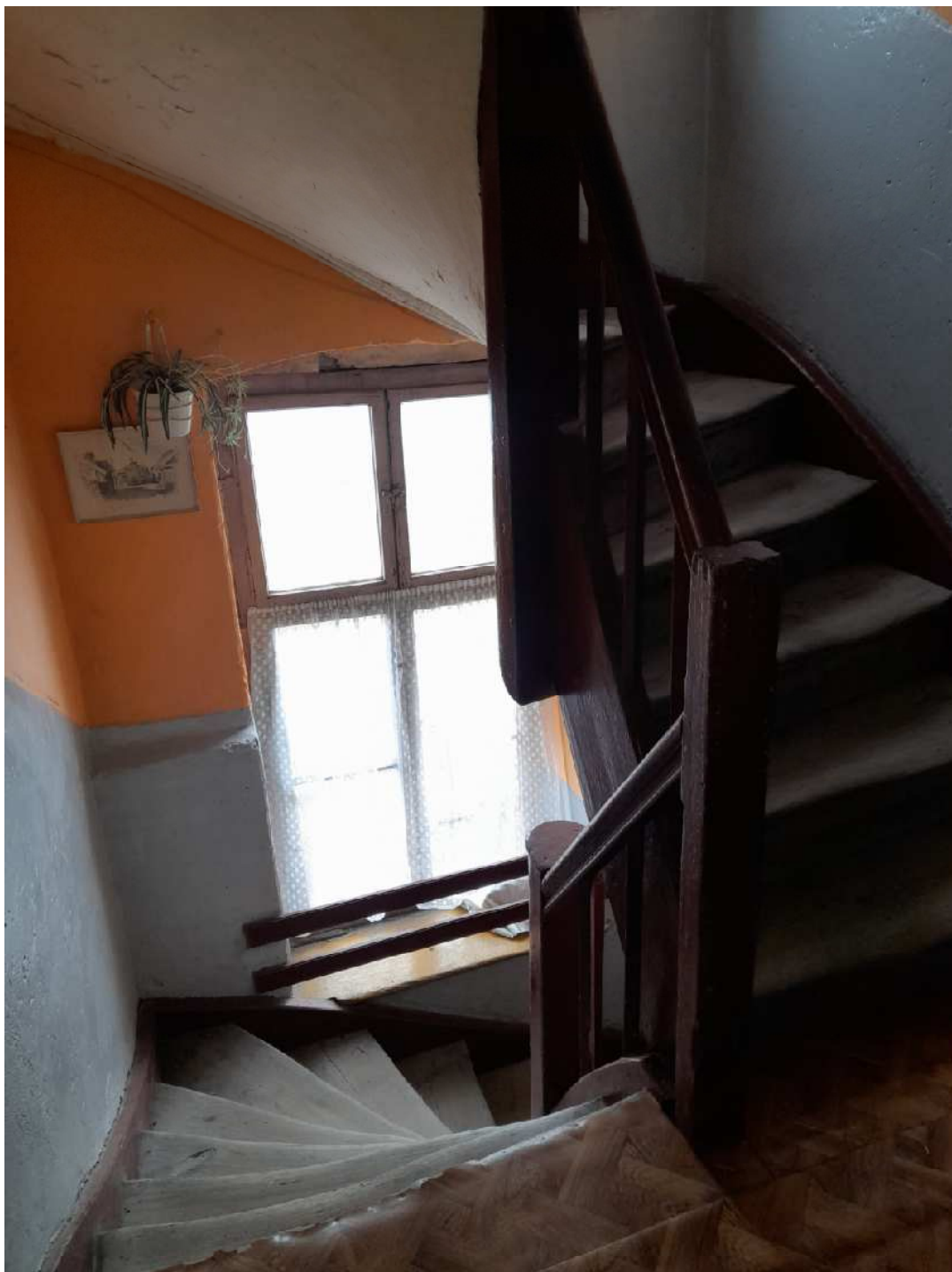
Fot. 19. Kamienica przy ul. Spichrzowej 37, klatka schodowa.
