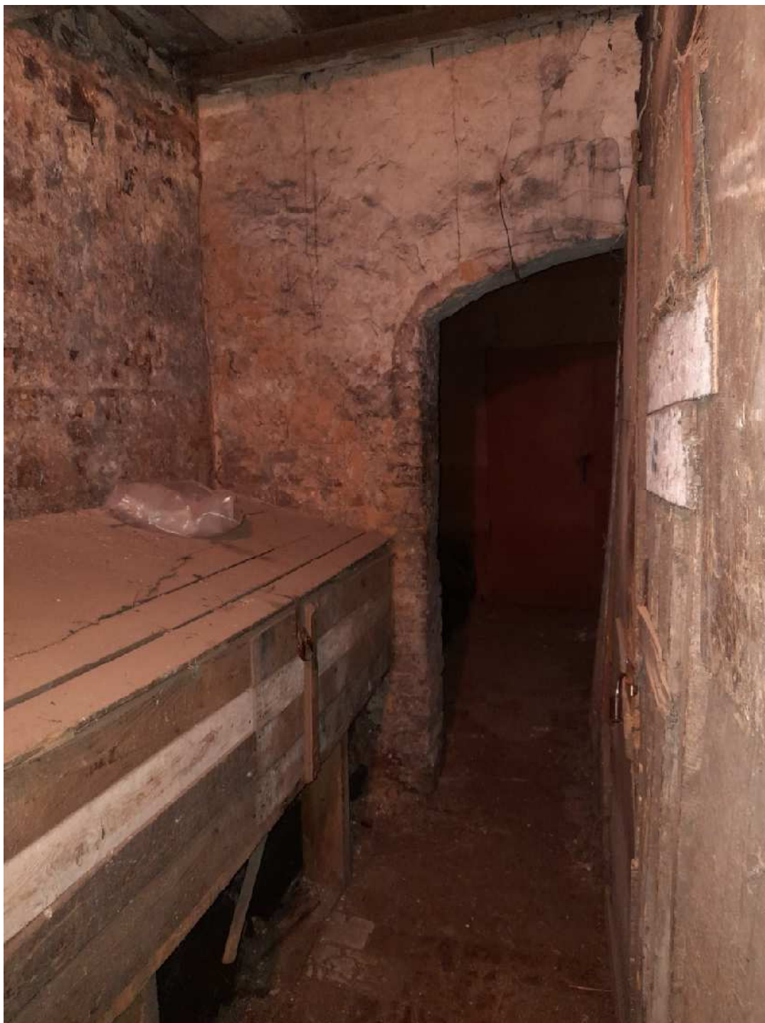
Fot. 16. Kamienica przy ul. Spichrzowej 37, najniższy poziom piwnic.
