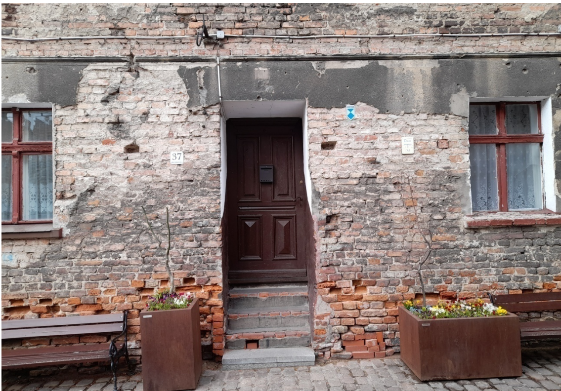
Fot. 9. Kamienica przy ul. Spichrzowej 37, elewacja wschodnia.
