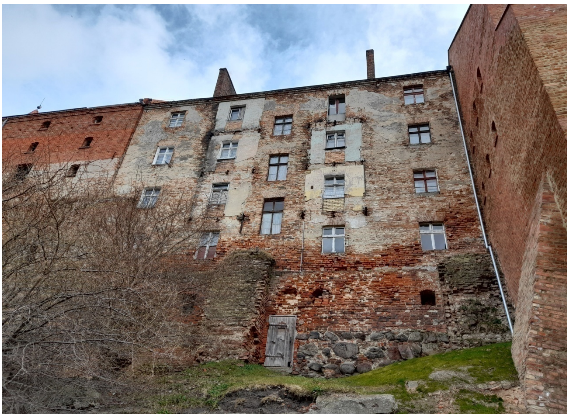
Fot. 2. Kamienica przy ul. Spichrzowej 37, elewacja zachodnia.
