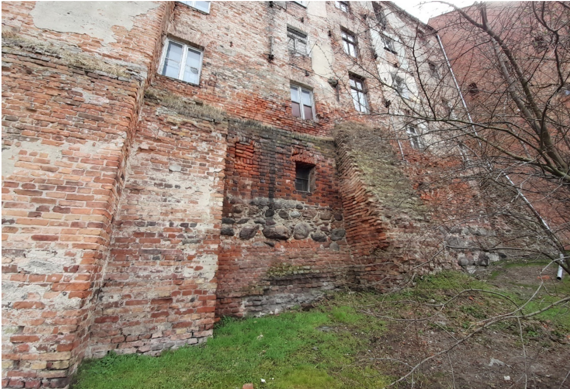
Fot. 4. Kamienica przy ul. Spichrzowej 37, elewacja zachodnia.
