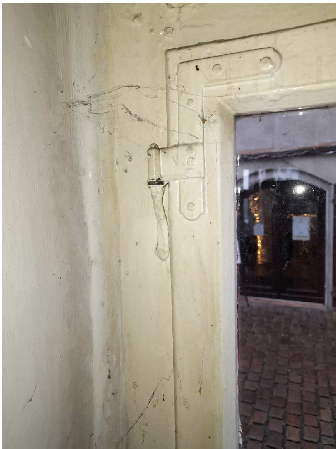
Fot. 27. Okucia, okna mieszkań.
