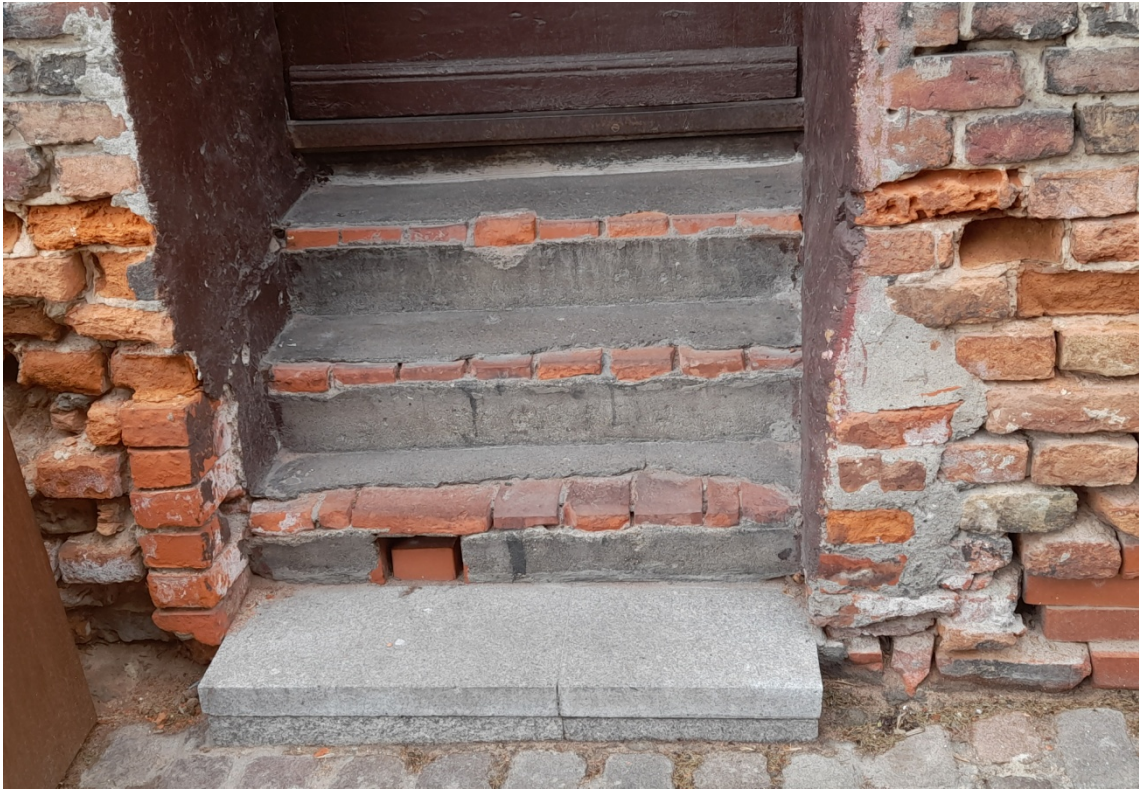
Fot. 10. Kamienica przy ul. Spichrzowej 37, elewacja wschodnia.
