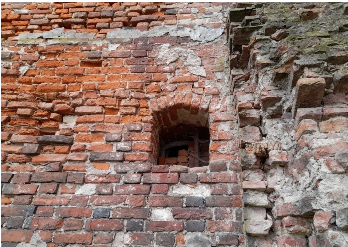
Fot. 6. Kamienica przy ul. Spichrzowej 37, elewacja zachodnia.
