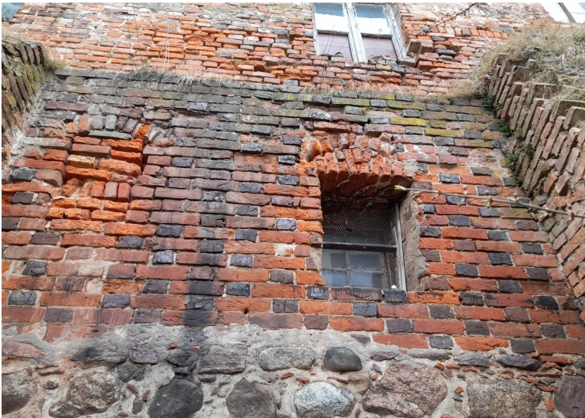
Fot. 5. Kamienica przy ul. Spichrzowej 37, elewacja zachodnia.
