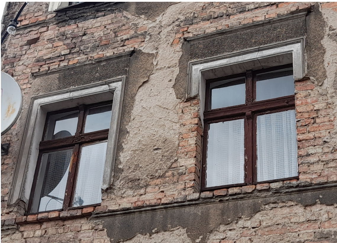
Fot. 11. Kamienica przy ul. Spichrzowej 37, elewacja wschodnia.
