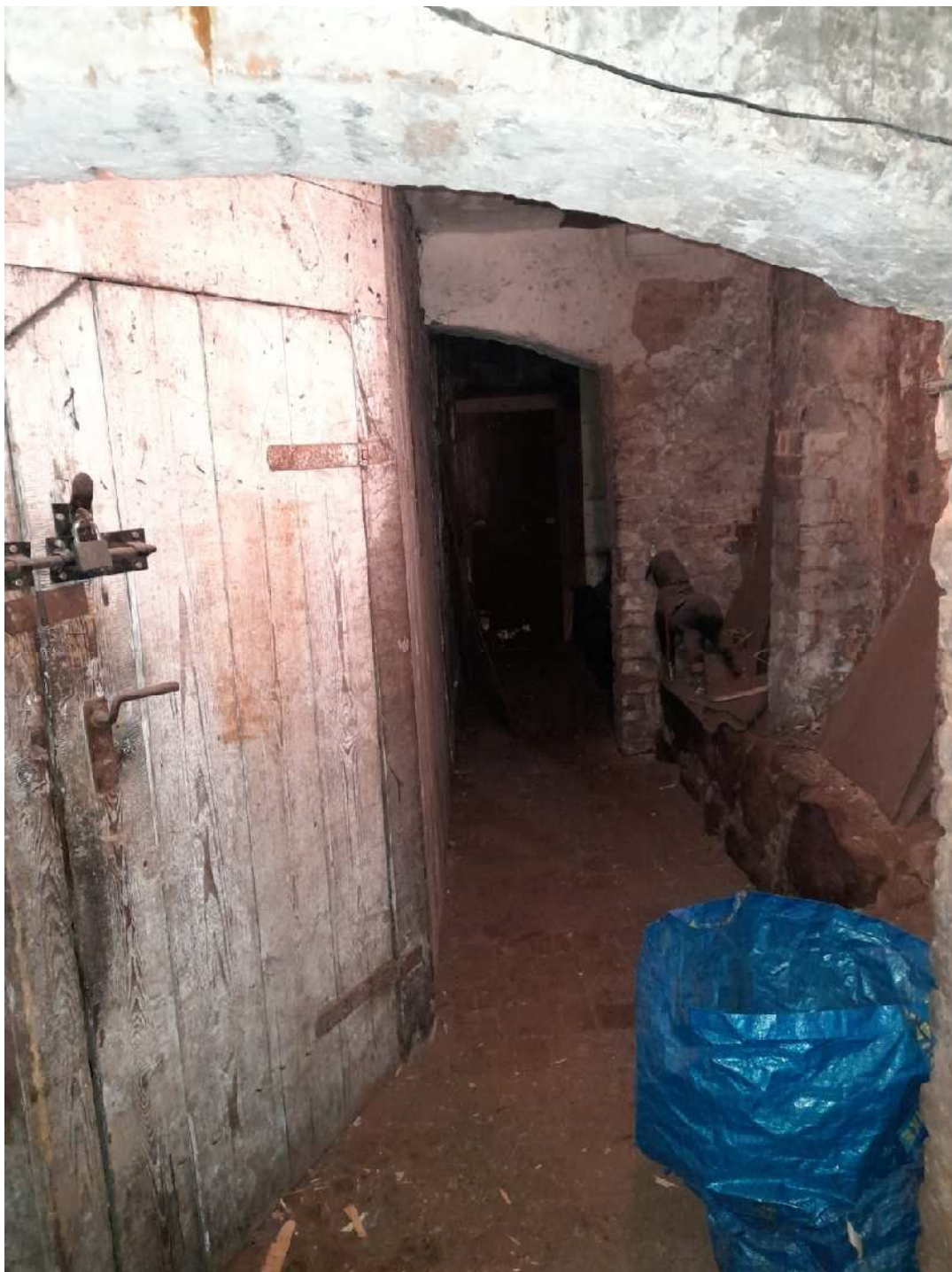
Fot. 17. Kamienica przy ul. Spichrzowej 37, najniższy poziom piwnic.
