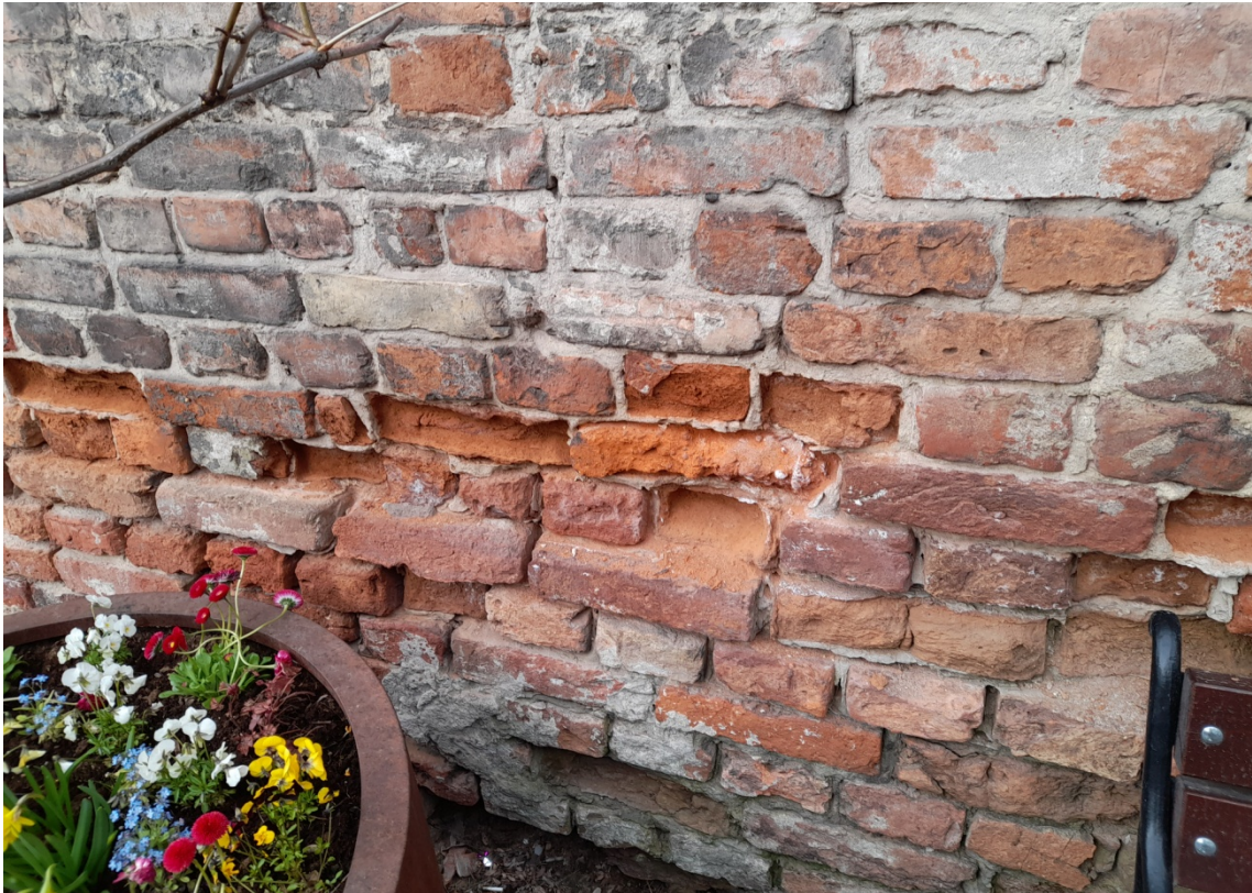
Fot. 12. Kamienica przy ul. Spichrzowej 37, elewacja wschodnia.
