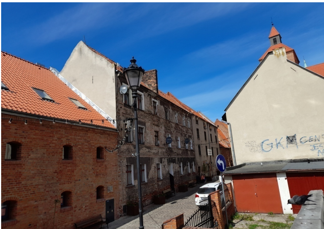
Fot. 7. Kamienica przy ul. Spichrzowej 37, elewacja wschodnia.
