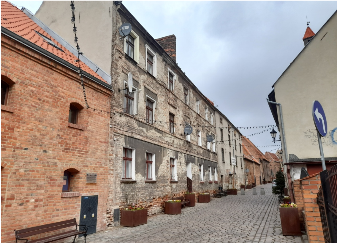
Fot. 8. Kamienica przy ul. Spichrzowej 37, elewacja wschodnia.
