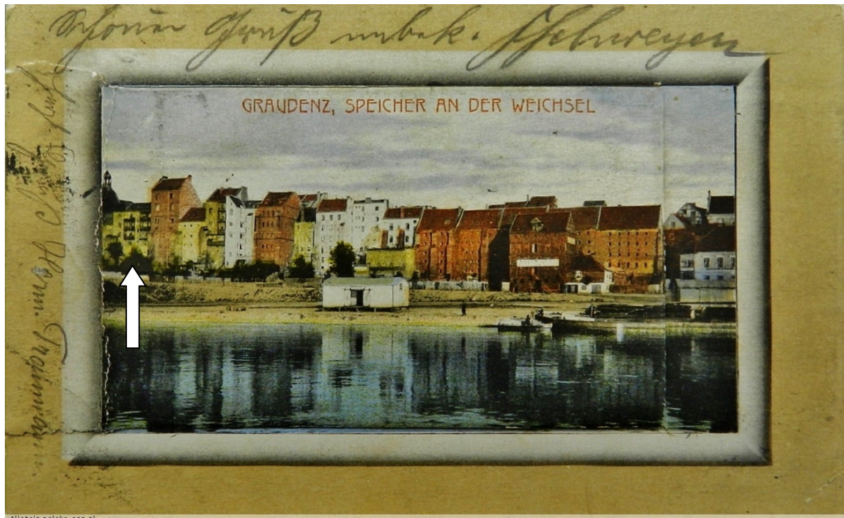
Ryc. 14. Fragment pocztówki z fotografią z lat 1911 przedstawiający zabudowę spichrzową od strony południowo-zachodniej. Na budynku nr 37 widać zabudowę balkonów. Źródło: fotopolska.eu.
