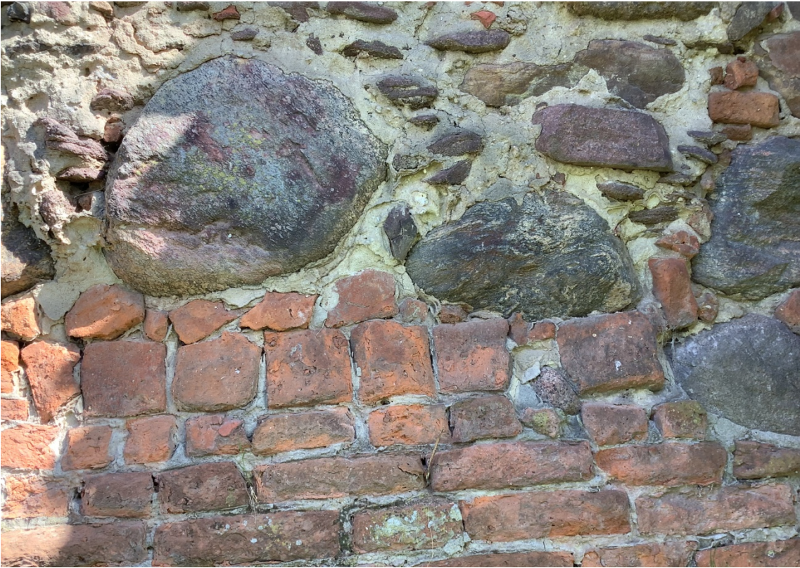
Fot. 30. Kamienie i cegły o dużych wymiarach w dolnej części murów elewacji zachodniej, część wmurowana podstawą względem lica ściany.
