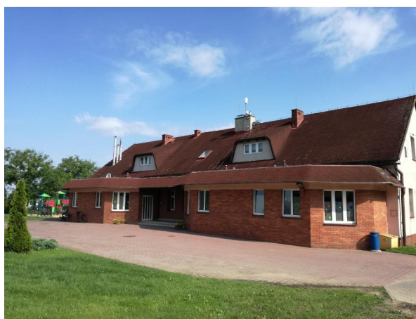
Fot.1 Elewacja południowa
