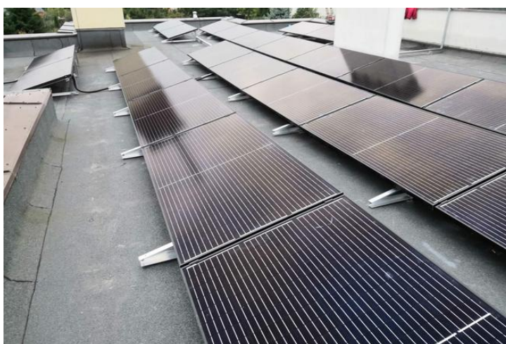
Rys. 5. Przykładowy system montażu paneli na dachu płaskim.
