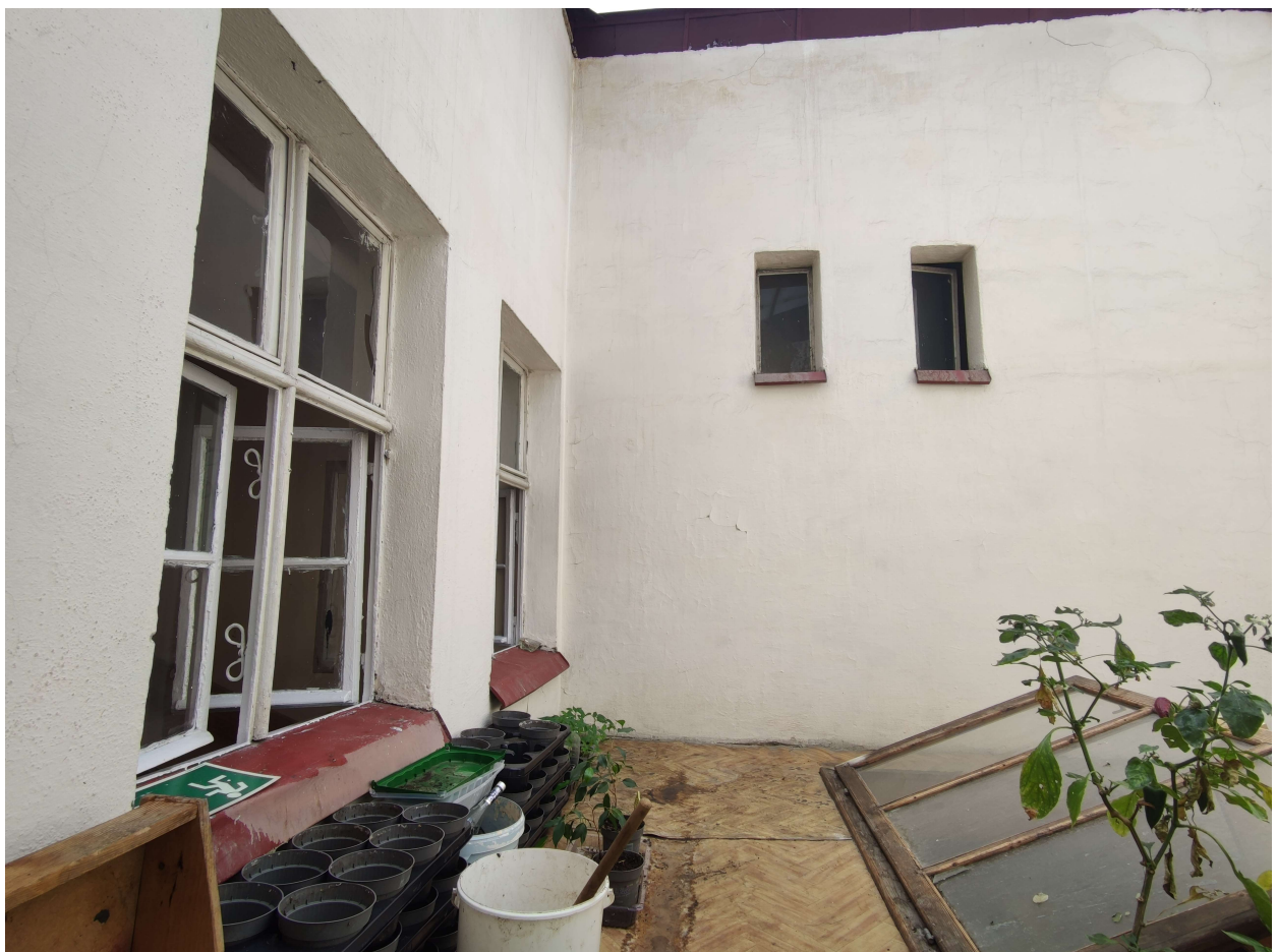
Ratusz w Międzylesiu - stan istniejący okna „studni” wewnątrz budynku
