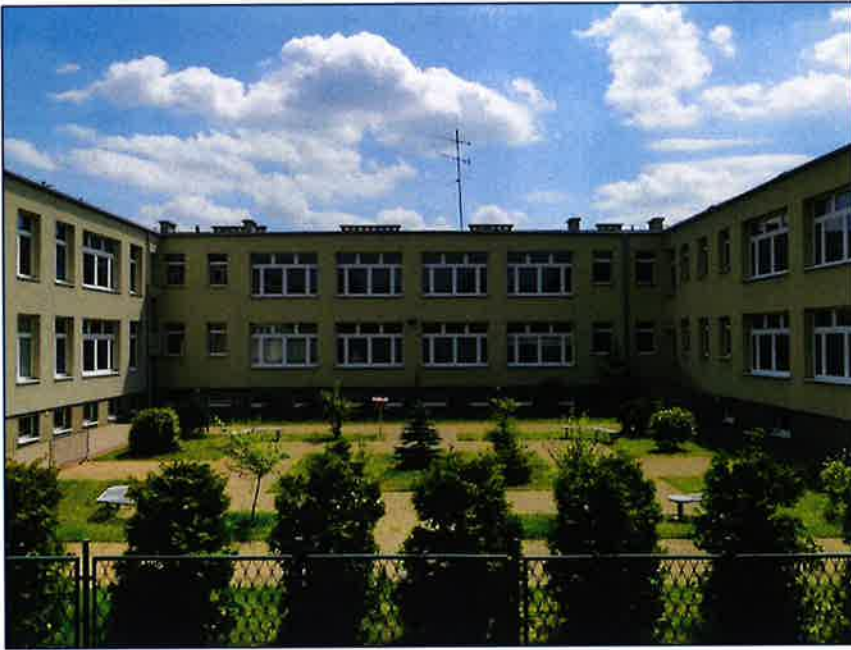
ściana północno-zachodnia budynku Szkoły Podstawowej nr 3 przy ul. Matejki 1- 45 budek łęgowych
