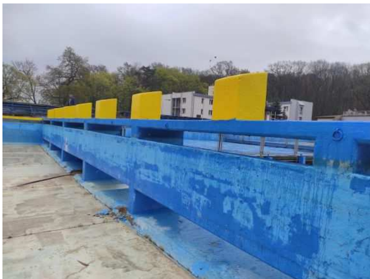
Fot. Widok na konstrukcję słupowo – ryglową, która tworzy przeponeę pomiędzy basenem przeznaczonym dla dorosłych a częścią olimpijską basenu oraz słupki startowe. Konstrukcja słupowo-ryglowa podlega remontowi wierzchnich powłok basenowych.
