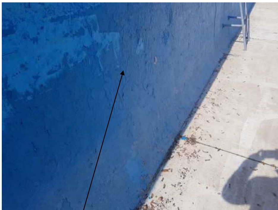
Widoczne uszkodzenia powłoki basenowej
