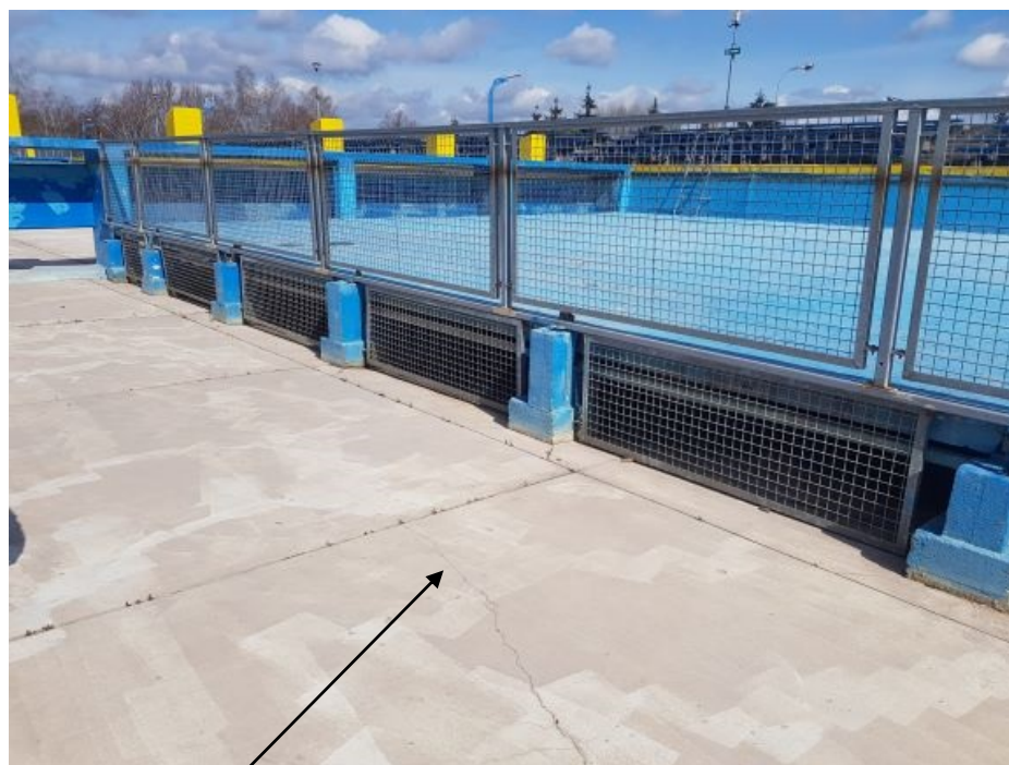
Widoczne braki uszczelnień w szczelinach dylatacyjnych skurczowych płyty dennej basenu
