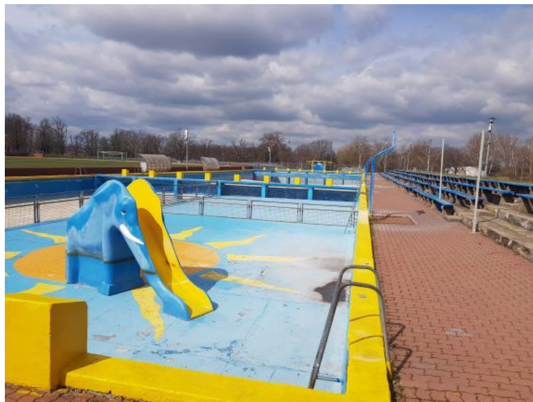
Fot. Widok na nieckę przeznaczoną dla dzieci, która podlega kompletnej rozbiórce i odtworzeniu. Korona zbiornika podlega modernizacji w formie demontażu istniejącej i wykonaniu nowej, prefabrykowanej.
