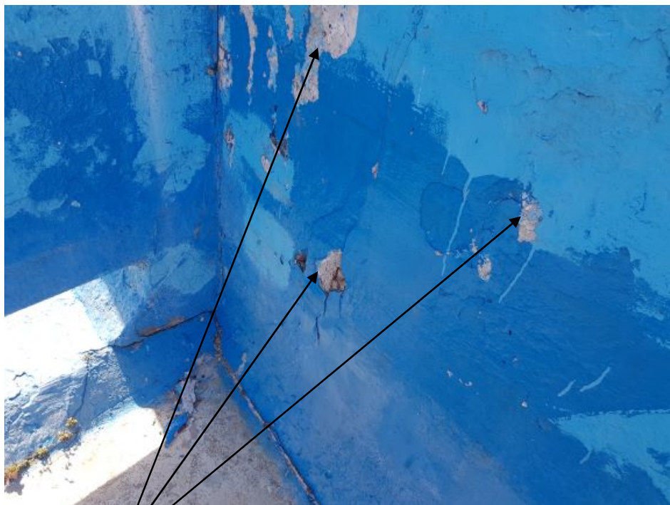
Widoczne uszkodzenia mechaniczne ścian niecki
