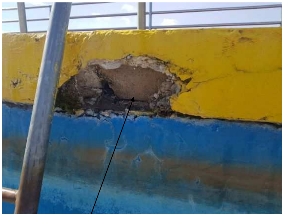
Widoczne uszkodzenia korony basenu – gzymsu
