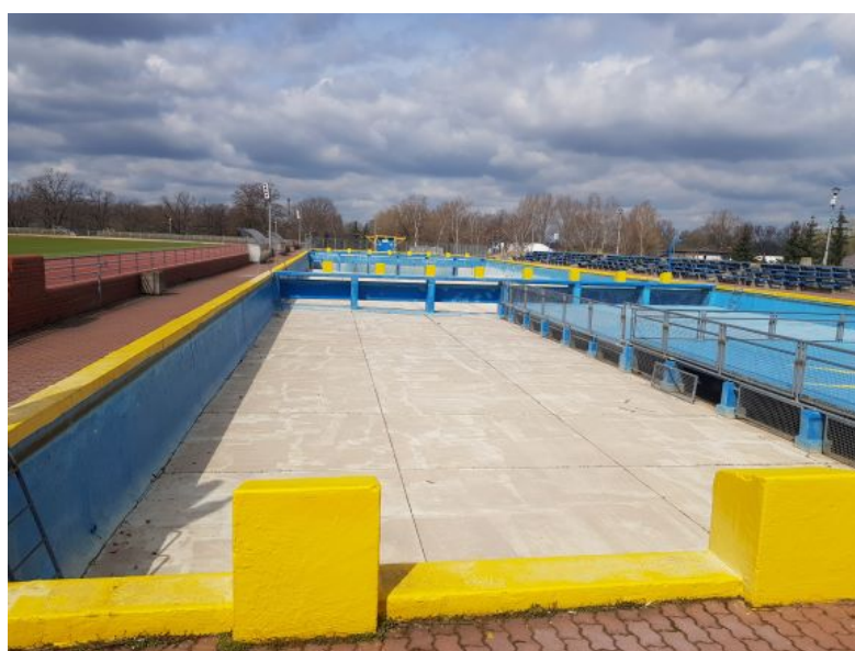
Fot. Widok na część basenu przeznaczoną dla dorosłych. Istniejące słupki startowe podlegają modernizacji w formie demontażu istniejących słupków i wykonaniu nowych, żelbetowych.
