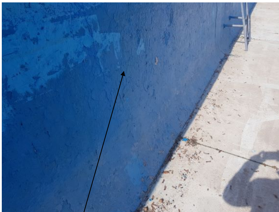
Widoczne uszkodzenia powłoki basenowej
