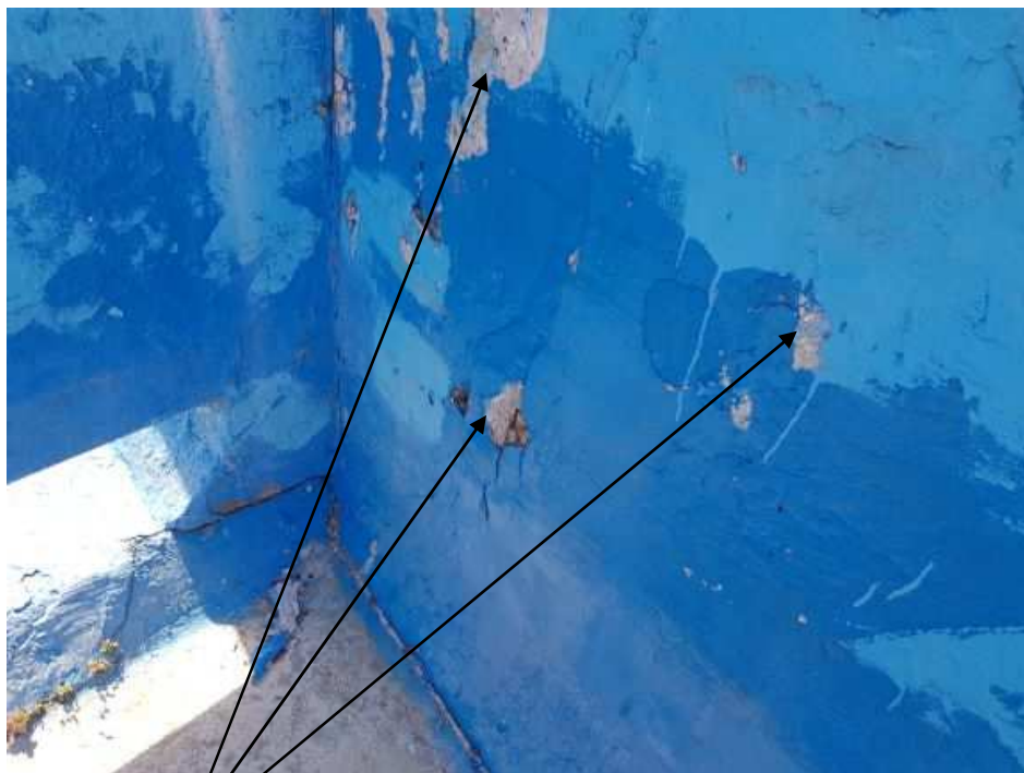
Widoczne uszkodzenia mechaniczne ścian niecki
