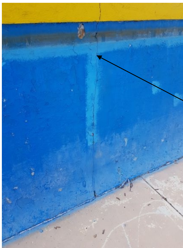
Widoczne zarysowania ścian pionowych niecki
