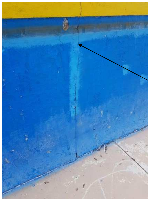
Widoczne zarysowania ścian pionowych niecki
