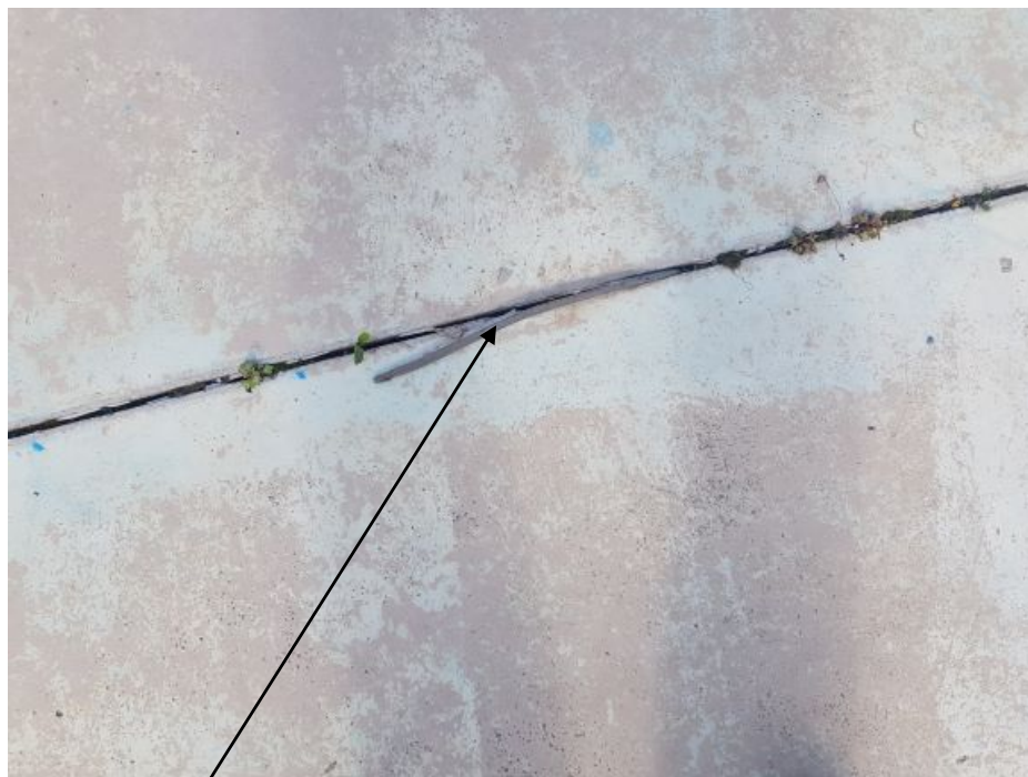
Widoczne braki uszczelnień w szczelinach dylatacyjnych skurczowych płyty dennej basenu
