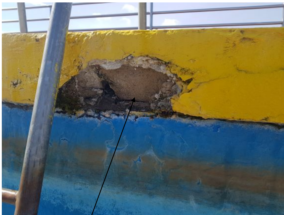
Widoczne uszkodzenia korony basenu – gzymsu
