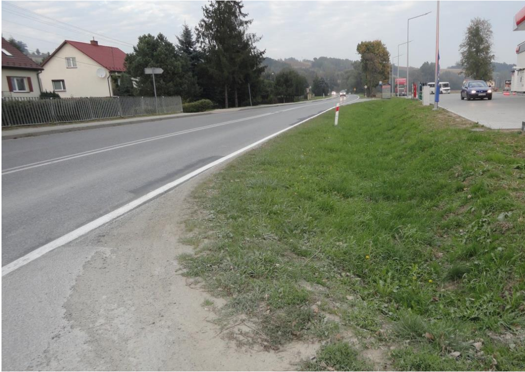
Fot. 1 . Rejon planowanego przejścia dla pieszych – widok w kierunku Tarnowa.
