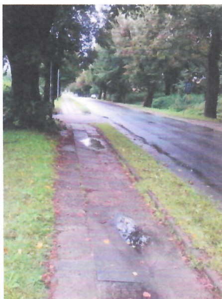
Fot. 31-32. Zły stan techniczny nawierzchni jezdni i chodników
