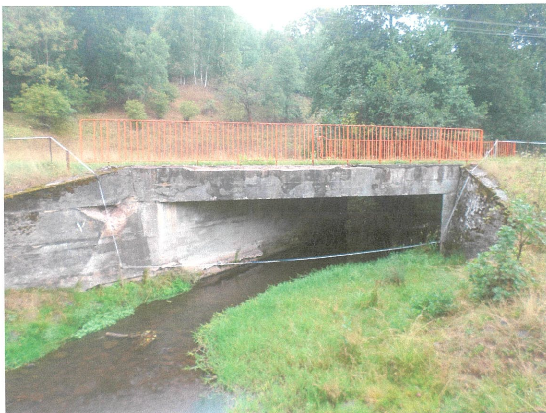
Fot. 2. Widok obiektu od strony dolnej wody.
