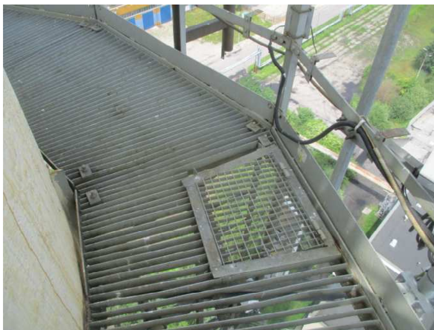
Fot.26,27.Pomost w poziomie +40, we właściwym stanie technicznym
