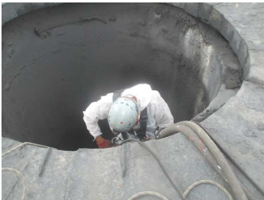
Fot.34.Zwieńczenie trzonu, płyty przekrywające, otok odgromowy
