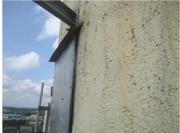
Fot.19,20.Naprawiona strefa trzonu w okolicy zamknięcia otworów pomiarowych
