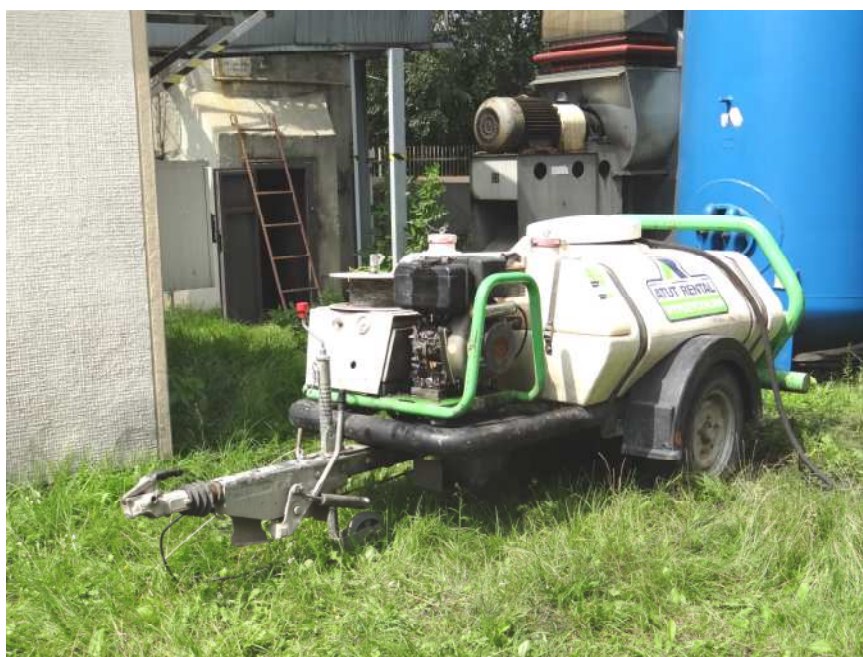
Fot.14.Agregat użyty do mycia wnętrza przewodu dymowego
