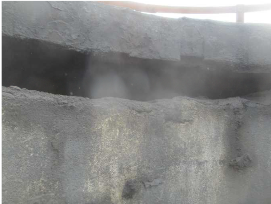
Fot.3. Zwieńczenie trzonu i przewodu dymowego
