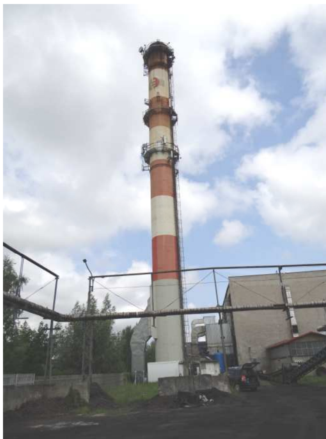
Fot.1.Widok ogólny komina
