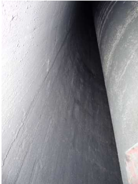
Fot.11,12.Przestrzeń wentylowana pomiędzy trzonem żelbetowym a wewnętrznym przewodem dymowym
