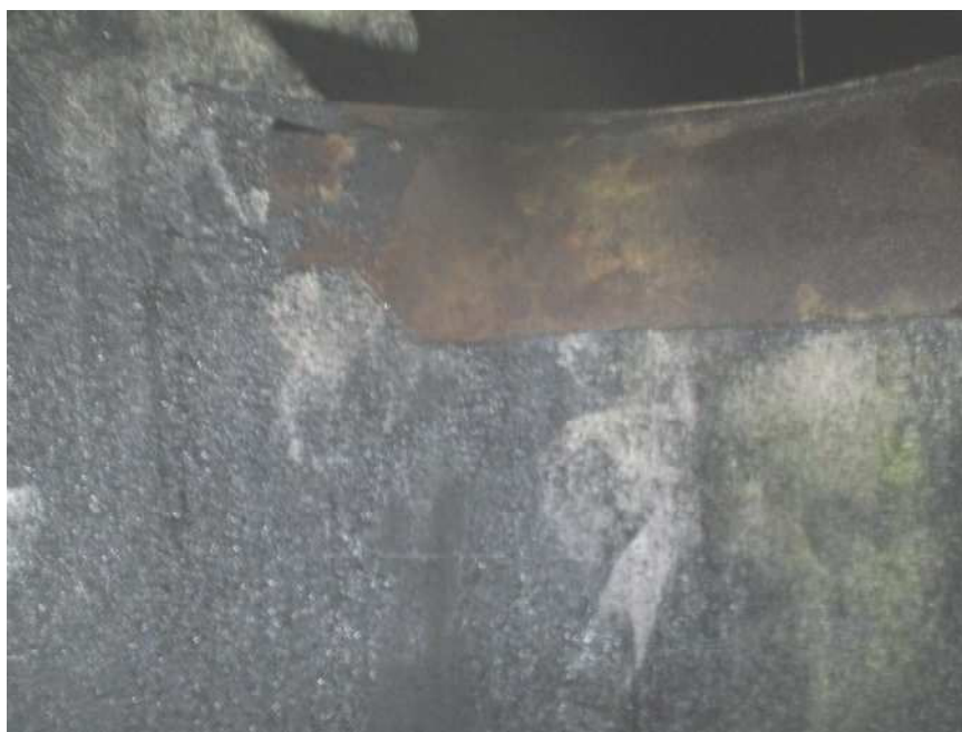
Fot.49.Właściwy stan techniczny wewnętrznej powierzchni przewodu dymowego w okolicy wlotu króćca czopuchowego
