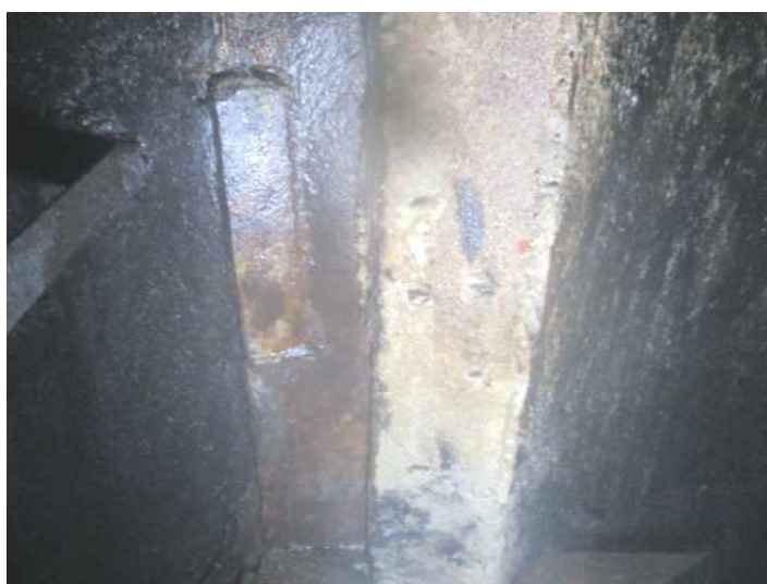
Fot.46,47,48. Właściwy stan techniczny wewnętrznej powierzchni przewodu dymowego w okolicy wlotu króćca czopuchowego
