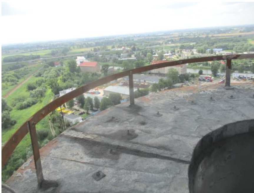
Fot.34.Zwieńczenie trzonu, płyty przekrywające, otok odgromowy
