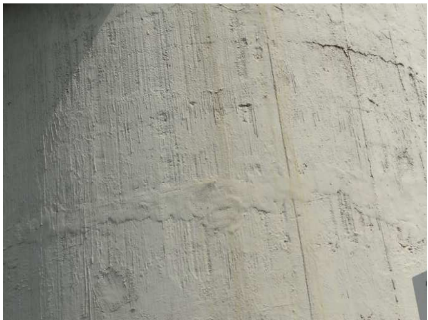
Fot.10.Właściwy stan techniczny trzonu żelbetowego komina, ślady po wykonanych naprawach
