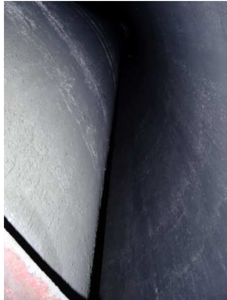
Fot.11,12.Przestrzeń wentylowana pomiędzy trzonem żelbetowym a wewnętrznym przewodem dymowym
