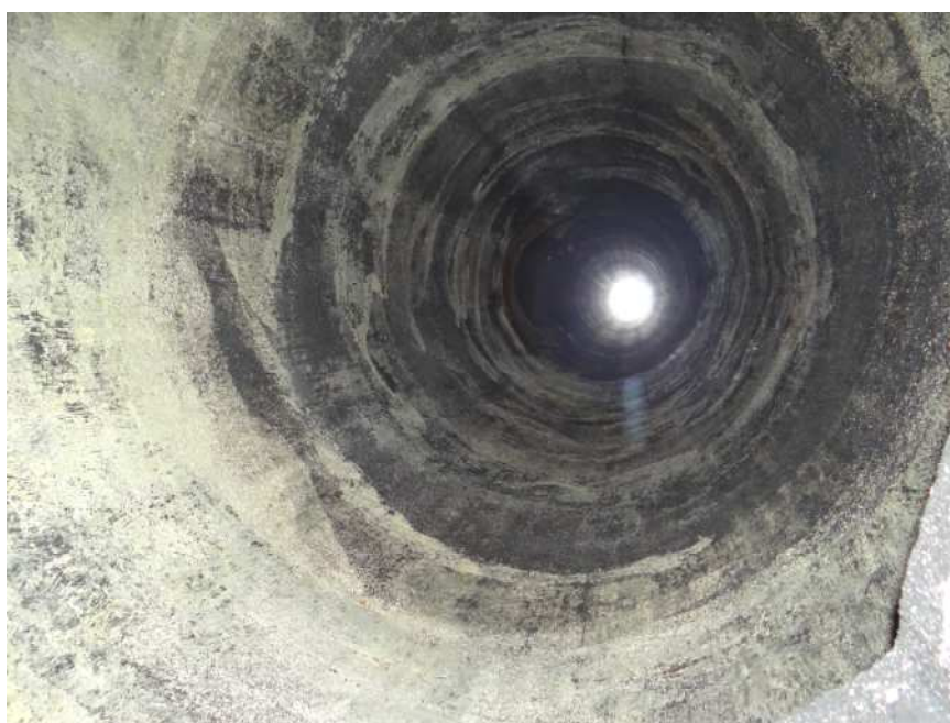
Fot.15.Wnętrze przewodu dymowego po myciu
