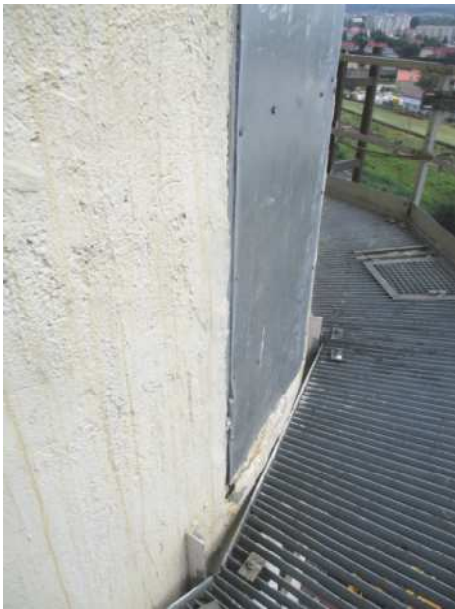
Fot.19,20.Naprawiona strefa trzonu w okolicy zamknięcia otworów pomiarowych
