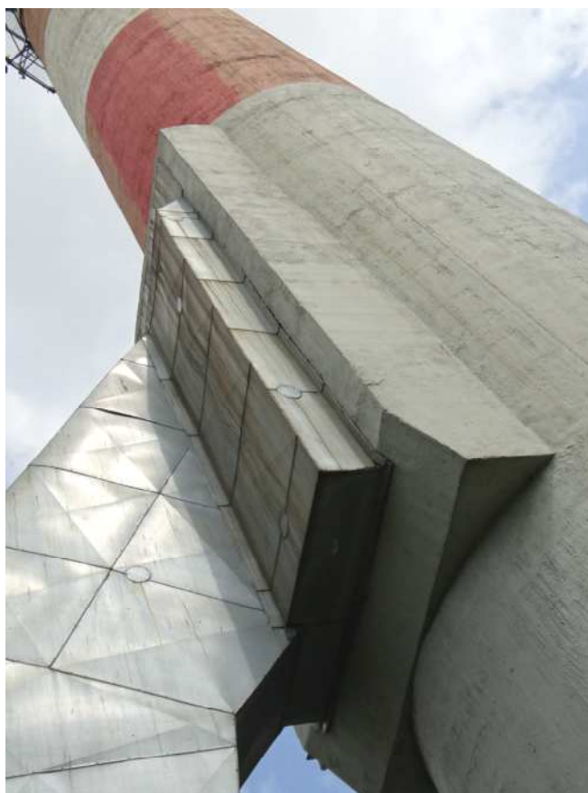
Fot.2.Włot kanału spalin do komina, pilastry wzmacniające trzon
