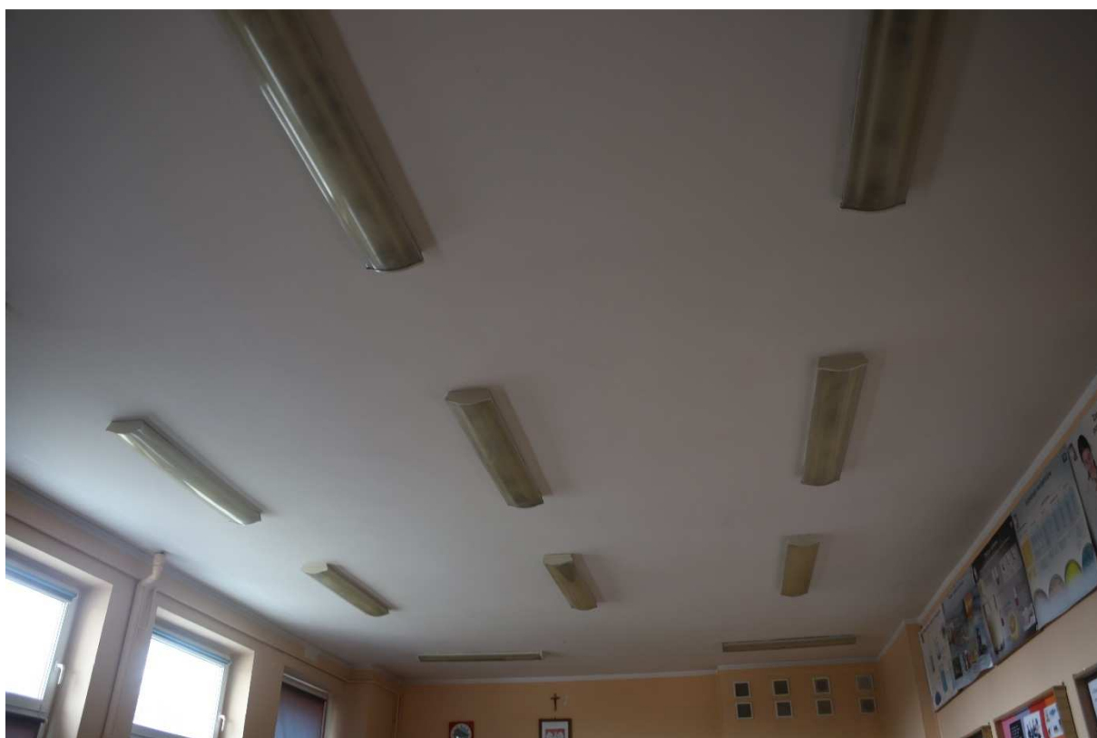
Fot.14. Całe oświetlenie w budynku do wymiany na energooszczędne
