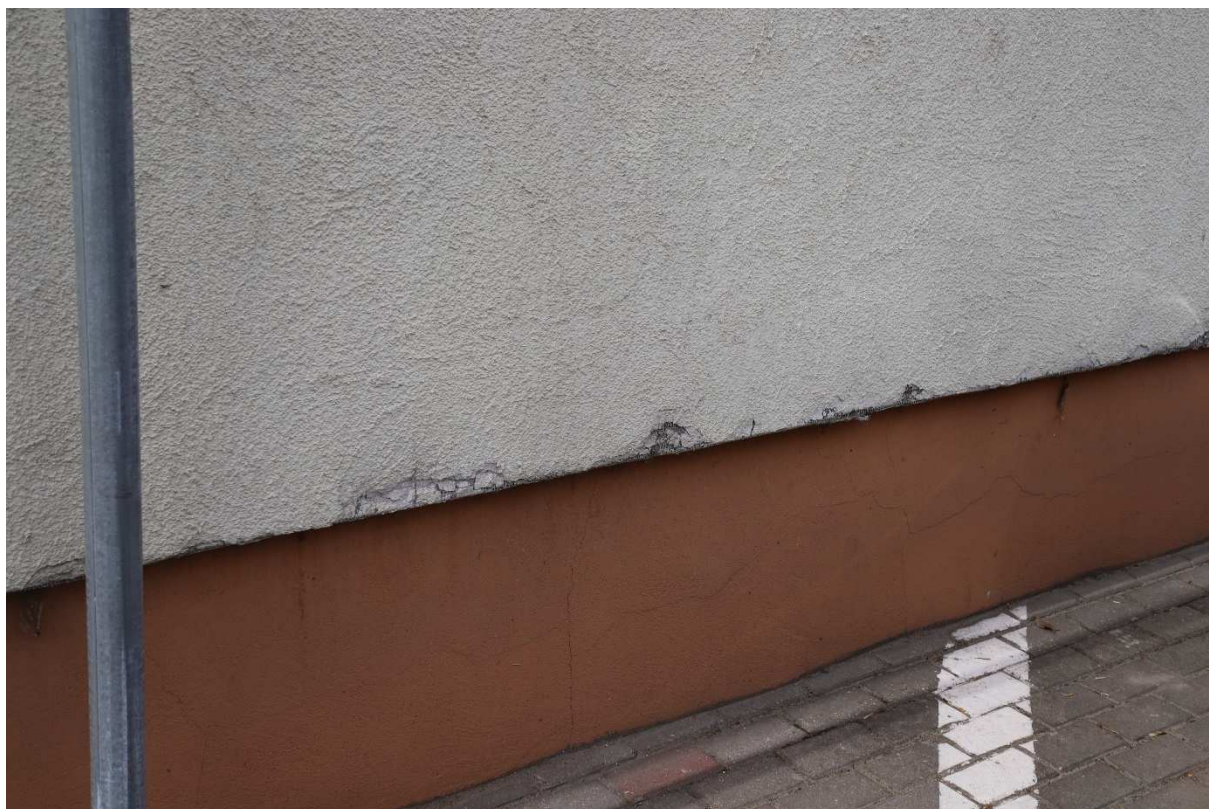
Fot.11. Rysy pionowe i uszkodzenia na ścianie zewnętrznej
