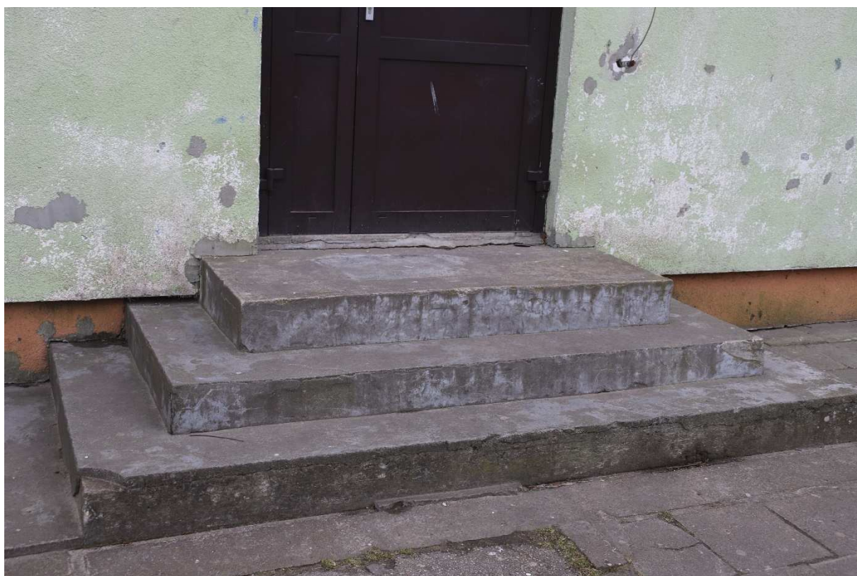
Fot.4. Schody zewnętrzne na północnej elewacji do odbudowy i obłożenia
