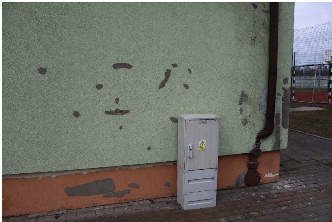
Fot.1. Uszkodzenia elewacji (ubytki docieplenia oraz tynku)
