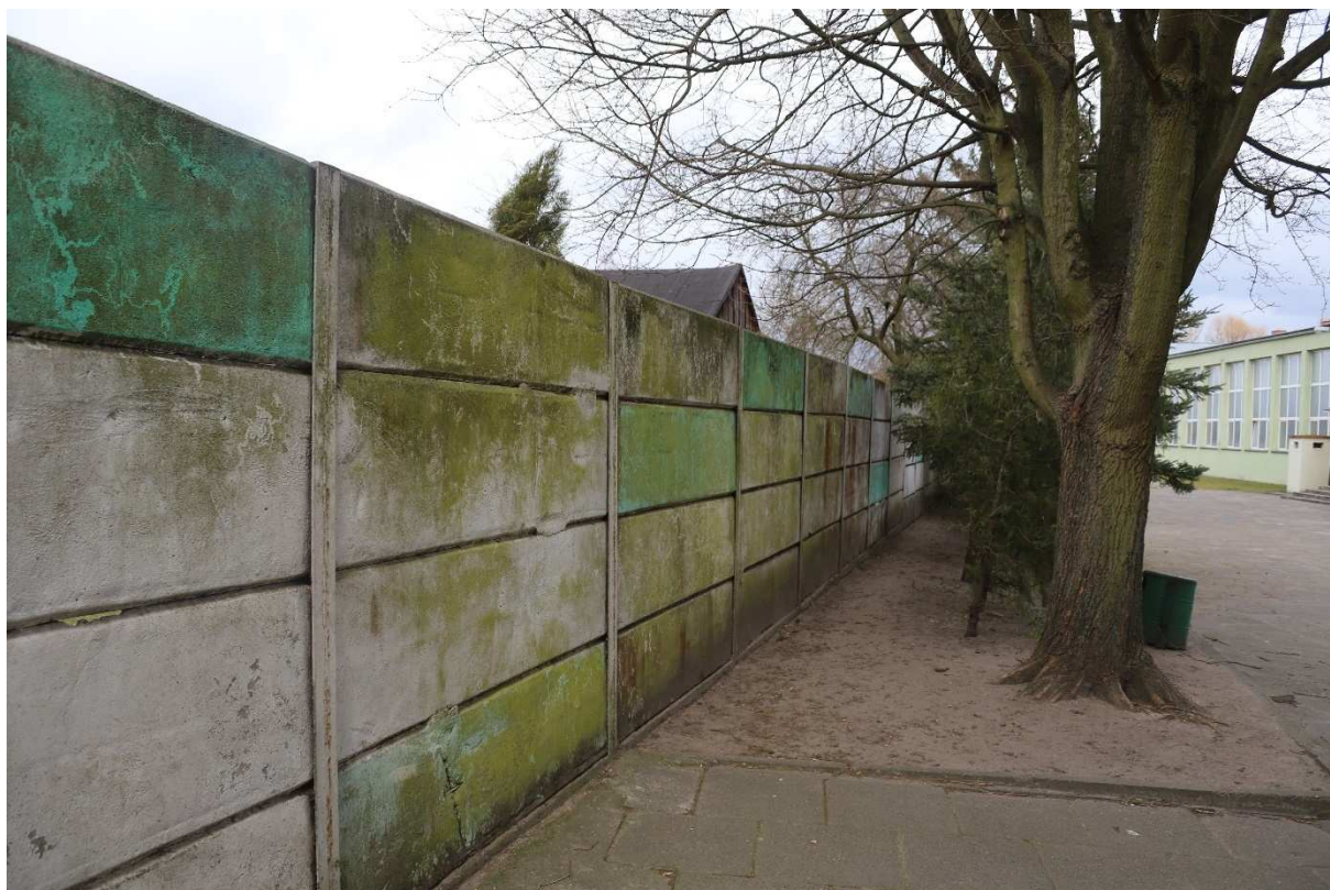
Fot.9. Istniejące ogrodzenie betonowe do oczyszczenia, uzupełnienia ubytków i malowania
