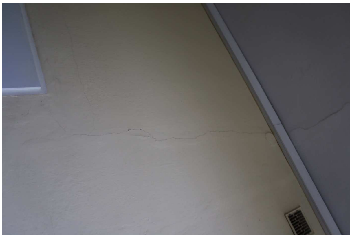
Fot.15. Rysy na stropie i ścianie nośnej
