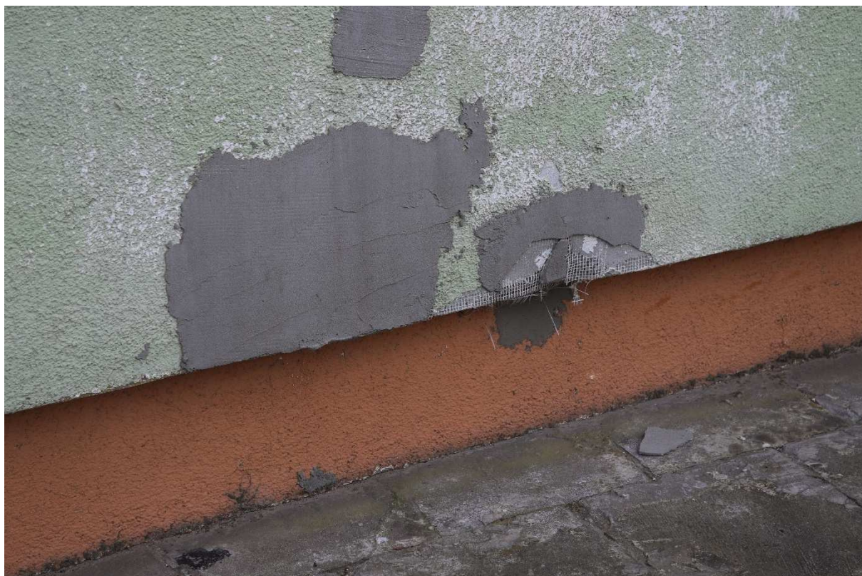
Fot.3. Uszkodzenia docieplenia ścian
