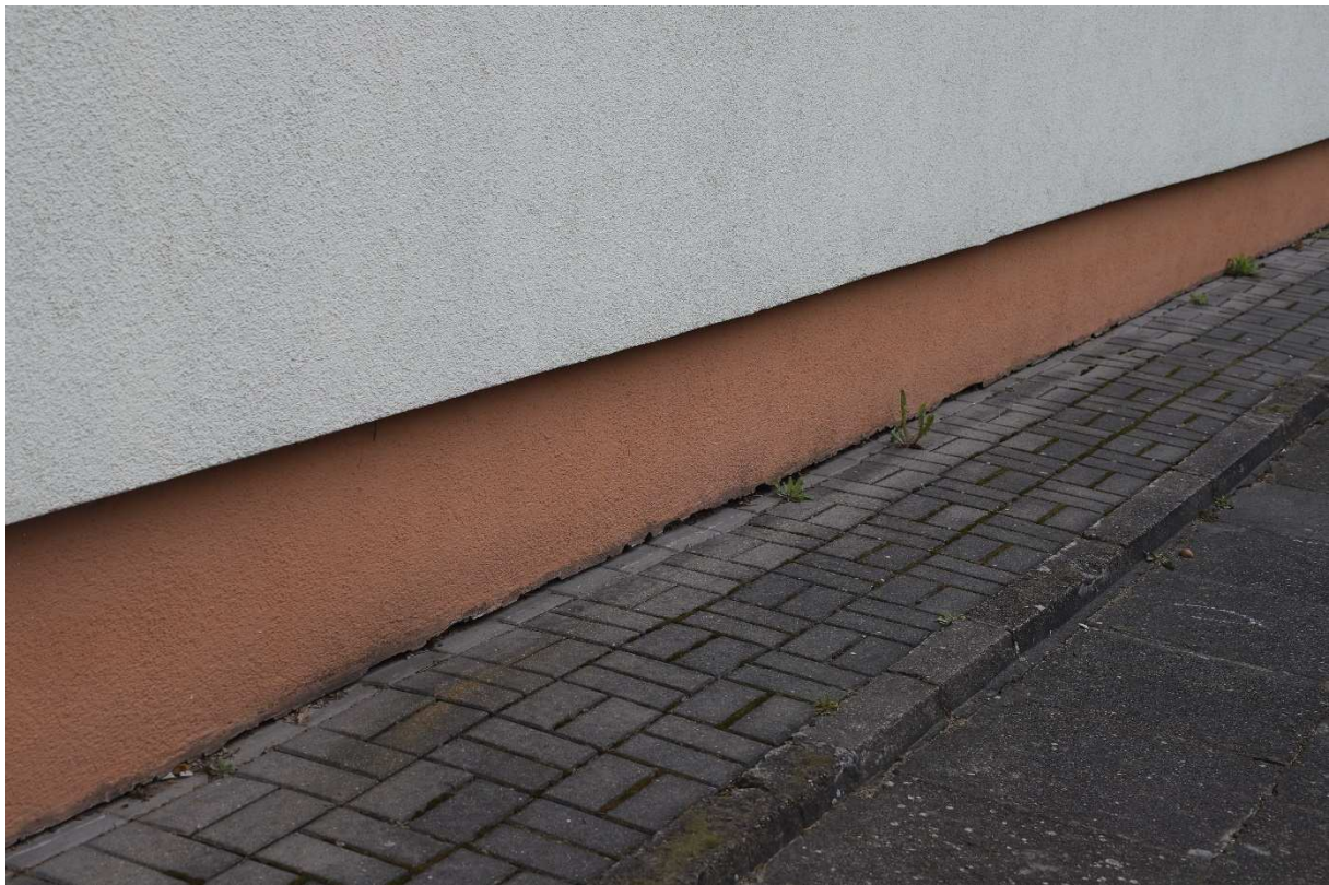
Fot.8. Widoczne osiadania gruntu
