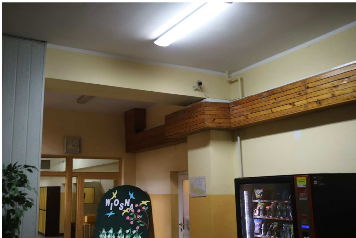
Fot.19. Boazeria do likwidacji – rury zabudować płytą g-k.
