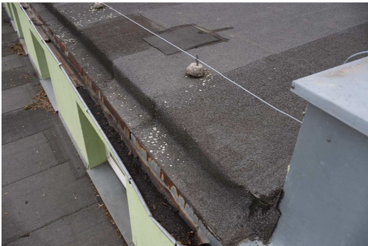
Fot.17. Uszkodzenia i korozja rynien i rur spustowych – wszystkie do wymiany
