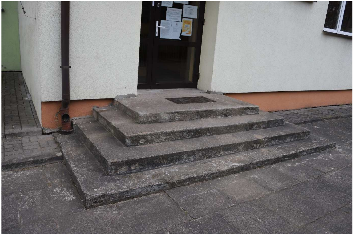
Fot.5. Schody zewnętrzne na elewacji zachodniej do odbudowy i obłożenia
