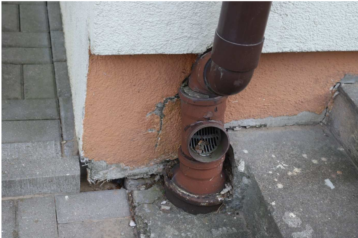
Fot.7. Uszkodzenia docieplenia cokołów
