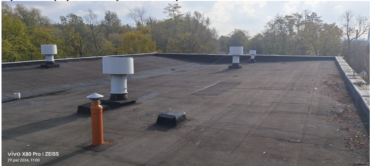
Rys.1 Dach przy ul. Wielkiej Niedźwiedzicy 1
