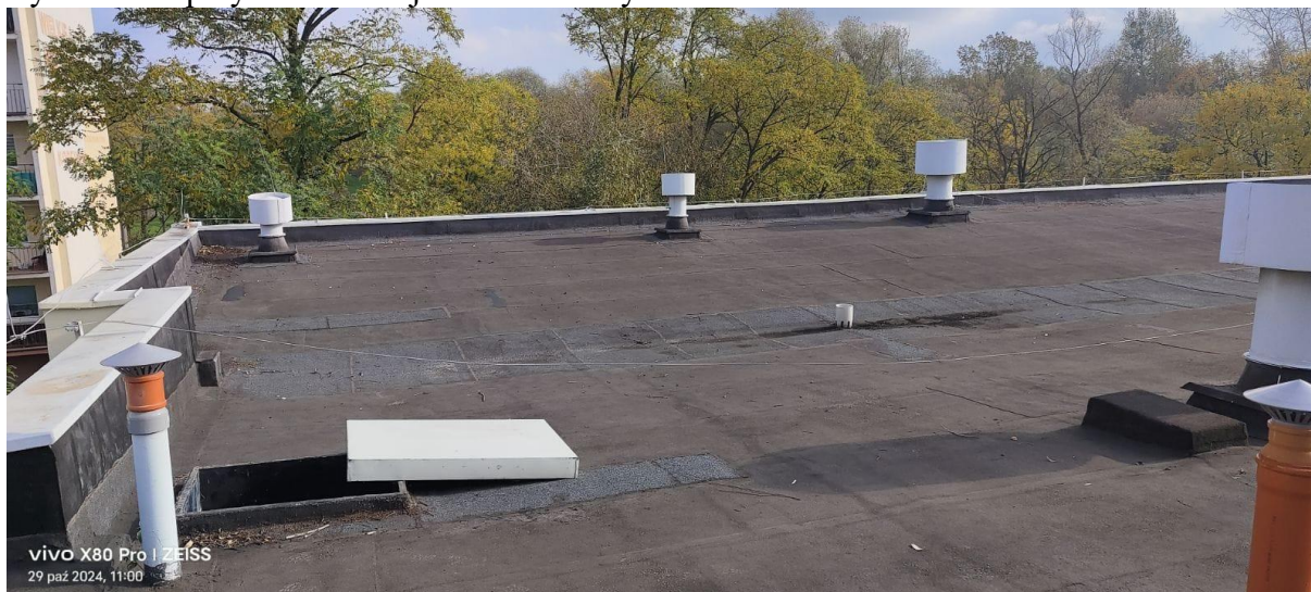
Rys.4 Dach przy ul. Wielkiej Niedźwiedzicy 1
