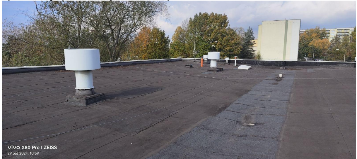
Rys.2 Dach przy ul. Wielkiej Niedźwiedzicy 1
