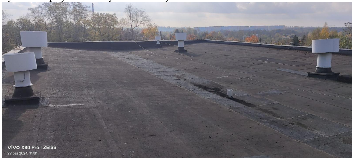
Rys.3 Dach przy ul. Wielkiej Niedźwiedzicy 1
