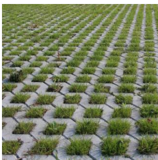
Nawierzchnia – typ C – płyta ażurowa betonowa zapewniająca retencję wody do gruntu i powierzchnię biologicznie czynną do 50%, o wymiarach 60x40cm i grubości 10cm, o gładkiej fakturze z fazą, w kolorze szarym.
