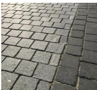
Nawierzchnia – typ A 2 – kostka granitowa grubości 10cm, cięta, łupana, góra płomieniowana, w kolorze czarnym.
