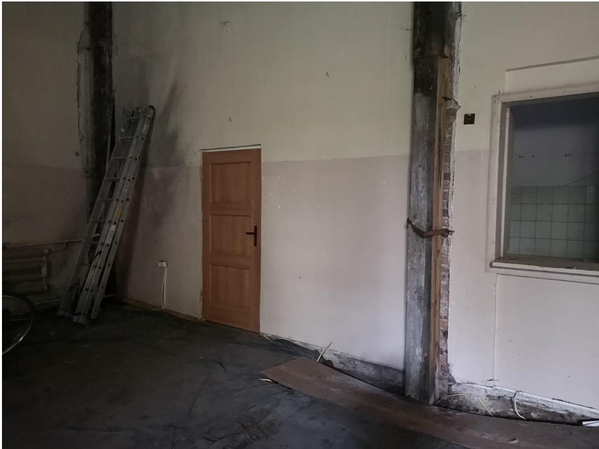
Nowe drzwi i słupek „tatan” kawałkami nowych elementów
