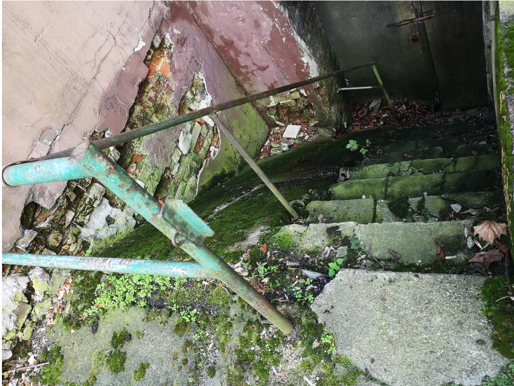
Zsyp i wejście do piwnicy
