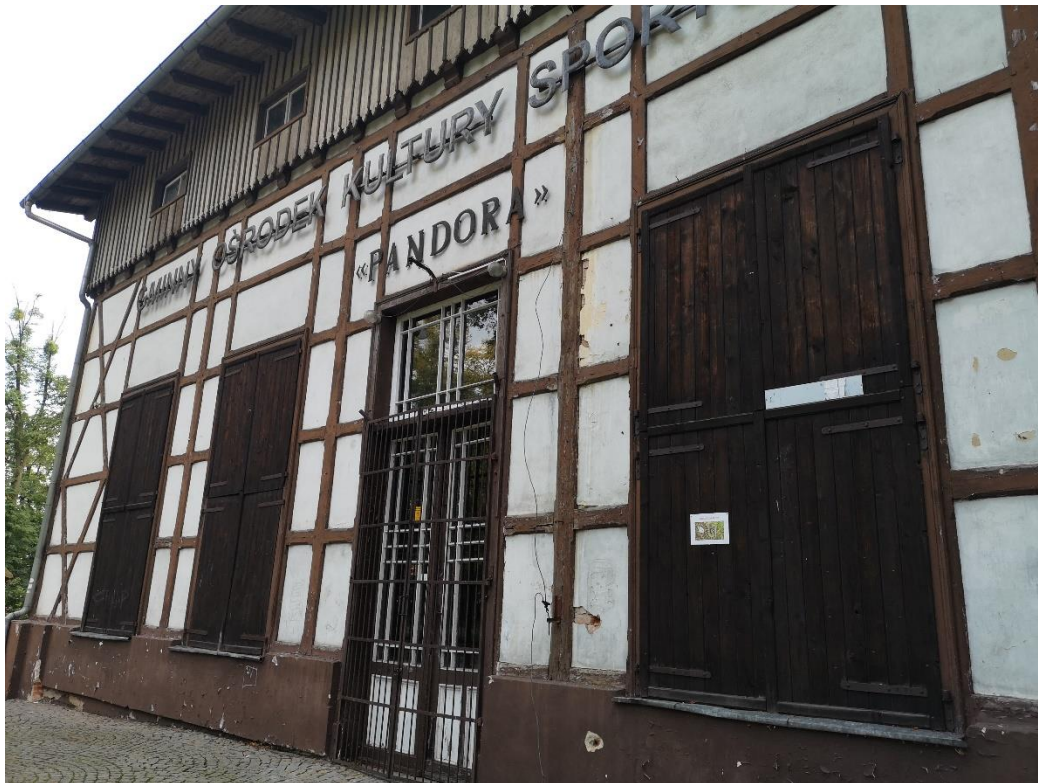
Elewacja frontowa /południowo-zachodnia/
