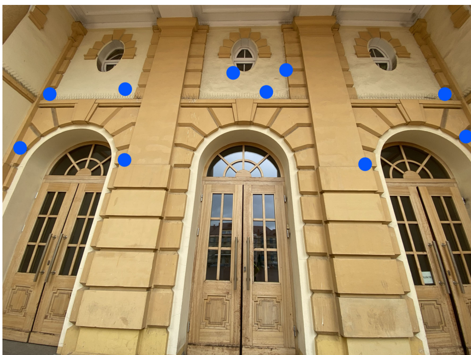
Ilustracja 6: Lokalizacja miejsc odkrywek inspekcyjnych.
