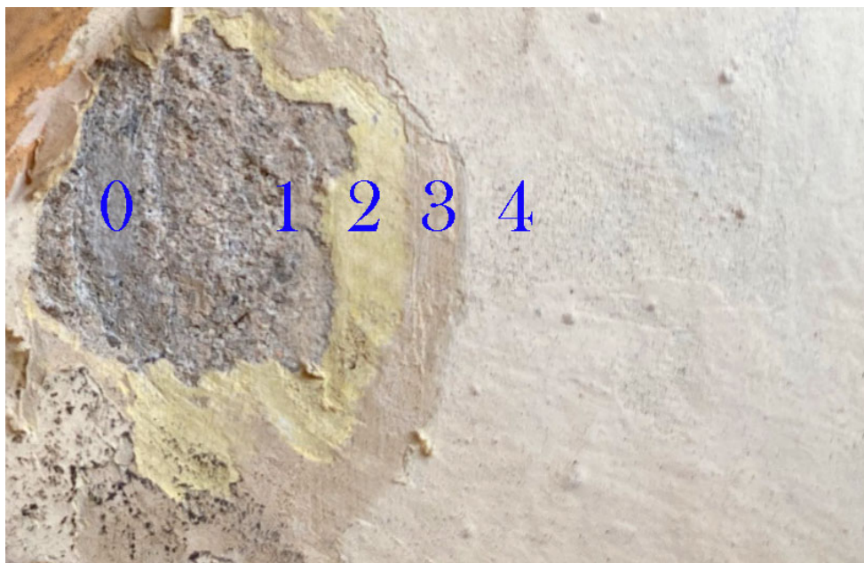
Ilustracja 7: Fotografia makroskopowa odkrywki inspekcyjnej ilustrująca stratygrafię warstw malarskich w obrębie portyku.
