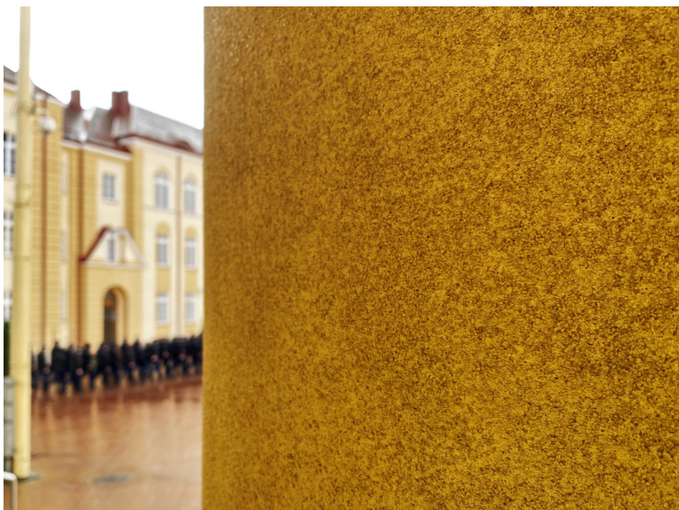
Ilustracja 22: Faktura wtórnego tynku odbiega od jego formy oryginalnej. fot. P. Głuszko
