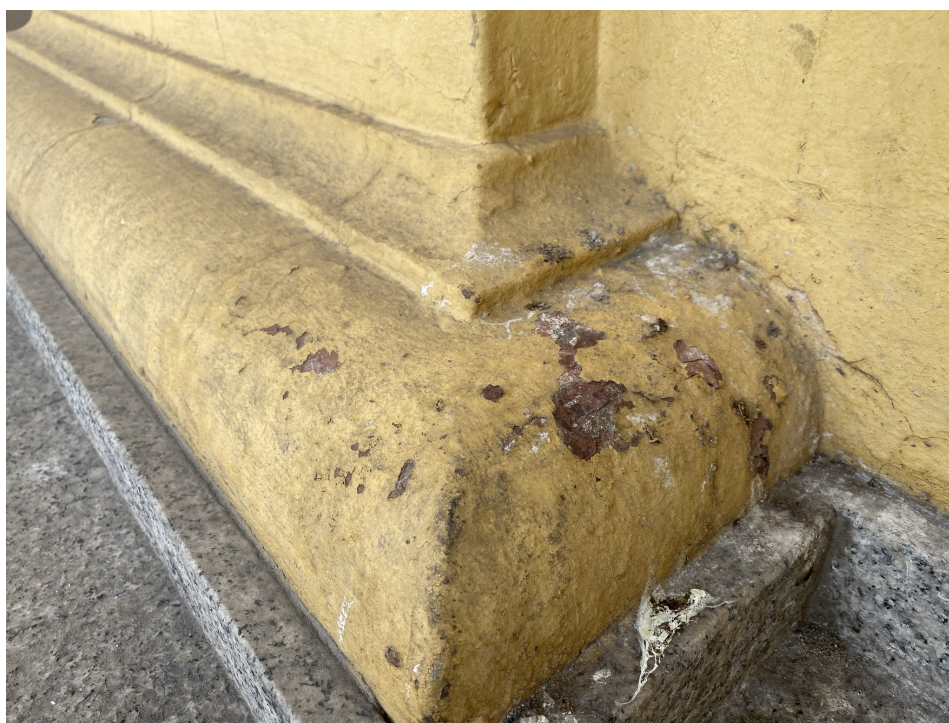
Ilustracja 21: Liczne przemalowania zatracają rzeźbiarski modelunek poszczególnych elementów wystroju portyku. fot. P. Głuszko
