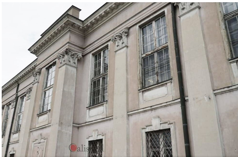
Ilustracja 16: Subtelne różnice walorowe pomiędzy poszczególnymi elementami wystroju elewacji, bank przy ul. Bogusławskiego w Kaliszu, projekt Mariana Lalewicza ( https://calisia.pl/zobacz-jak-wyglada-byly-budynek-banku-przy-pl-boguslawskiego-duzo-zdjec,24340 )
