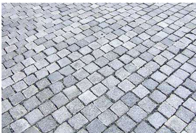
Sposób ułożenia kostki brukowej
