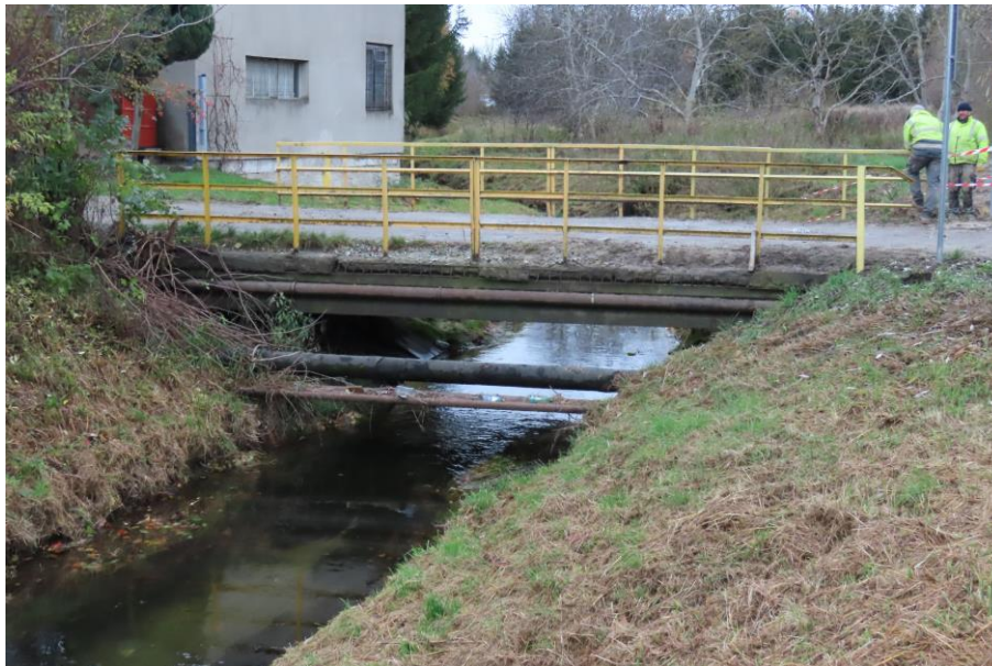
Fot. 1.2. Widok mostu od strony górnej wody
