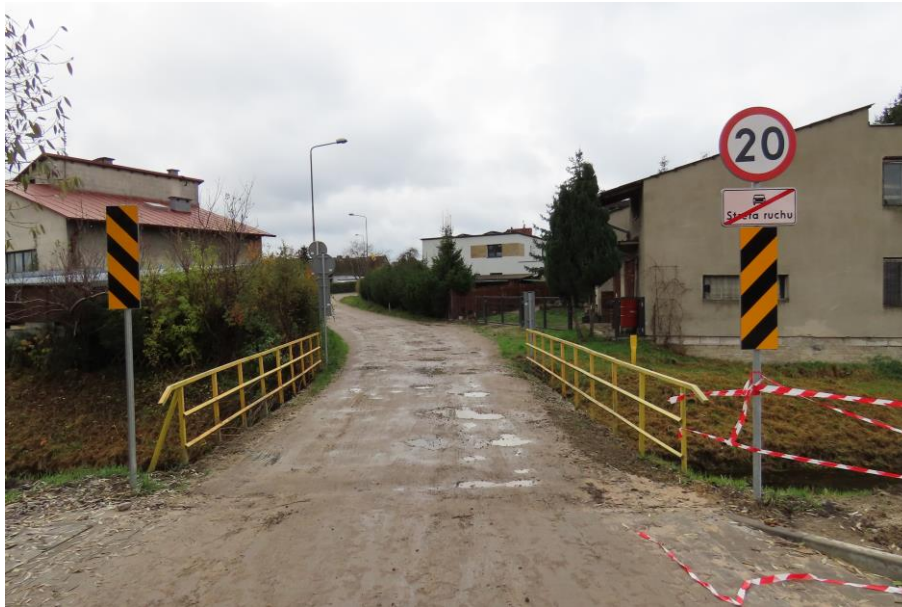
Fot. 1.1. Widok na jezdnię na obiekcie
