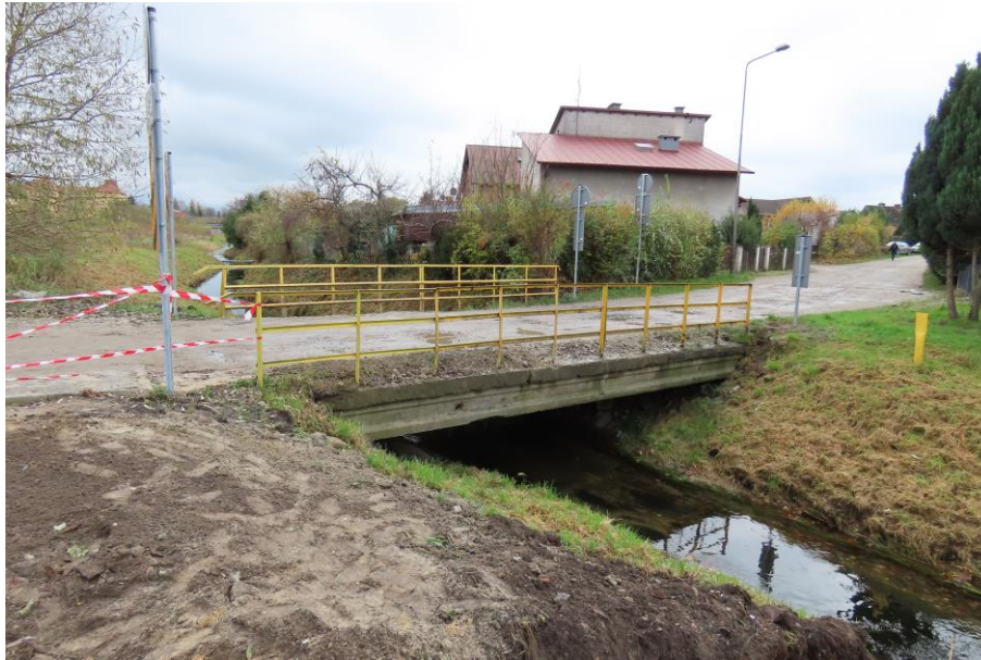
Fot. 1.3. Widok mostu od strony dolnej wody
