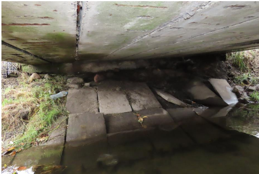
Fot. 1.4. Widok spodu mostu i koryta rzeki pod mostem
