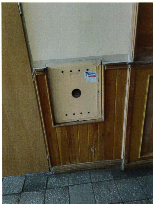
rys. Widok na palne okładziny ścienne /opracowanie własne/.
