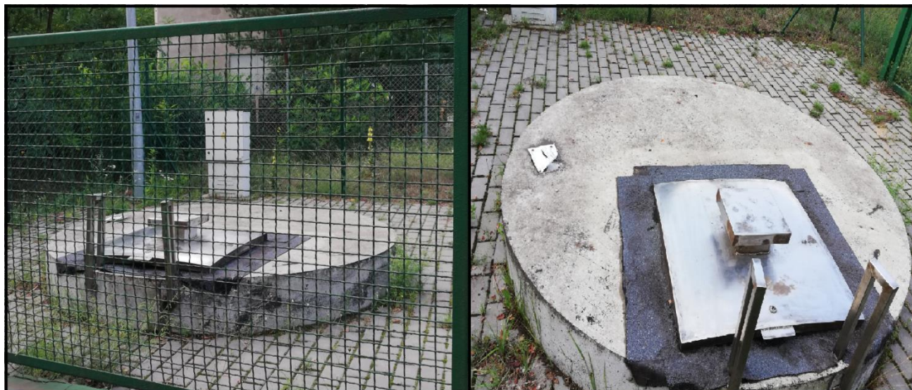
Rysunek 2. Przepompownia wody w Sątopach [źródło: wizja lokalna z dn. 19.07.2019 r.]
