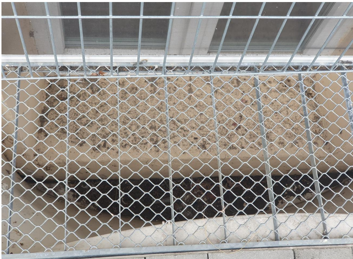
Fot. 39. Zanieczyszczenie studni piwnicznych, konieczne sprawdzenie poprawności izolacji na połączeniu muru ze studnią piwniczną [1.3]
