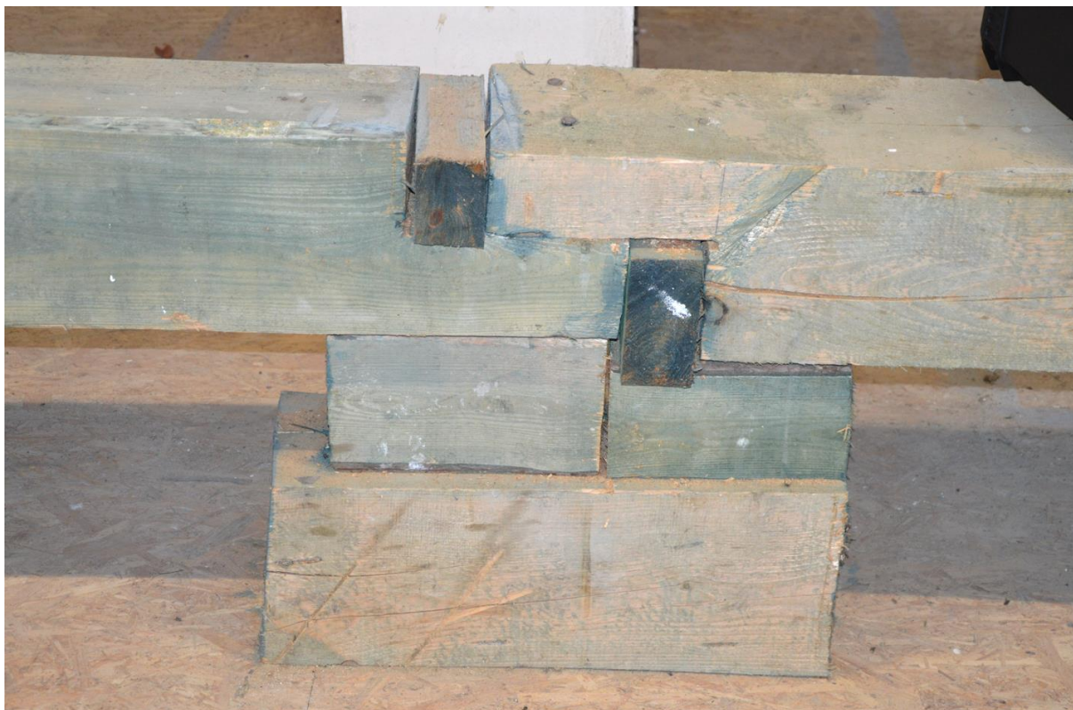
Fot. 25. Podparcie belki dodatkowej w strefie ściany nośnej na 1. piętrze; do wykonania podparcia wykorzystano elementy sztukowane, nieprawidłowo połączone, mniejsze klocki są luźne [1.3]
