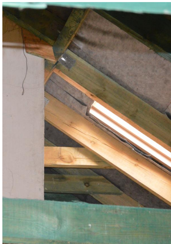
Fot. 32. Brak impregnacji elementów więźby dachowej [1.3]
