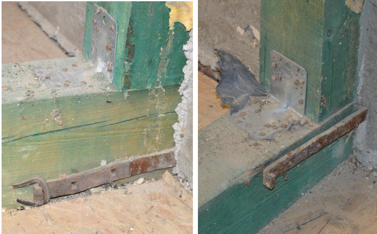
Fot. 21. Pozostawione stare elementy kotwienia podwaliny do ściany szczytowej, obecnie kotwienie nie pracuje, elementy stalowe są luźne [1.3]
