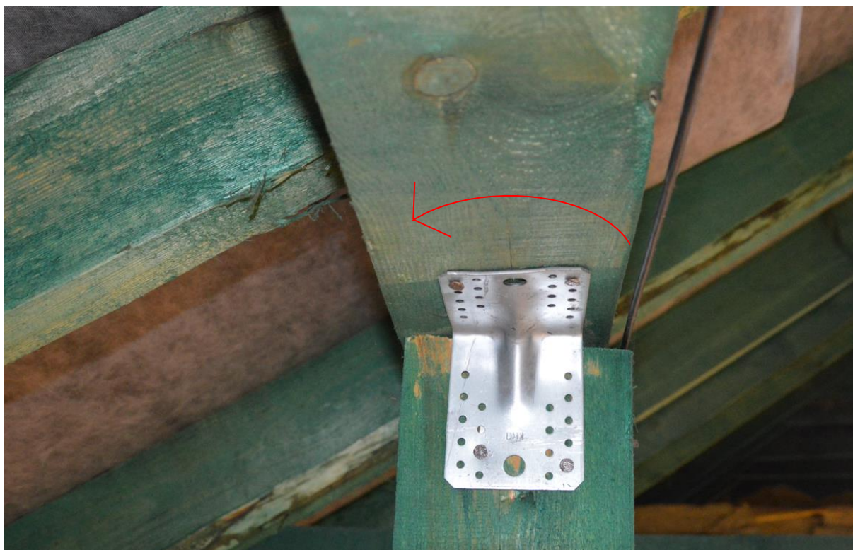
Fot. 15. Wyraźne skrzywienie płatwi na słupach, brak prawidłowego oparcia (docisku) płatwi na słupie [1.4]
