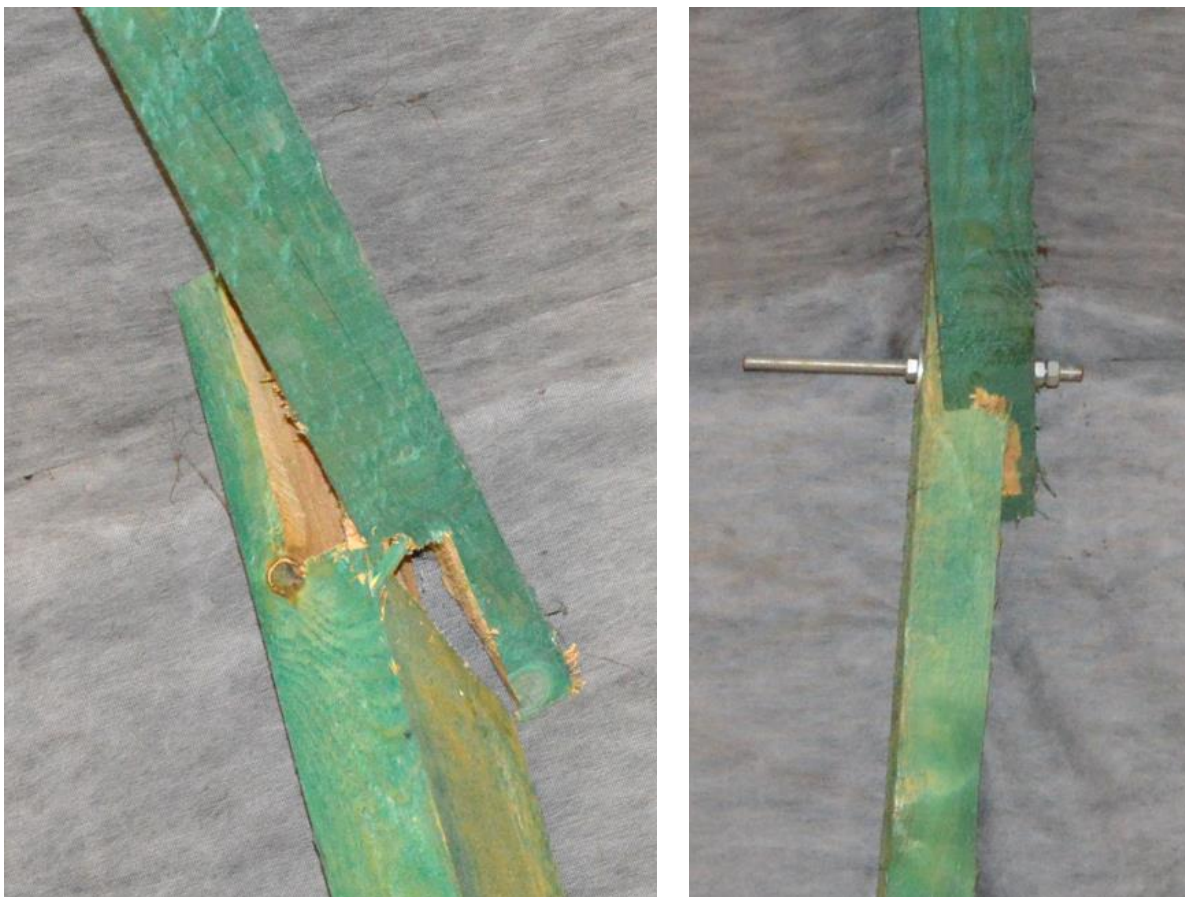
Fot. 3. Skręcenie krokwi, rozejście się połączenia: brak oparcia krokwi w kalenicy (lewe), wtórne połączenie śrubowe skręconych krokwi (prawe) [1.3]
