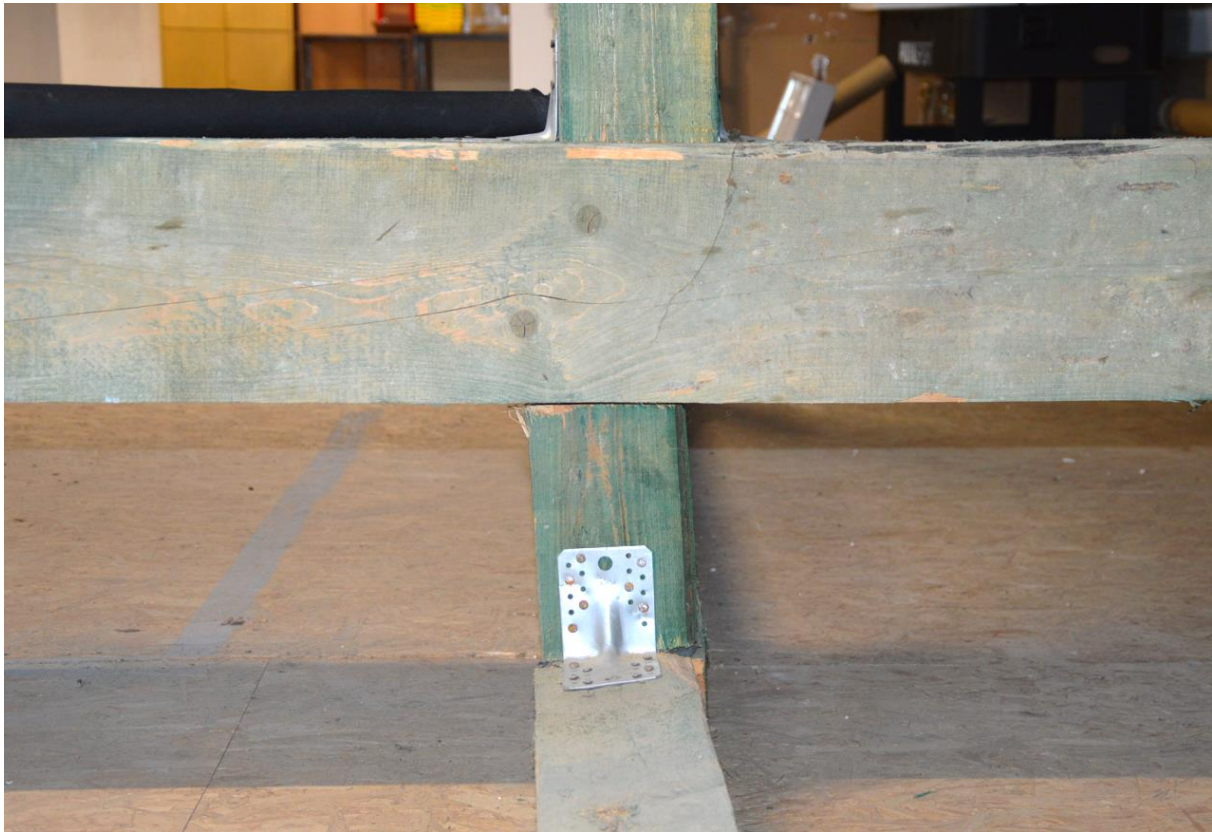
Fot. 19. Skręcenie podwaliny i słupka podpierającego dodatkową belkę „stropową”, brak połączenia dolnego odcinka słupa z dołożoną belką poziomą [1.3]
