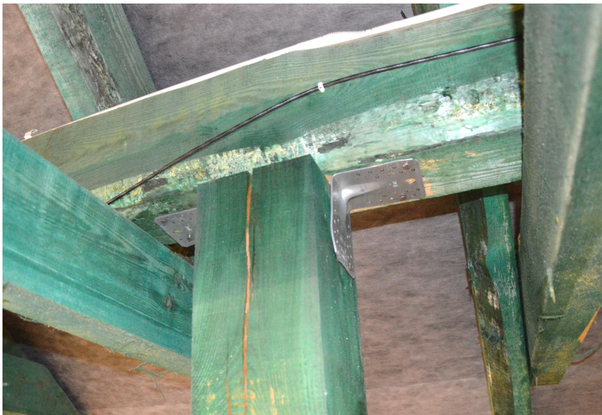
Fot. 31. Płatew pośrednia - przekrój o krawędzi zaokrąglonej: nieprawidłowe przygotowanie elementu do wbudowania w obiekcie budowlanym [1.3]
