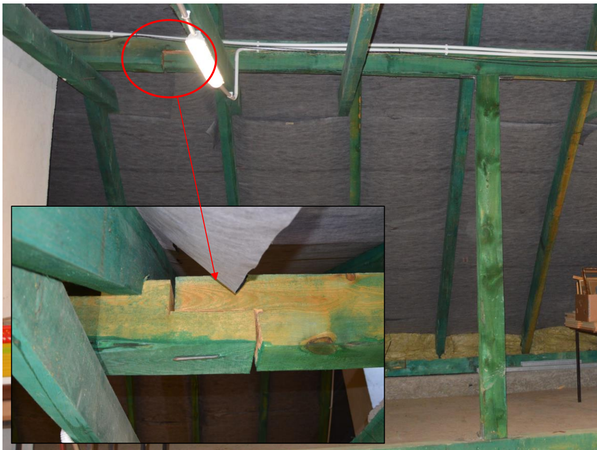
Fot. 14. Wykonanie połączenia płatwi pośredniej w środku rozpiętości między słupami, gdzie występują duże siły zginające; sposób realizacji połączenia nie zapewnia odpowiedniej wytrzymałości oraz współpracy elementów; nie można wykluczyć jednak, że płatew jest częściowo oparta na kominie, co nie jest prawidłowe [1.3]
