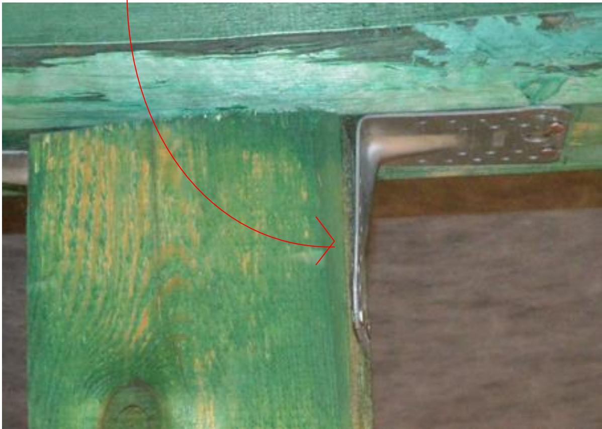
Fot. 13. Wyraźna deformacja kątownika ciesielskiego mocowanego łącznie czterema gwoździami (2 gwoździe na ramię kątownika) [1.3]
