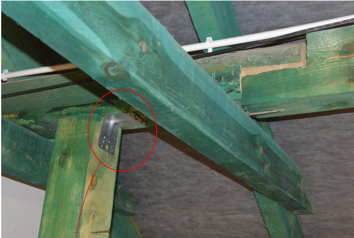
Fot. 12. Odwrócenie połączenia płatwi pośredniej (połączenie na nakładkę prostą), połączenie jest stabilizowane jednym gwoździem budowlanym; płatew lokalnie jest zaokrąglona (złe przygotowanie elementu) [1.3]
