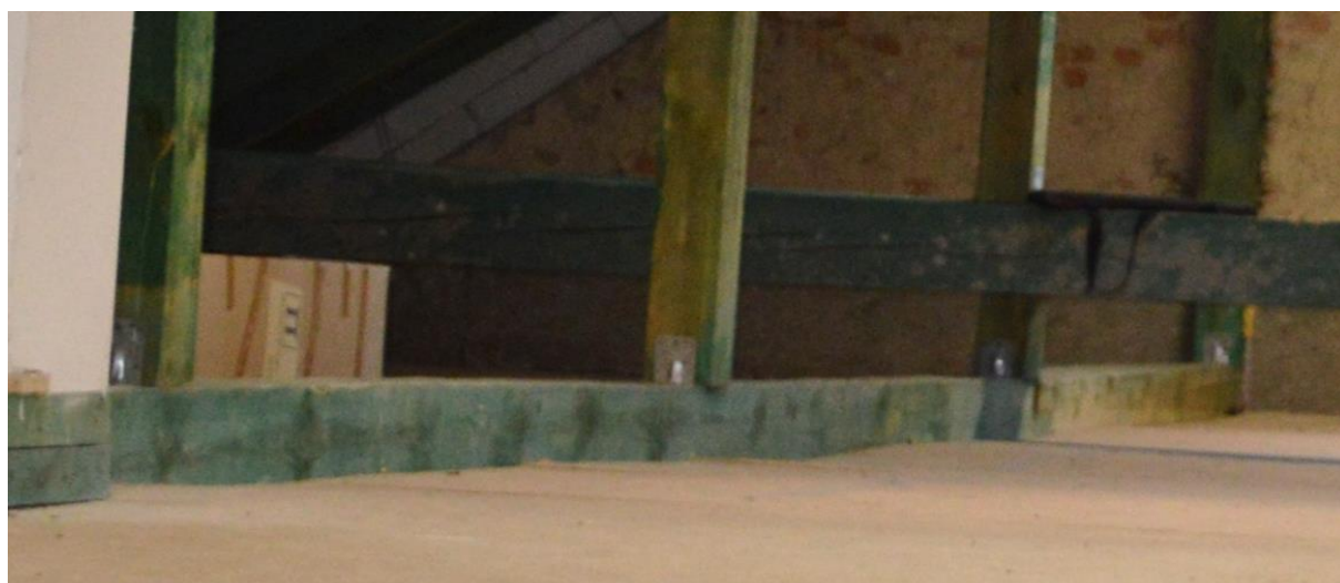
Fot. 18. Widoczne deformacje podwaliny i podłogi z płyt OSB [1.3]
