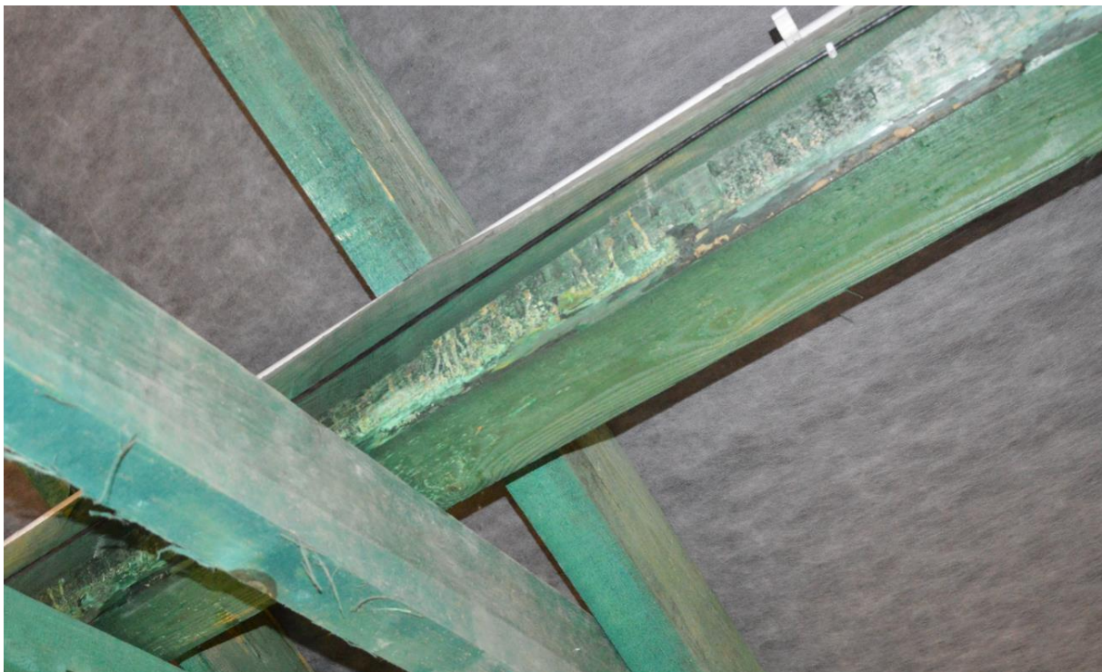
Fot. 30. Płatew pośrednia - przekrój o krawędzi zaokrąglonej: nieprawidłowe przygotowanie elementu do wbudowania w obiekcie budowlanym [1.3]
