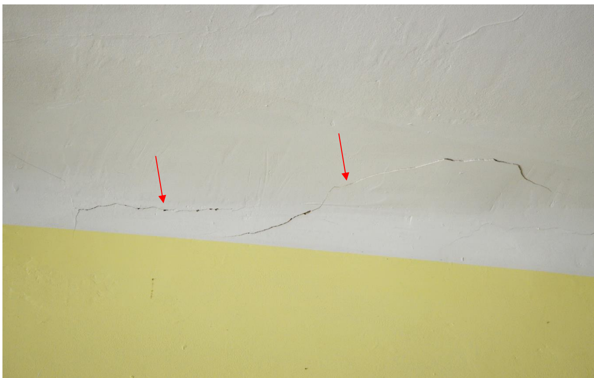
Fot. 38. Zarysowanie w narożu ściana – strop w klasie 5 [1.3]
