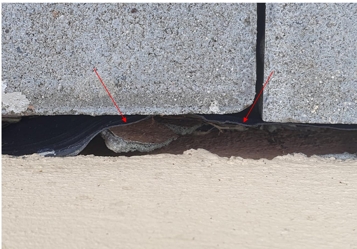
Fot. 40. Brak zabezpieczenia folii kubelkowej – możliwość przenikania wody opadowej między mur i folię [1.3]
