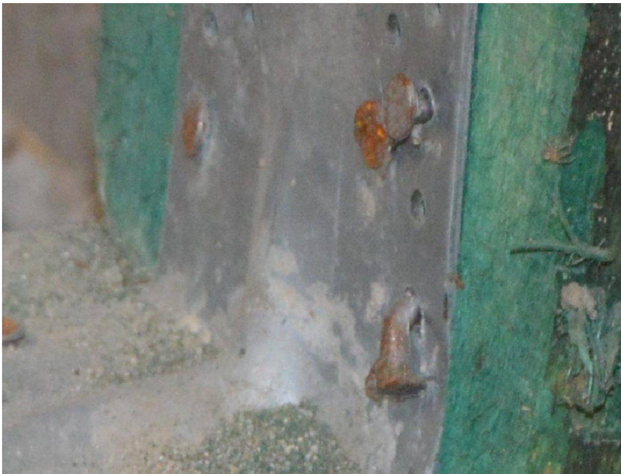
Fot. 28. Stosowanie do połączeń zwykłych gwoździ budowlanych [1.3]
