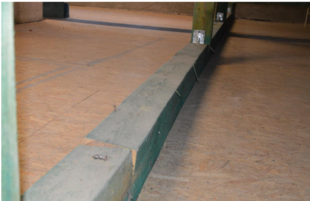
Fot. 16. Skręcenie podwaliny [1.3]
