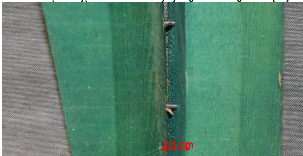
Fot. 8. Łączenie jętek z krokwiami zwykłymi gwoździami gładkimi: w efekcie skrócenie jętek, powstanie szczelin między elementami o szerokości nawet 2,5 cm, brak współpracy elementów [1.3]
