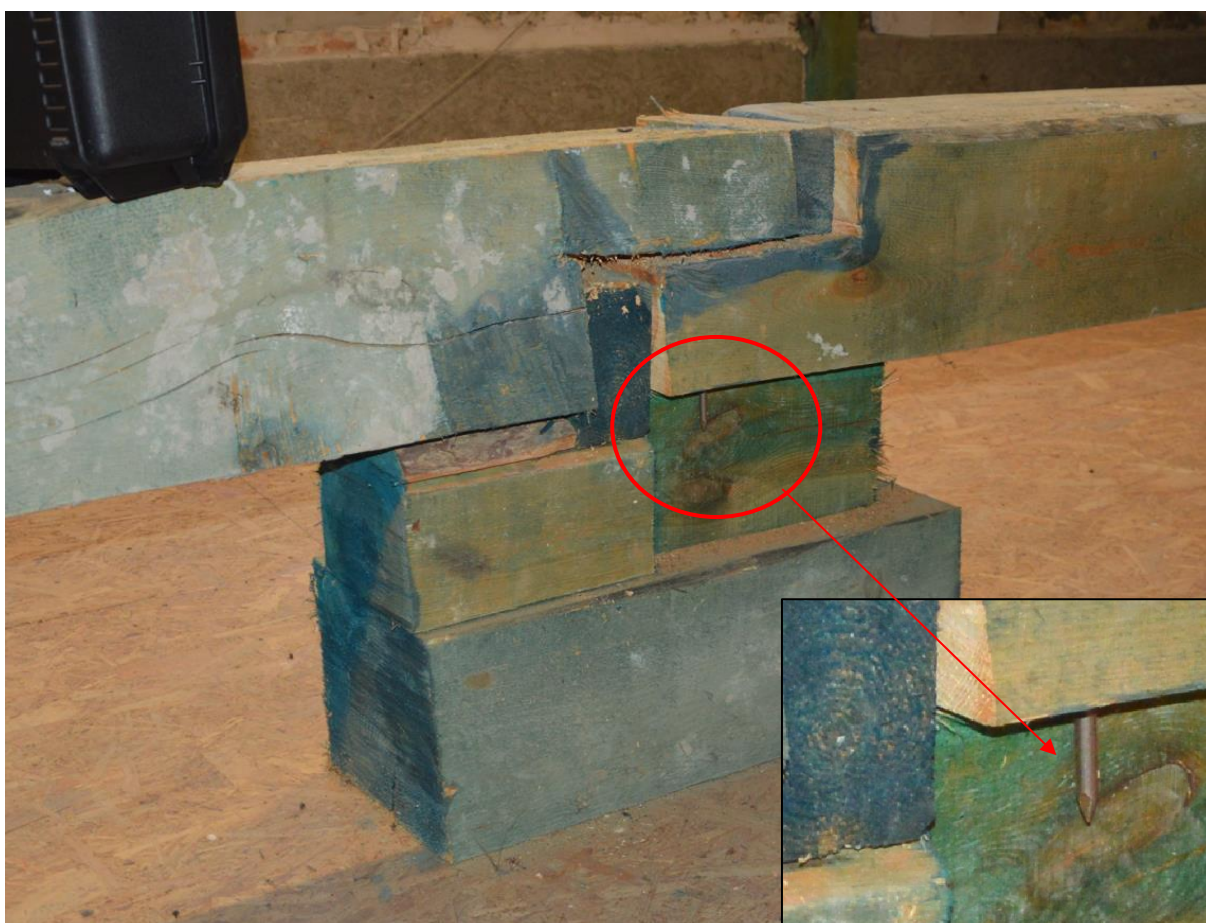
Fot. 26. Podparcie belki dodatkowej w strefie ściany nośnej na 1. piętrze; do wykonania podparcia wykorzystano elementy sztukowane, nieprawidłowo połączone (widoczne gwoździe, luźne klocki) [1.3]
