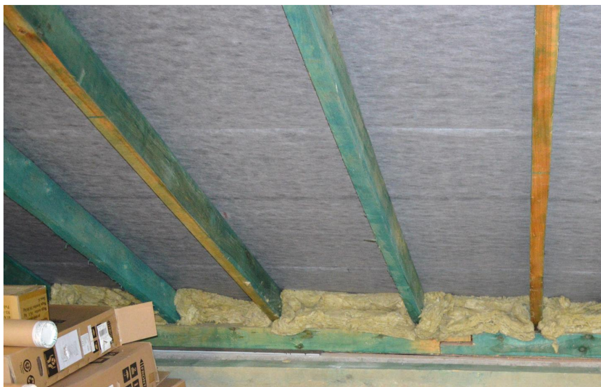
Fot. 34. Niepełna impregnacja elementów więźby dachowej [1.3]
