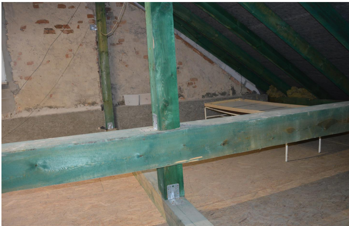
Fot. 23. Dodatkowa belka "stropowa" dołożona na etapie realizacji (poza dokumentacją projektową); belka nie przenosi obciążeń z więźby na ściany nośne, a jedynie dociąża podwalinę, a więc i belki starego stropu drewnianego [1.3]
