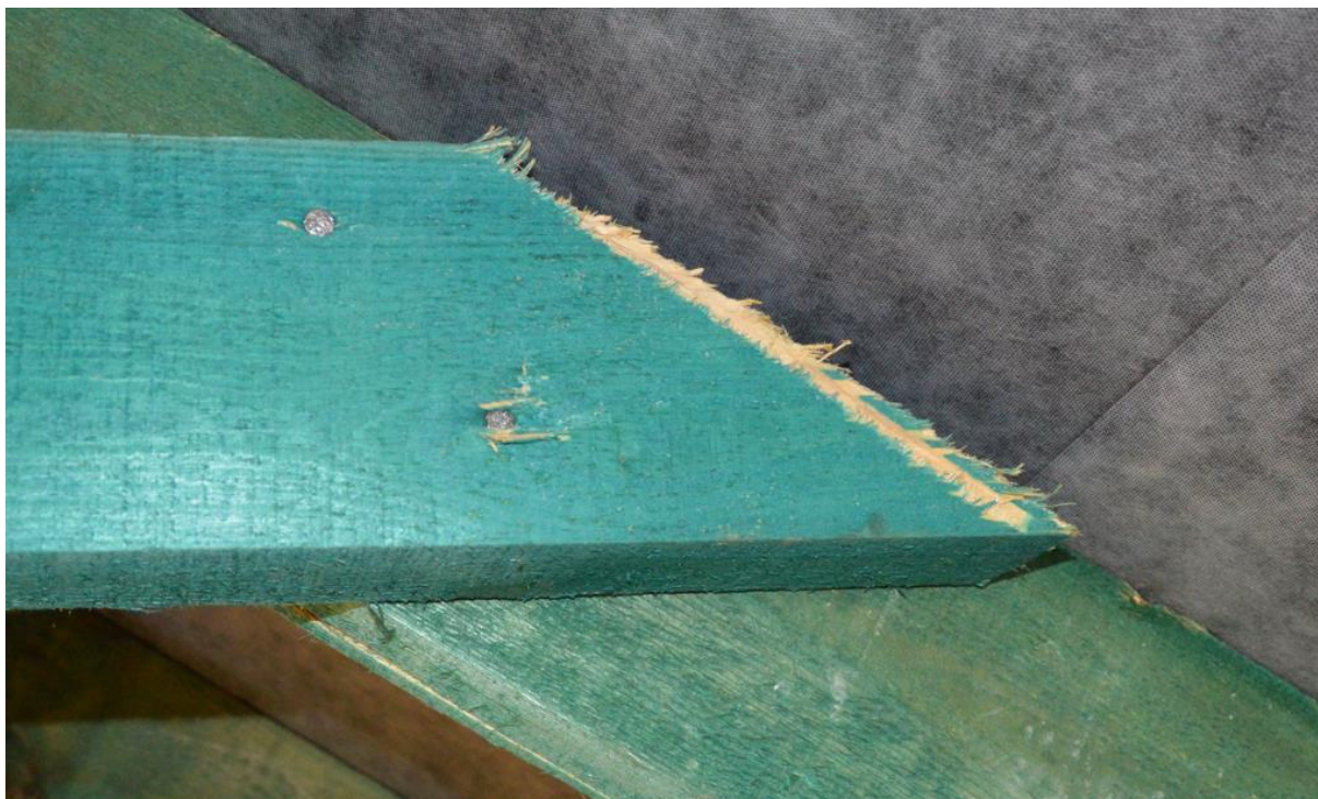
Fot. 35. Brak impregnacji jętki po docięciu [1.3]
