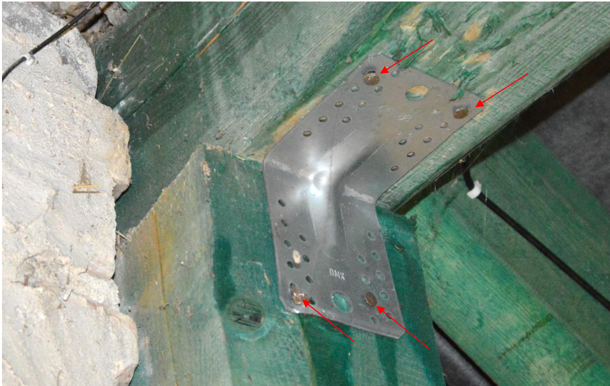
Fot. 27. Połączenie słupa z płytą pośrednią: zastosowanie czterech gwoździ do montażu kątownika ciesielskiego (zbyt mała ilość łączników, nieprawidłowy typ łączników) [1.3]
