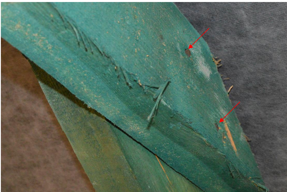
Fot. 7. Łączenie jętek z krokwiami zwykłymi gwoździami gładkimi [1.3]
