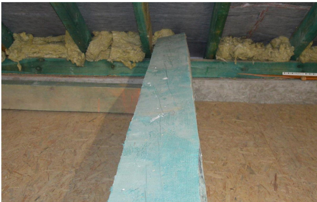
Fot. 24. Wyraźne skrzywienie dołożonej belki "stropowej", belka nie jest zamocowana do murłaty [1.3]
