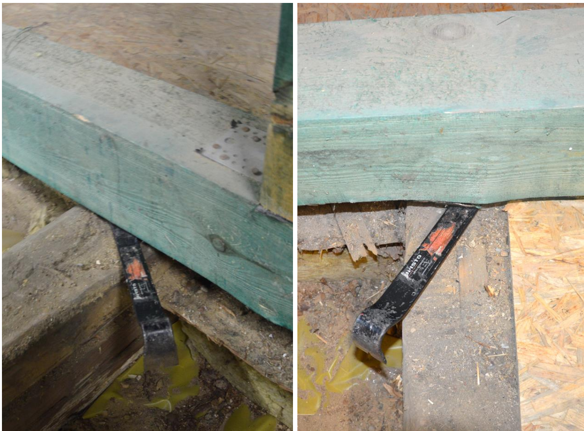
Fot. 20. Brak oparcia belki podwalinowej na sąsiednich belkach stropowych bezpośrednio przy słupie więźby dachowej [1.3]
