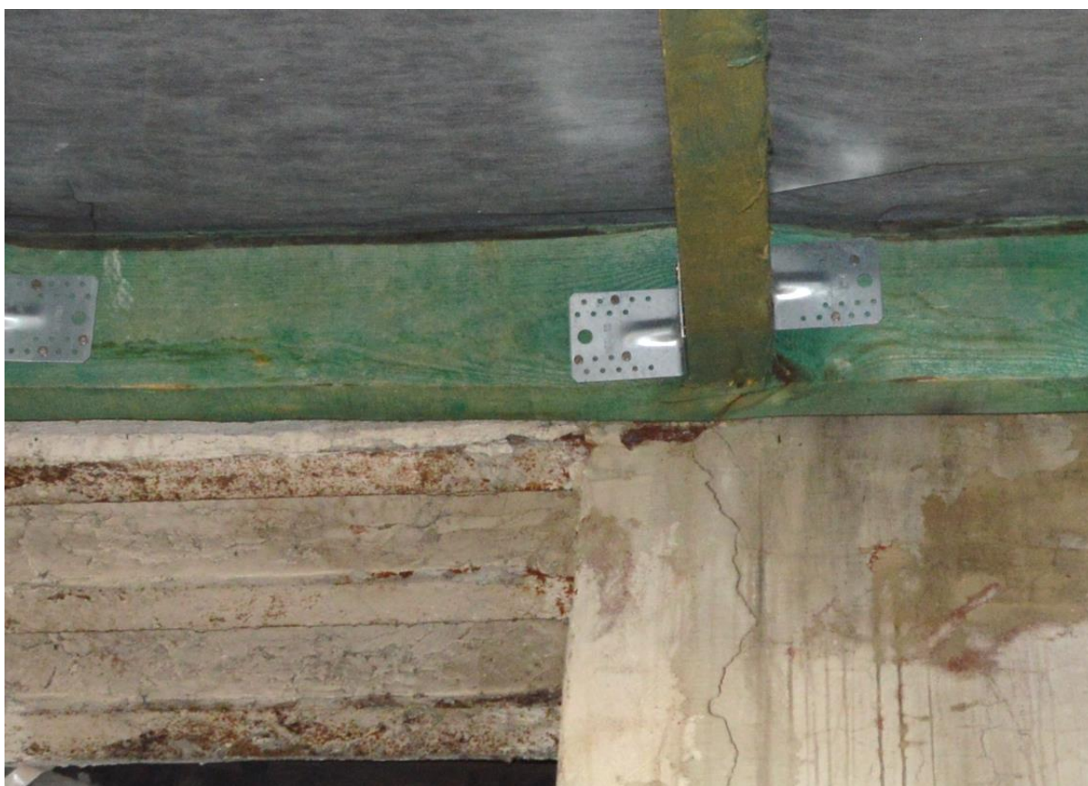
Fot. 36. Zabudowa wymianu przy kominie bezpośrednio przy powierzchni komina bez zachowania wymaganej odległości 30 cm (jak dla kominów niezabezpieczonych okładziną ogniochronną) [1.3]
