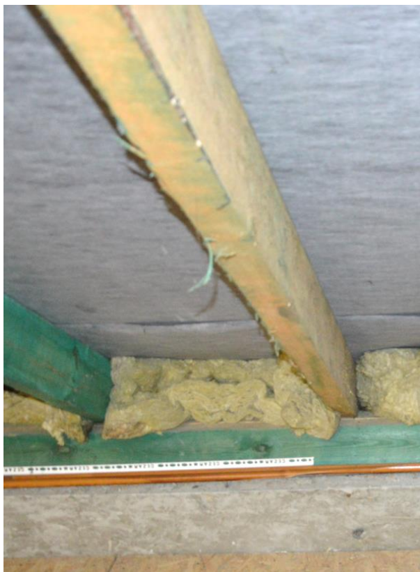
Fot. 32. Brak impregnacji elementów więźby dachowej [1.3]
