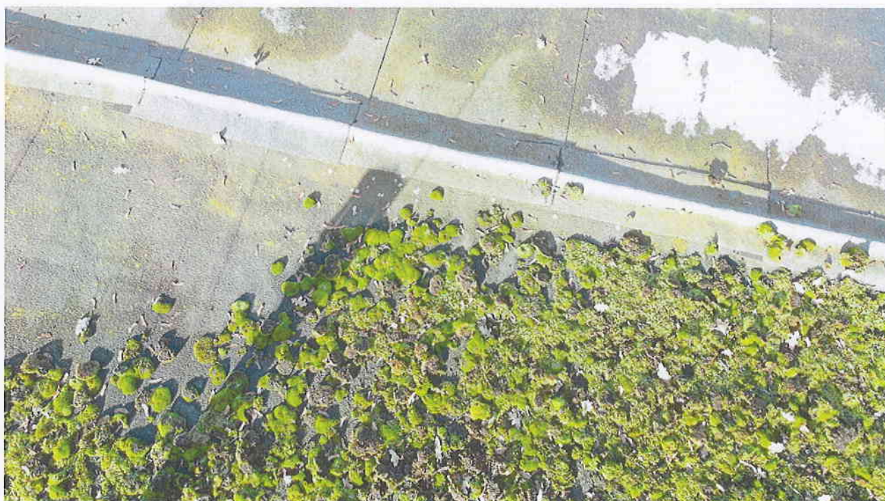
Widok pokrycia dachowego – zdjęcie poglądowe
