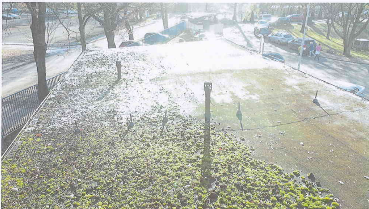
Widok pokrycia dachowego – zdjęcie poglądowe
