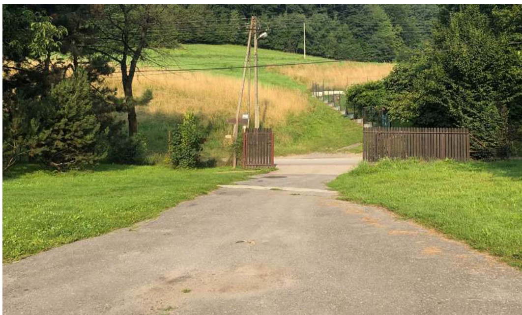
Fot. 1 Miejsce lokalizacji przebudowywanych dojazdów do projektowanej kancelarii rok 2022 r.
