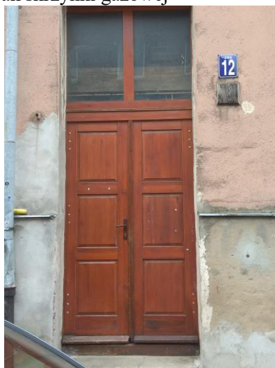
Zdjęcie nr 3 – Fragment elewacji frontowej (zachodniej) – ślady zawilgocenia cokołu z prawej strony drzwi wejściowych,
