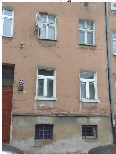
Zdjęcie nr 3 – Fragment elewacji frontowej (zachodniej) – ślady zawilgocenia cokołu z prawej strony drzwi wejściowych,
