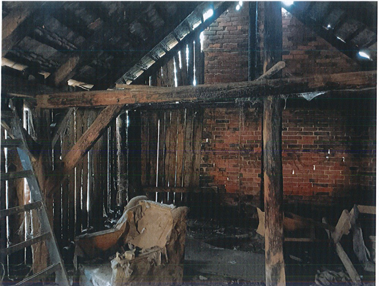
Fotografia nr 4 (konstrukcja budynku)
