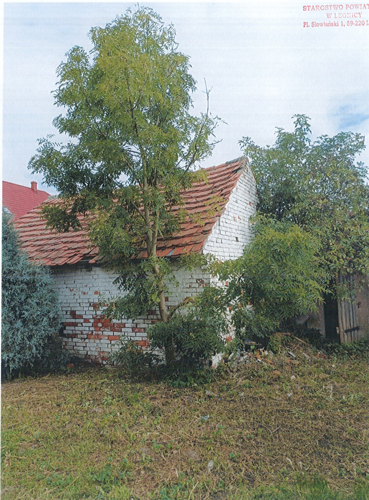
Fotografia nr 2 (budynek od strony południowej )
