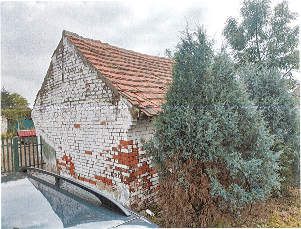
Fotografia nr 1 (budynek od strony zachodniej)
