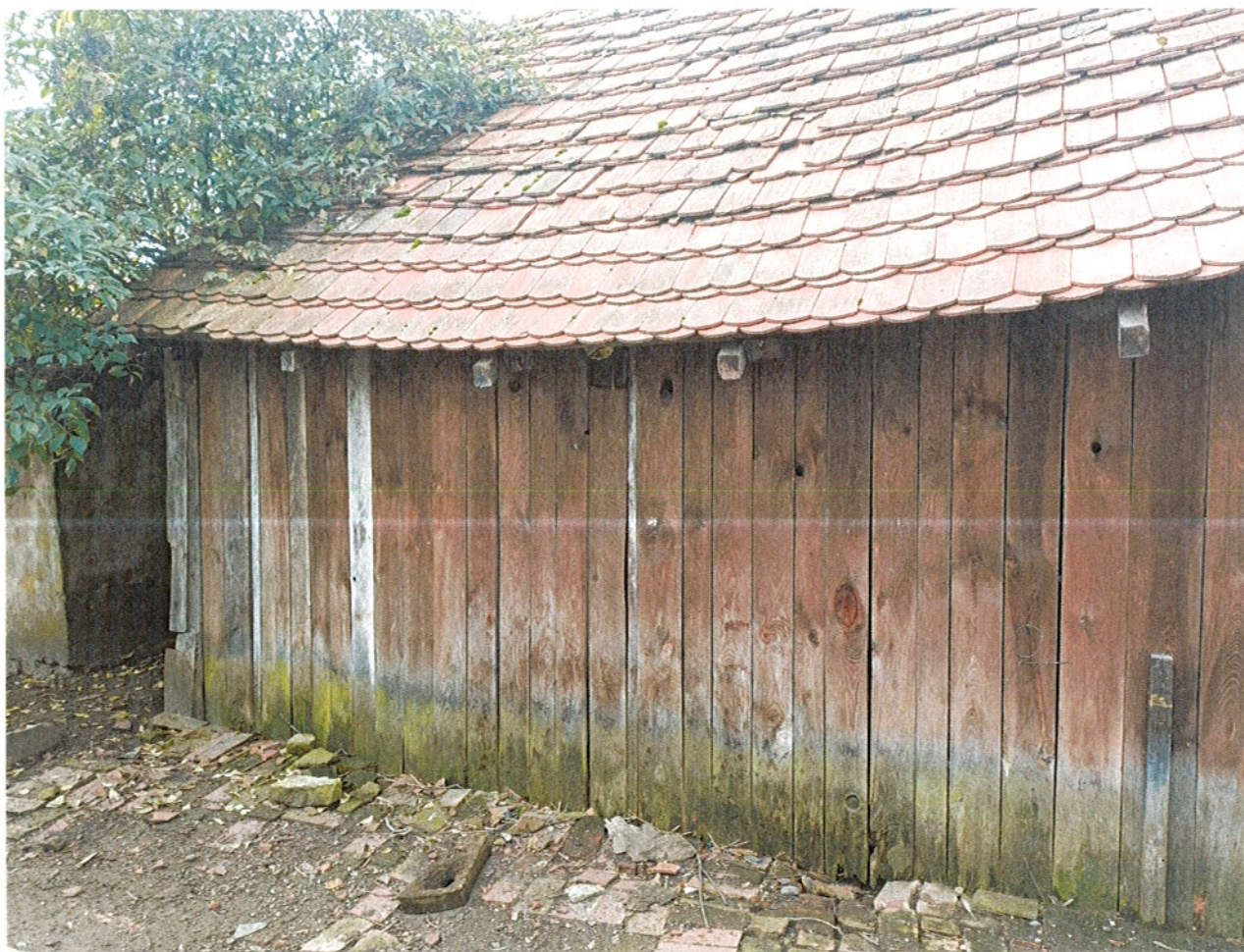
Fotografia nr 3 (ściana szczytowa budynku od strony północno-wschodniej)
