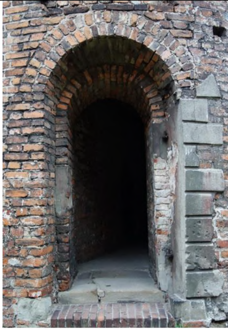
Drzwi nr 24 do latarni
