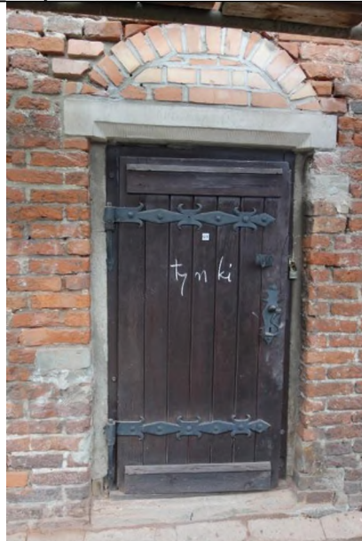
Nr 4 – ślad po haku od zawiasu montowanym od strony wnętrza
