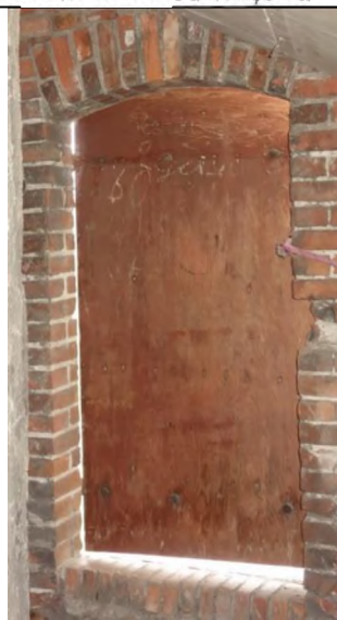
Drzwi 23 od strony wnętrza
