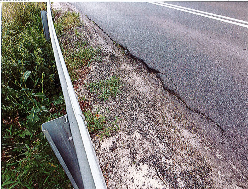
Fot. 5. Ubytki asfaltu nawierzchni jezdni
