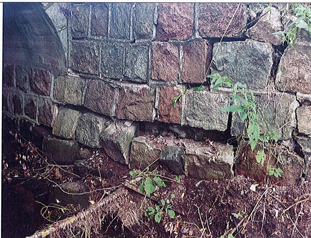
Fot. 4. Uszkodzenia łączników kamienia, przemieszczenia, ubytki kamienia głowicy wylotu
