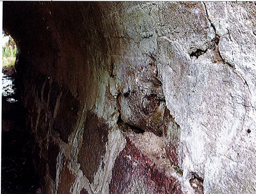
Fot. 3. Ubytki betonu i kamienia na sklepieniu górnym oraz ścianach bocznych
