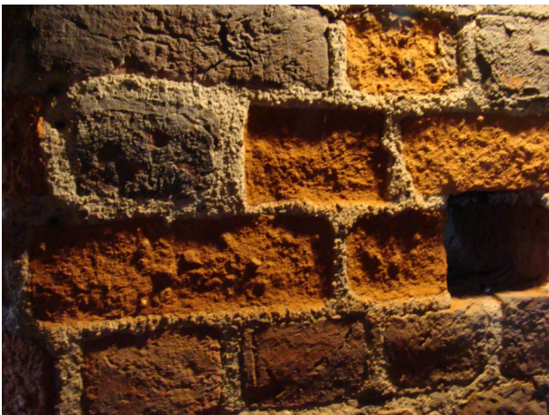
fot. 19: przykład zasolonych i głęboko pudrujących się cegieł we wnętrzu baszty
