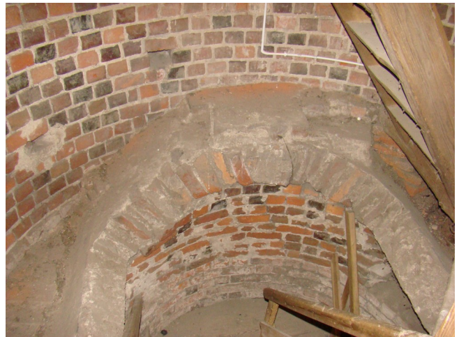
fot. 29: pozostałość wtórnego XVIIw. sklepienia między poziomami A i B
