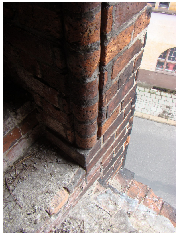
fot. 31: wyjście na niezachowane mury obronne; widoczne profilowane cegły ościeży
