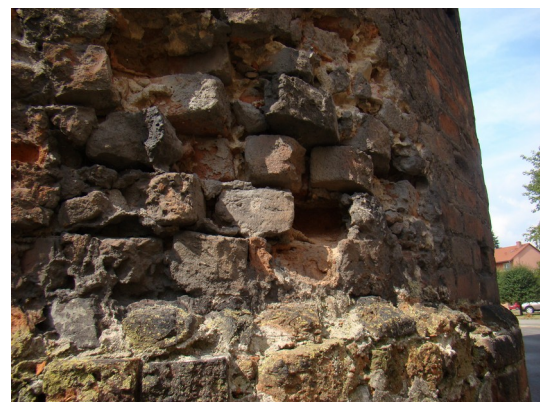
fot. 7: zdestruowane strzępia po stronie wschodniej
