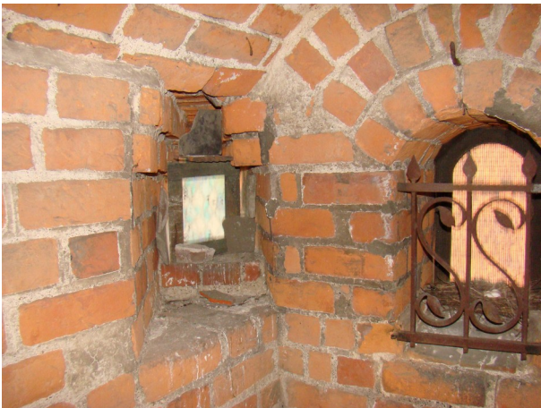
fot. 34: dodatkowa szczelina strzelnicza po lewej od szczeliny właściwej na poziomie D
