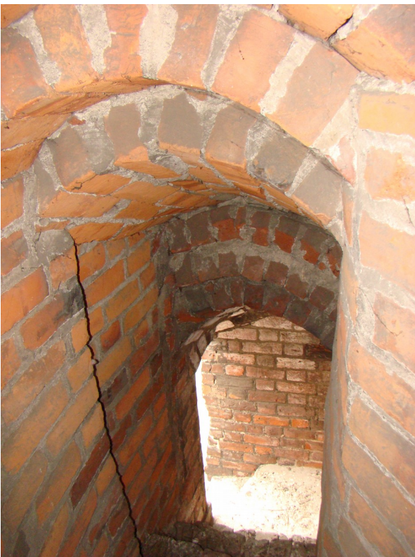
fot. 30: korytarz przejścia na mury obronne
