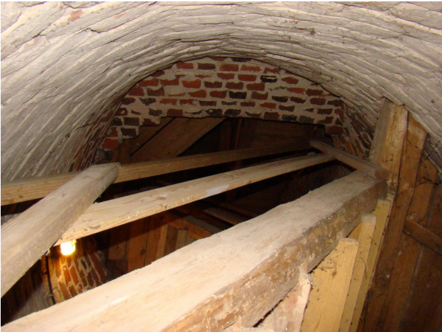
fot. 28: górna część wnętrza poziomu A; widoczne wielokrotnie powtarzane bielone ścian i przejście schodami drabiniastymi przez zniszczone wtórne sklepienie, nigdy nie bielone
