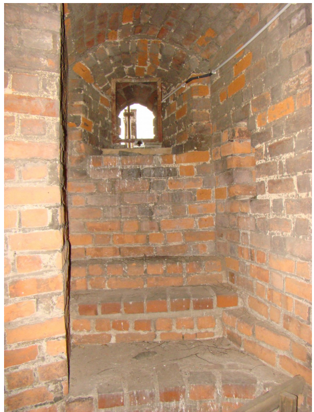
fot. 35: okno z dojściem po schodkach do szczeliny strzelniczej na poziomie E
