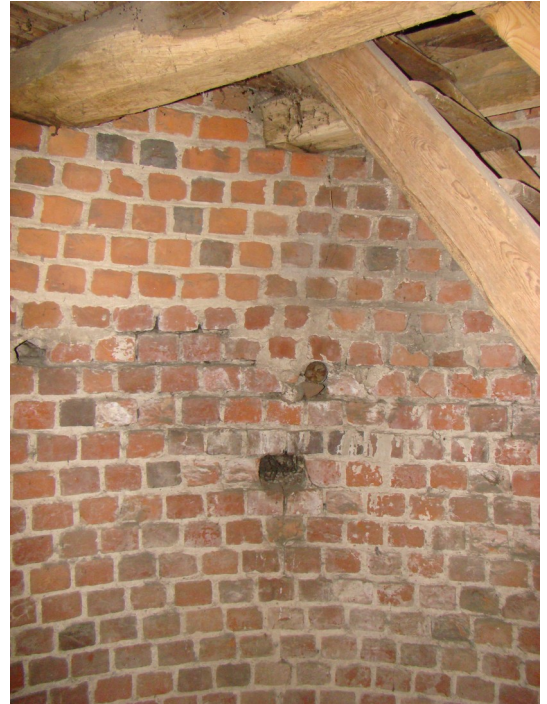
fot. 13: widoczna na wysokości 9,5 m linia dzieląca wewnątrz dwie fazy chronologiczne budowy baszty
