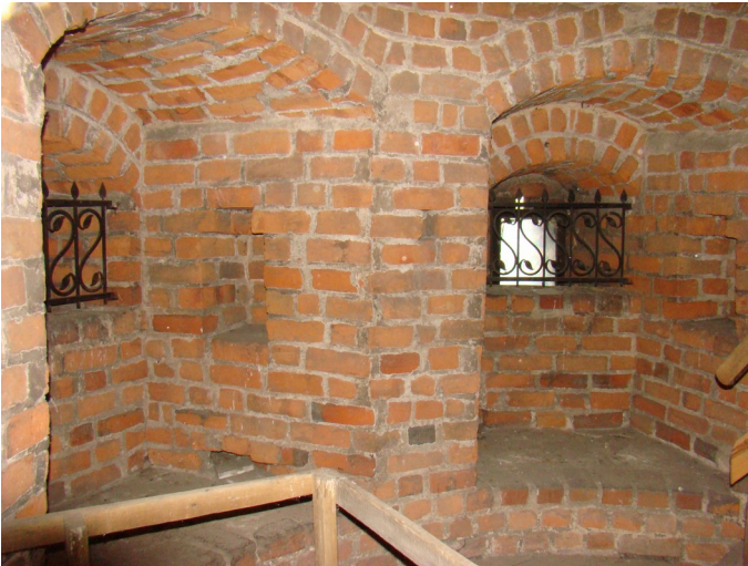
fot. 32: stanowiska strzeleckie z otworami szczelinowymi na poziomie C
