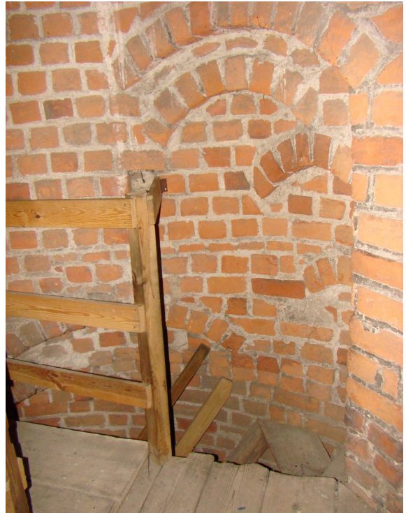
fot. 33: wsparte na łukach zagłębienie w murze między poziomami C i D, pozostałe po wygospodarowaniu dodatkowej przestrzeni w ciągu komunikacyjnym
