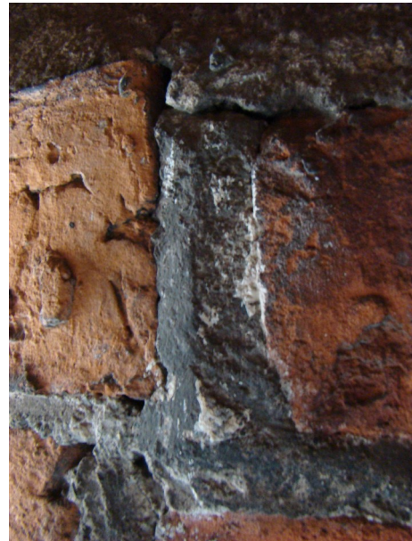
fot. 25: sposób opracowania pierwotnej spoiny w górnej (młodszej części baszty), opracowanie w klin, zachowane w ościeżu jednego z okien
