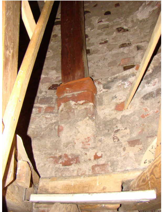
fot. 37: belka więźby w hełmie wsparta na występie muru bezpośrednio na cegle
