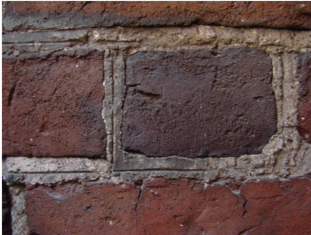
fot. 24: sposób opracowania pierwotnej spoiny w dolnej (starszej części baszty), opracowanie poprzez zacięcie linią, zachowane w ościeżu jednego z okien
