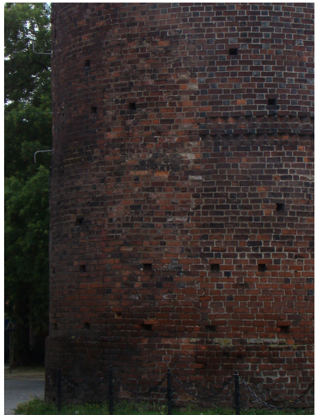
fot. 8: przemurowana powierzchnia muru w miejscu dawnego połączenia z murem obronnym po stronie północnowschodniej
