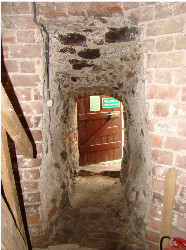
fot. 26: dolne wejście do baszty; widoczny przekrój muru w nieregularnym korytarzu przejścia
