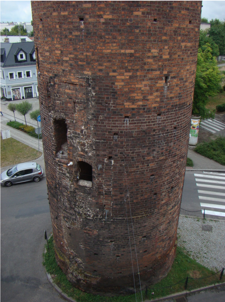
fot. 12: widoczna na wysokości 11 m linia dzieląca z zewnątrz dwie fazy chronologiczne budowy baszty
