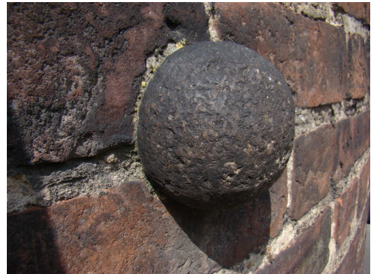
fot. 14: jedna z granitowych kul wmurowanych w lico muru
