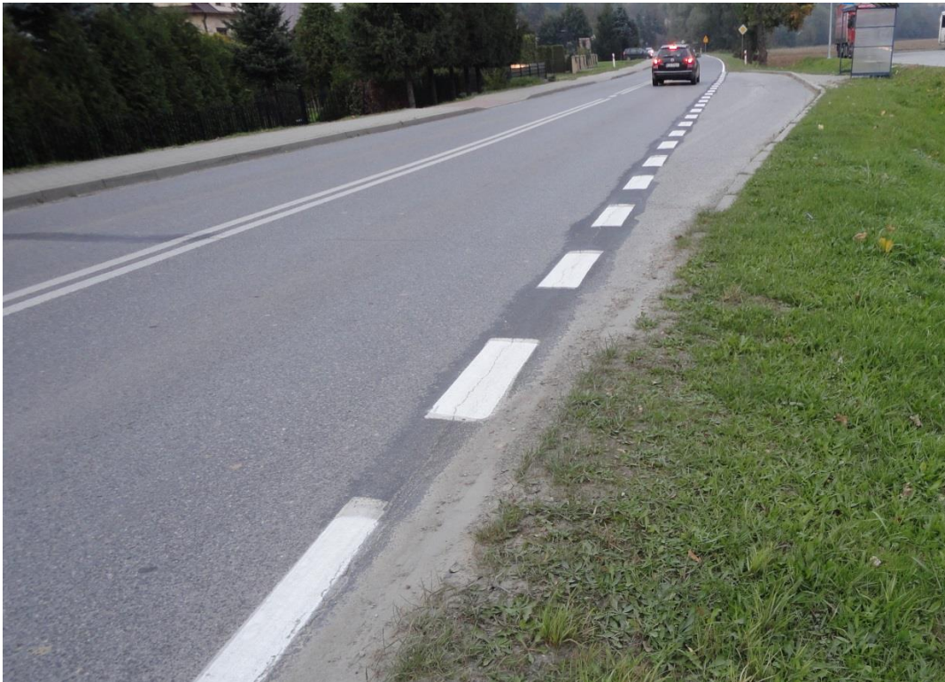
Fot. 2 . Rejon planowanego dojścia do przystanku autobusowego – widok w kierunku Tarnowa.
