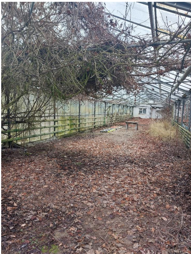
Fot. 4. Szklarnia przyległa do budynku nr 7.
