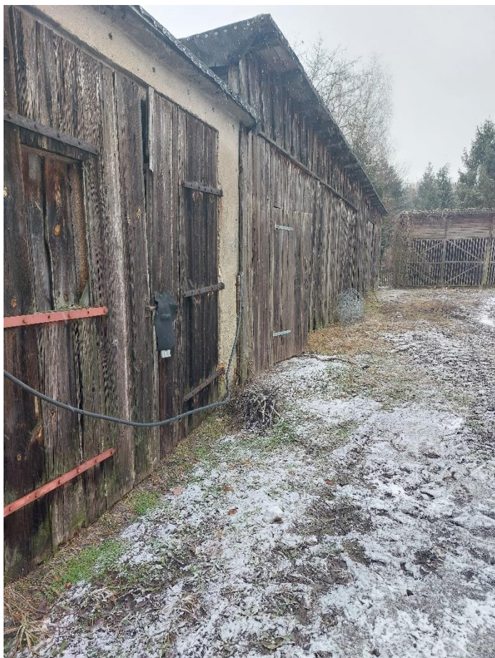
Fot. 9. Obiekt murowany nr 4.
