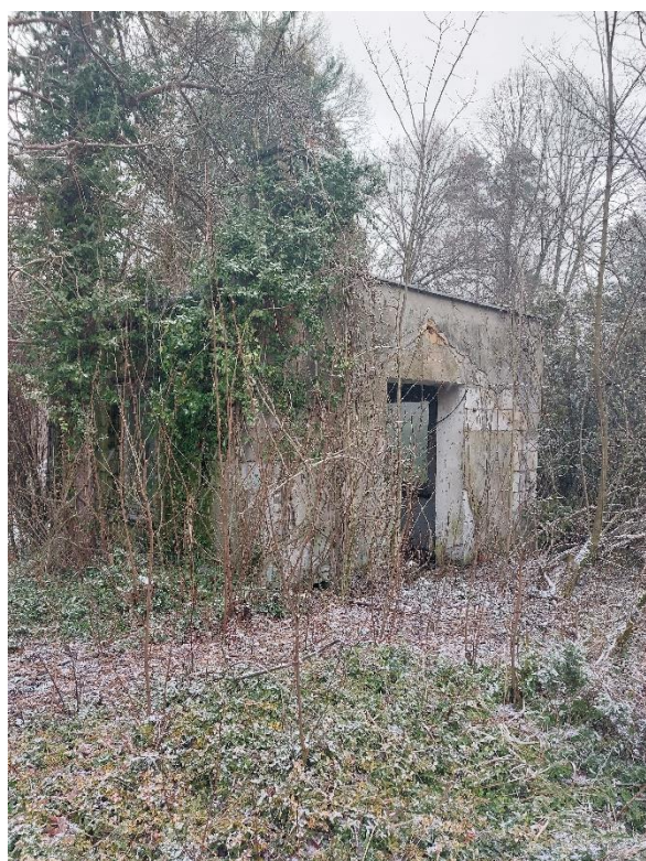
Fot. 12. Obiekt murowany nr 6.
