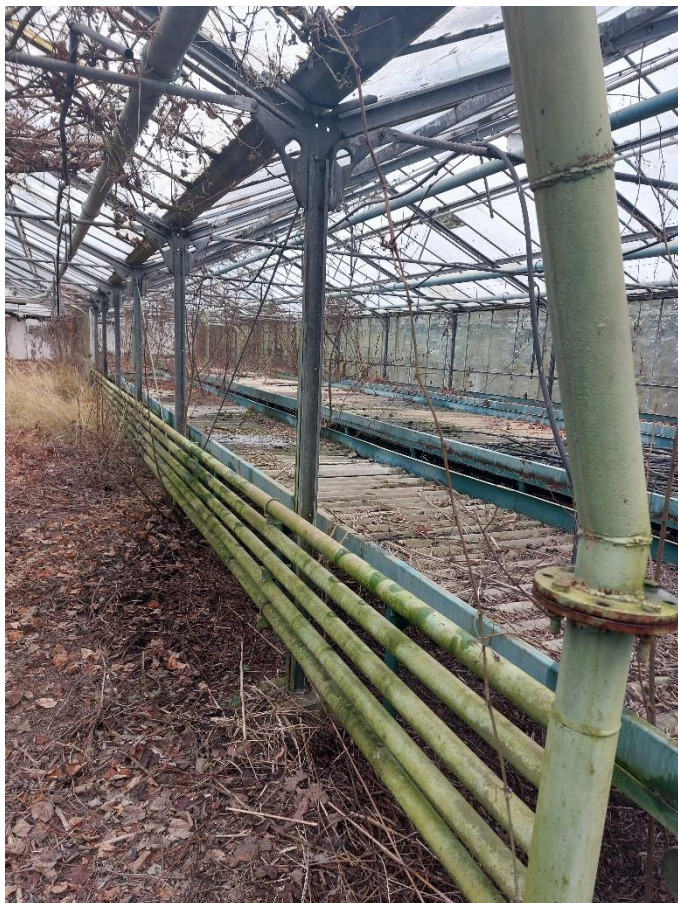
Fot. 6. Szklarnia przyległa do budynku nr 7.
