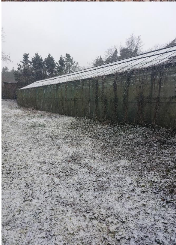
Fot. 5. Szklarnia przyległa do budynku nr 7.
