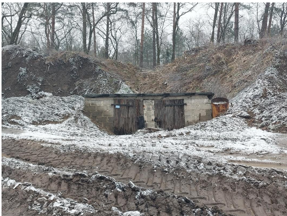
Fot. 13. Obiekt murowany nr 2.
