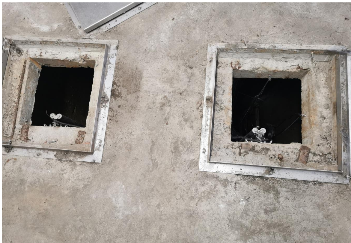
Rysunek 4 Włazy rewizyjne stan istniejący
