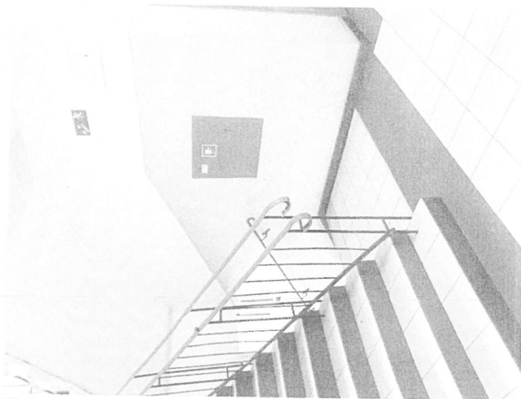
Klatka schodowa otwarta
