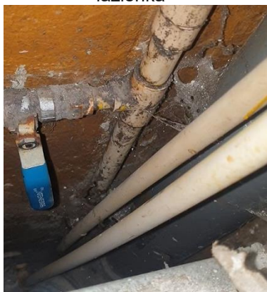
Pion kanalizacyjny/wodociągowy – łazienka
