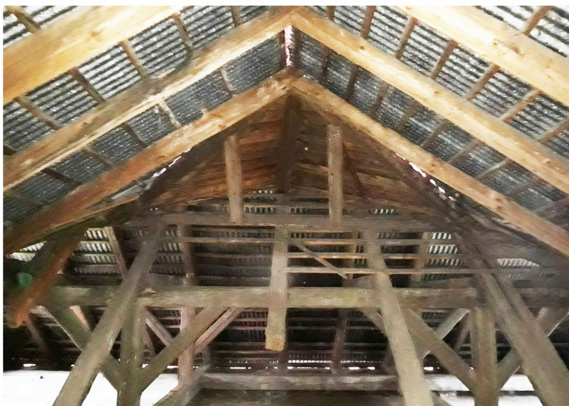
połączenie starej i nowej więźby dachowej , sierpień 2018r.
