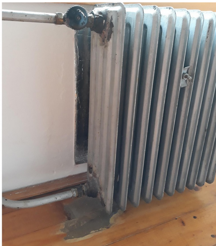
pokoje mieszkalne: zardzewiałe grzejniki i kapiąca woda dewastująca podłogę, sierpień 2018 r
