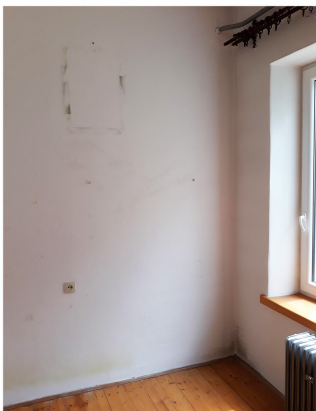
zagrzybenie ścian z destrukcją tynków wewnętrznych w pokoju nr 5, sierpień 2018r.
