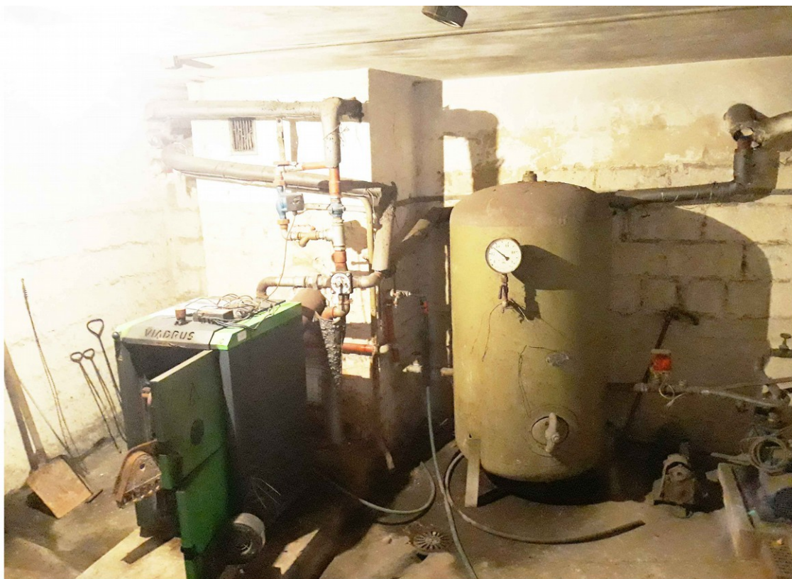
kotłownia: urządzenia kocioł, hydrofor, instalacje, sierpień 2018 r
