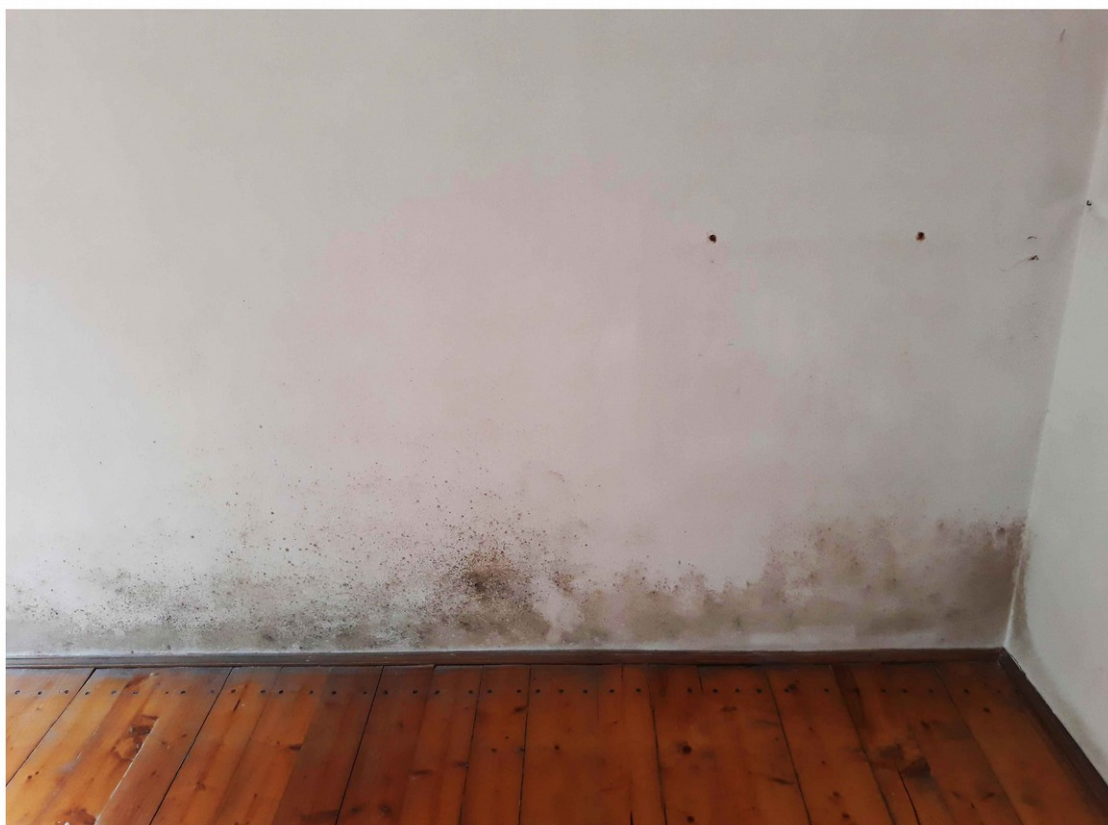
pokoje mieszkalne: zagrzybiałe ścianym zawilgocone z odpadającym tynkiem, sierpień 2018 r
