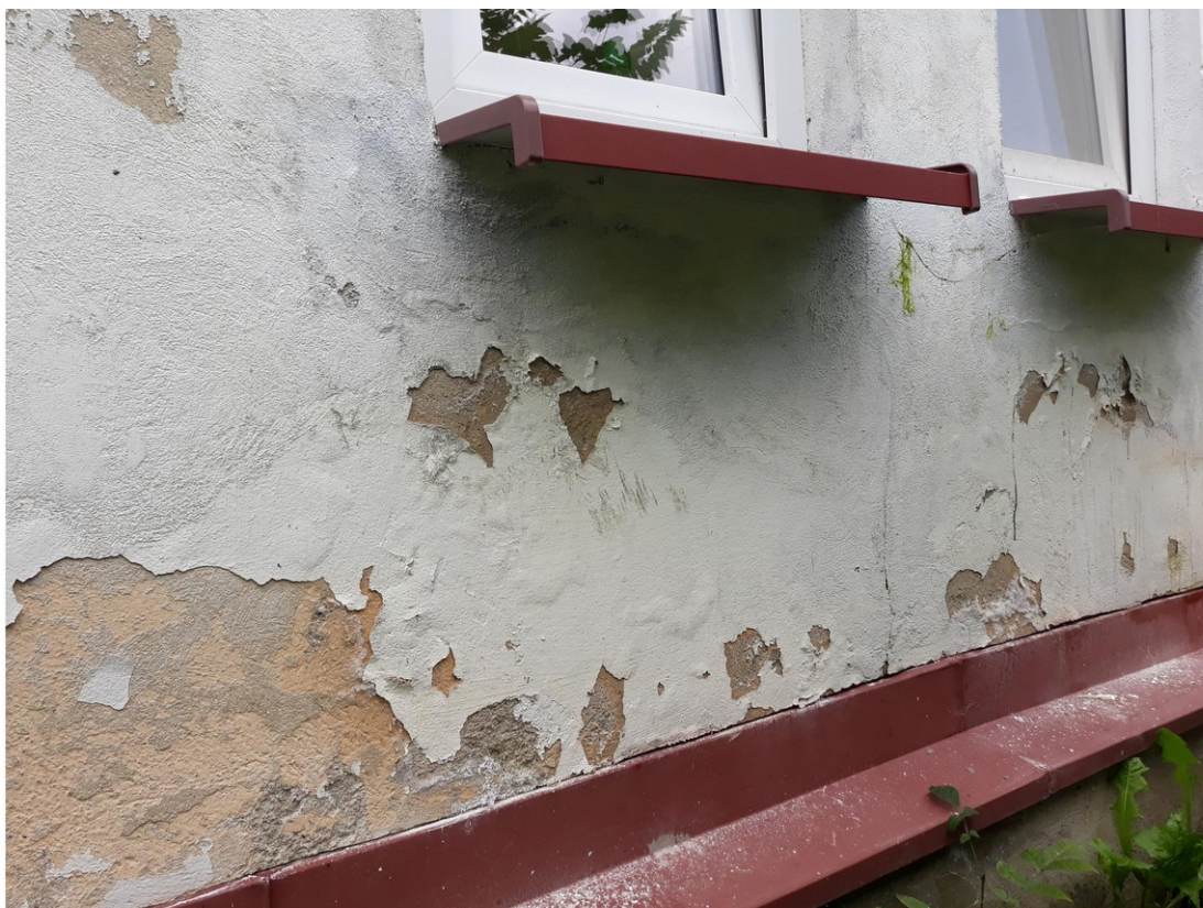
Elewacja od strony północnej z widoczną białą grzybnią i początkiem destrukcji tynków zew, sierpień 2018r.
