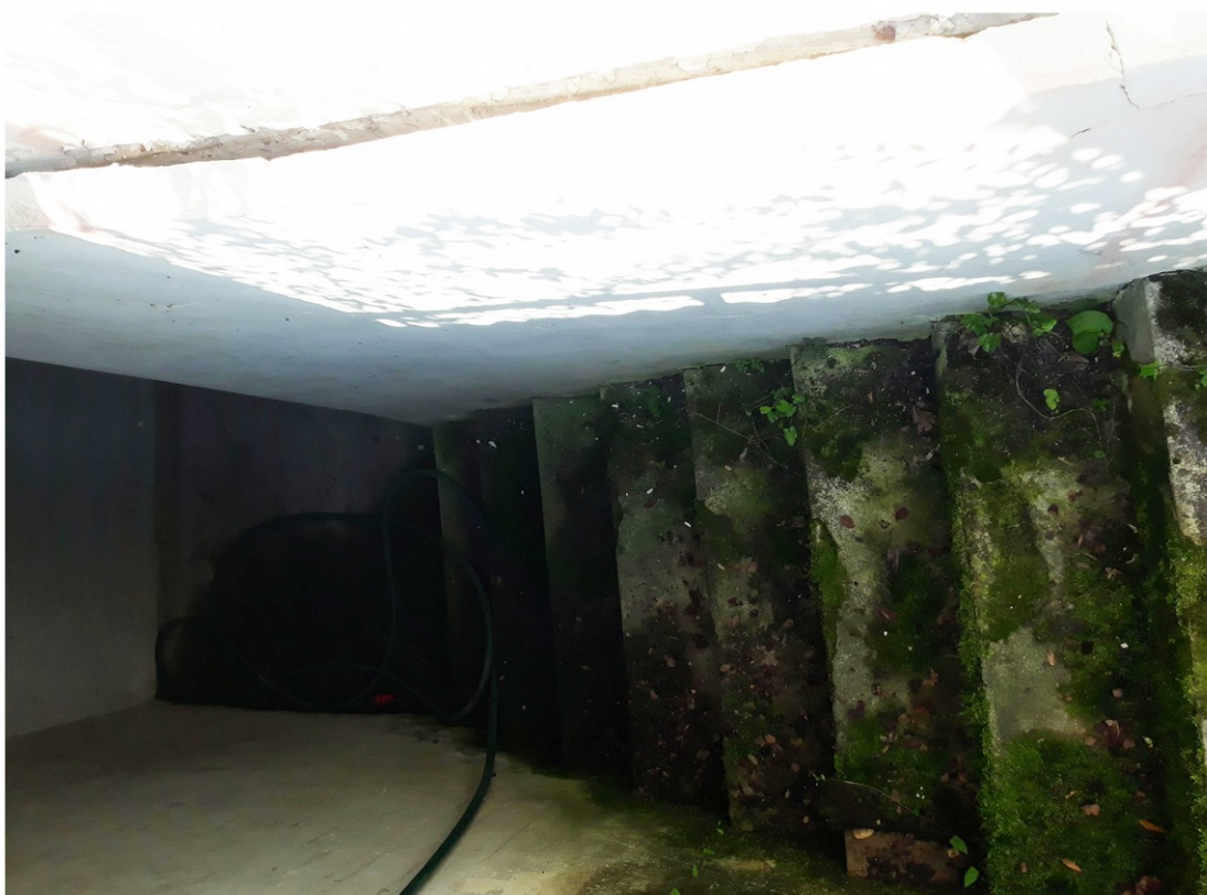
Odchodzący tynk ochronny fundamentów i schody zewnętrzne do piwnicy , sierpień 2018r.
