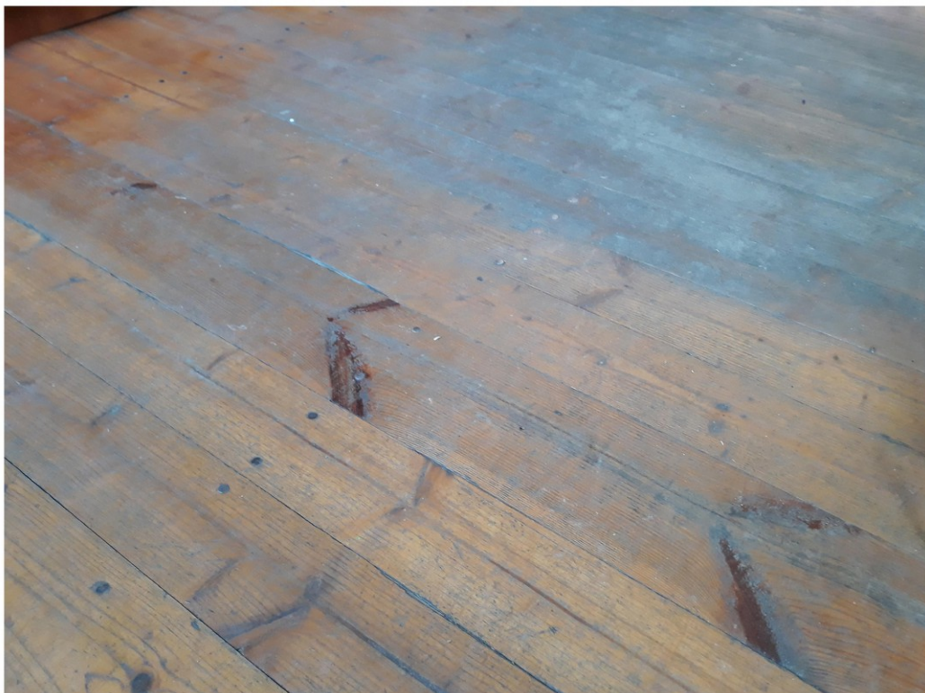
zły stan drewnianych podłóg w całym domu, sierpień 2018 r
