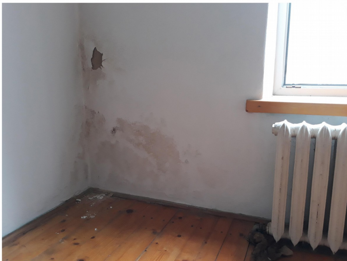
pokoje mieszkalne: zagrzybiałe ścianom zawilgocone z odpadającym tynkiem, sierpień 2018 r
