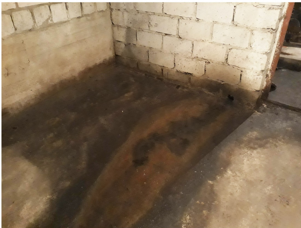
piwnica: zalegająca woda na posadzce, sierpień 2018 r
