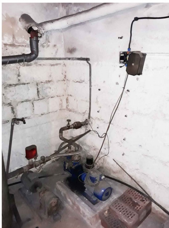
kotłownia: pompa hydroforu, sierpień 2018 r
