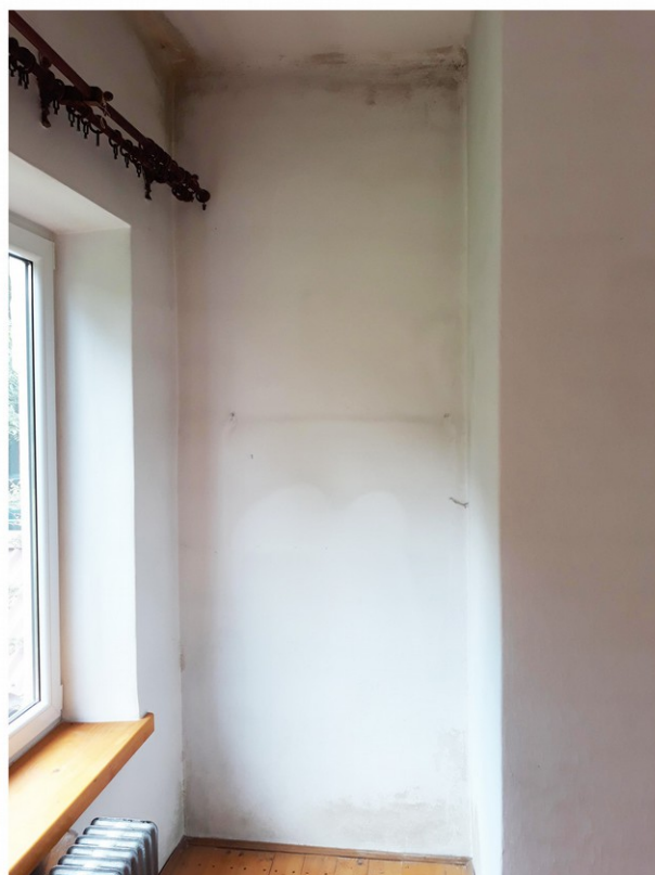
zagrzybenie ścian z destrukcją tynków wewnętrznych w pokoju nr 5, sierpień 2018r.
