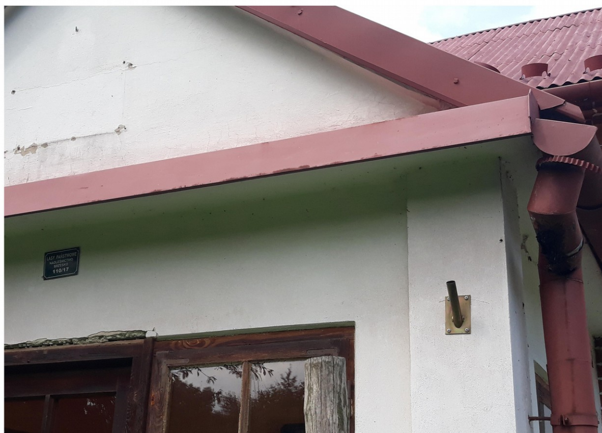
Dziurawe, oberwane orynnowanie i ubytki tynku przy stolarce zewnętrznej , sierpień 2018r.
