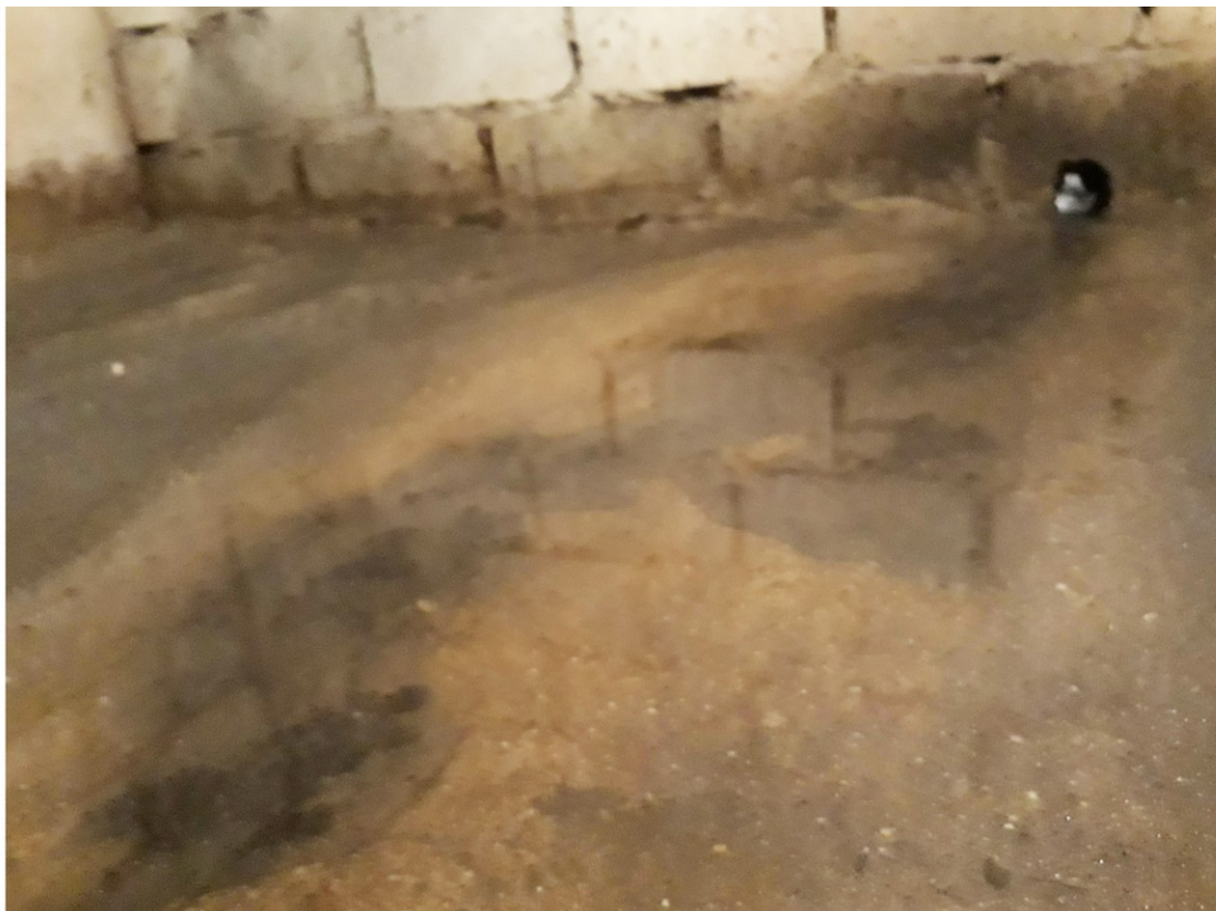
piwnica: zalegająca woda na posadzce, sierpień 2018 r
