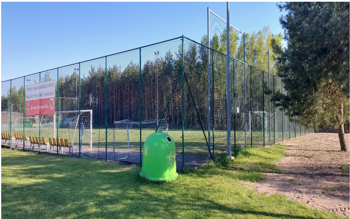
Rys. 26. Istniejące ogrodzenie orlika, do którego należy nawiązać nowe ogrodzenie infrastruktury sportowej.
