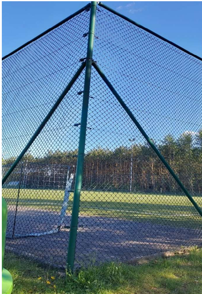
Rys. 27. Istniejące ogrodzenie orlika, do którego należy nawiązać nowe ogrodzenie infrastruktury sportowej.
