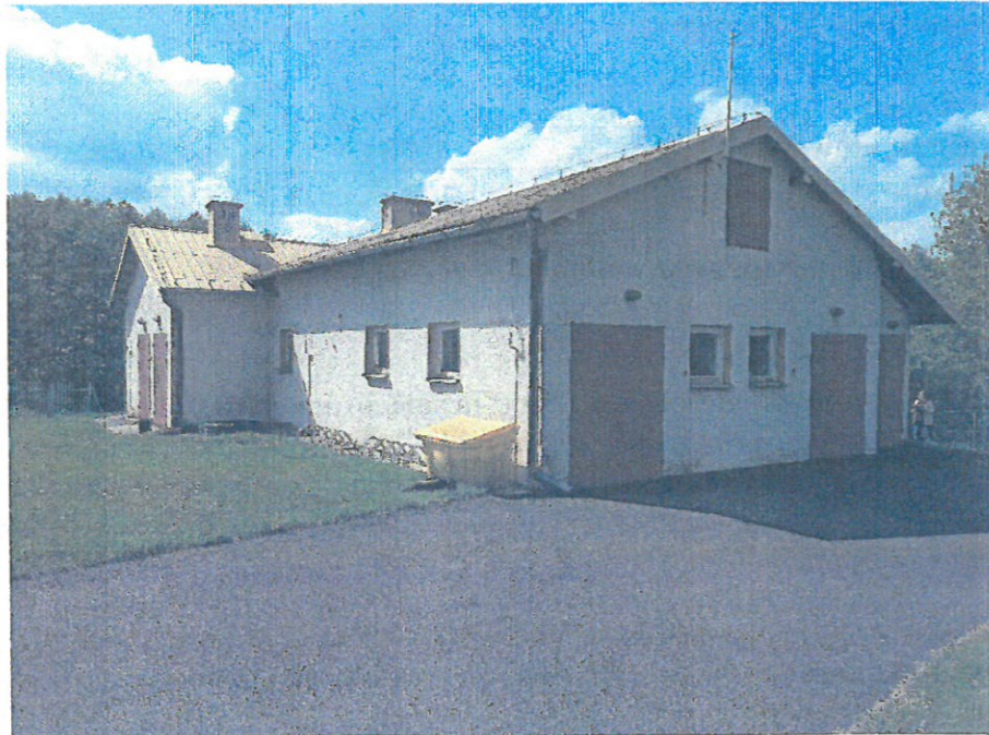
Fot.1 Widok przedmiotowego budynku, z terenu inwestycji
