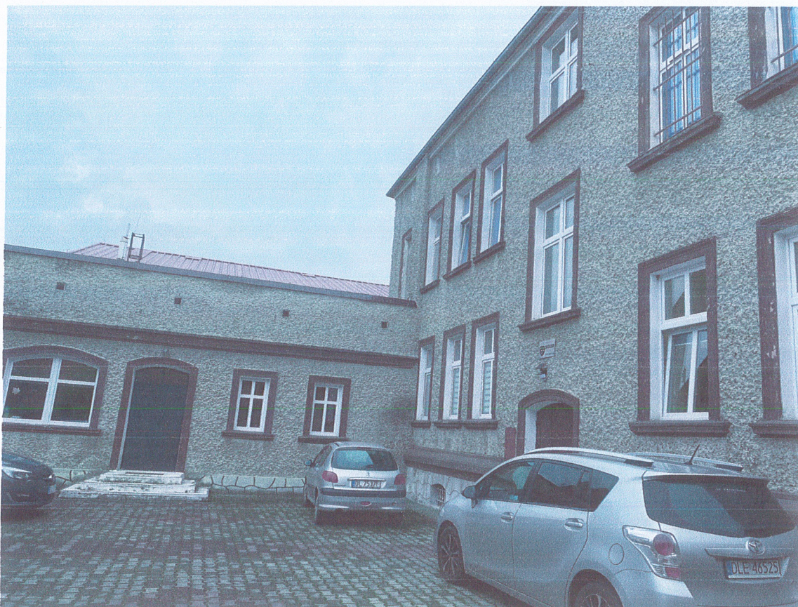
Widok na elewację tylną szkoły i część budynku łącznika (niższy budynek).
