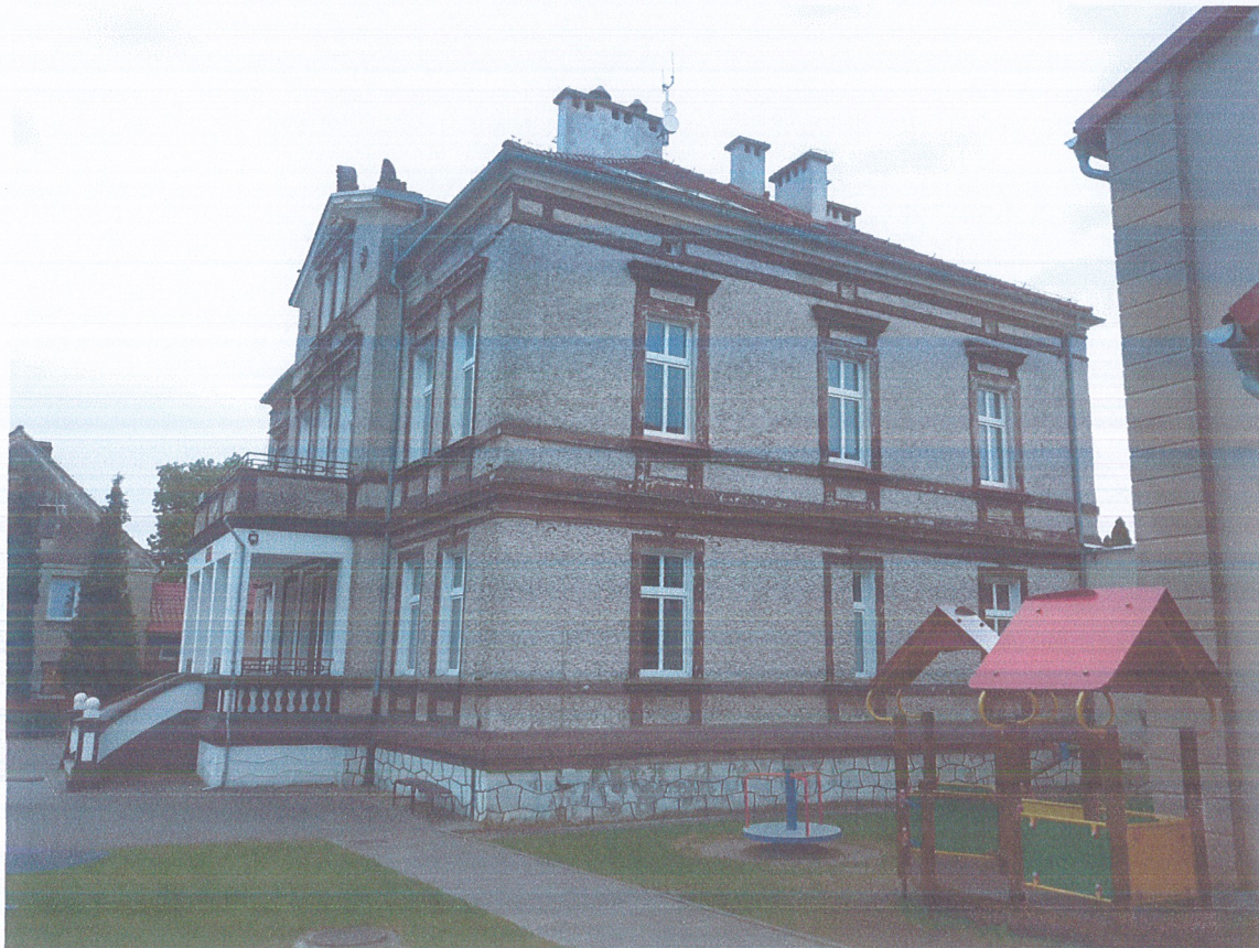
Widok na elewację boczną zachodnią budynku szkoły.
